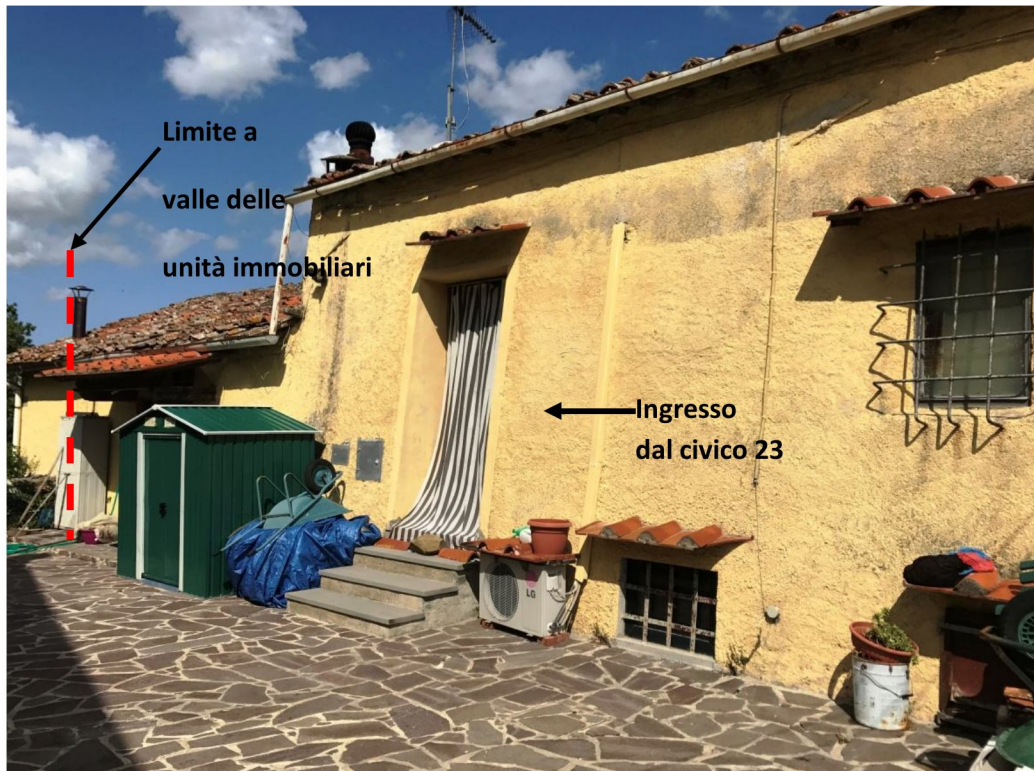
Foto 1 Vista esterna delle unità immobiliari dal resede esterno
