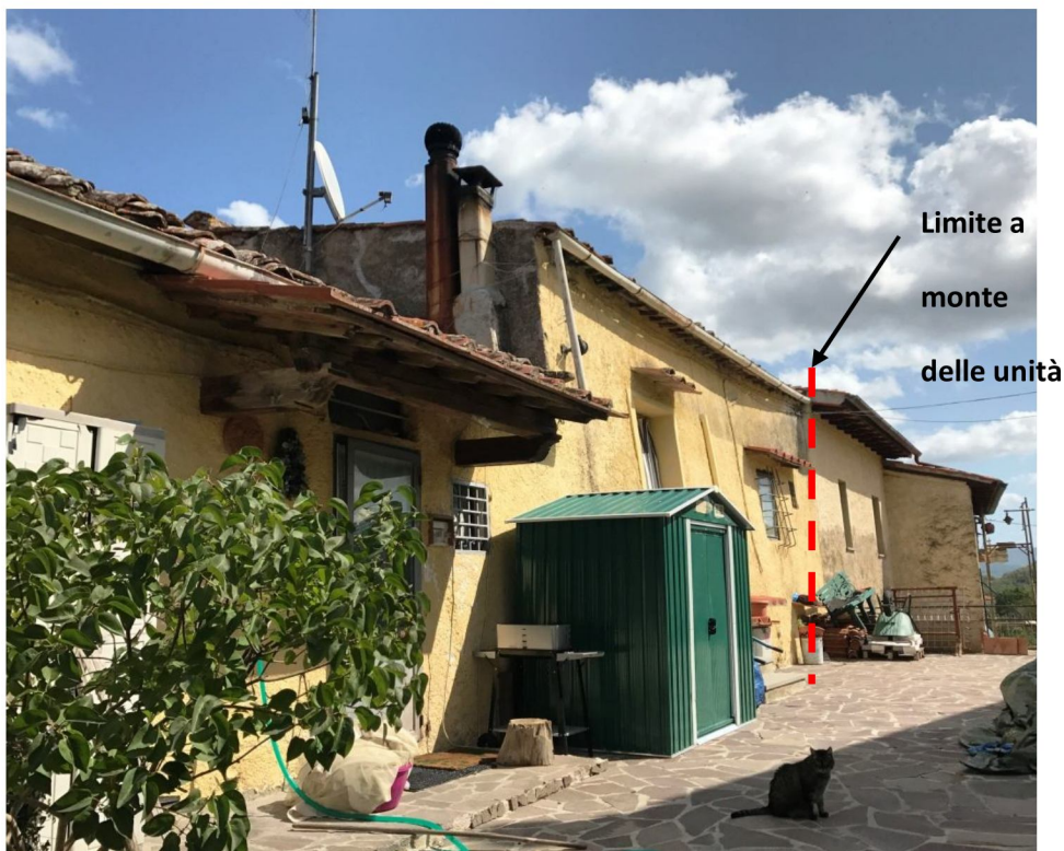
Foto 2 Vista esterna delle unità immobiliari dal resede esterno
