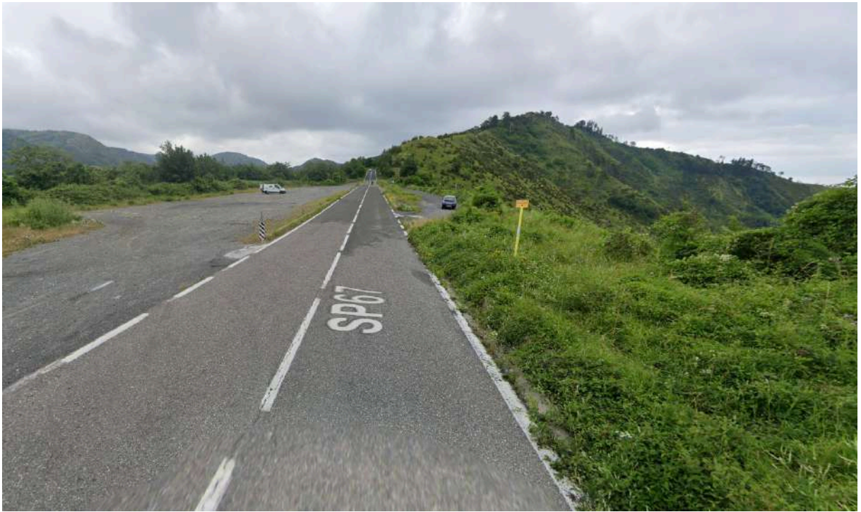
FOTO 7 – Strada provinciale del Monte Fasce
