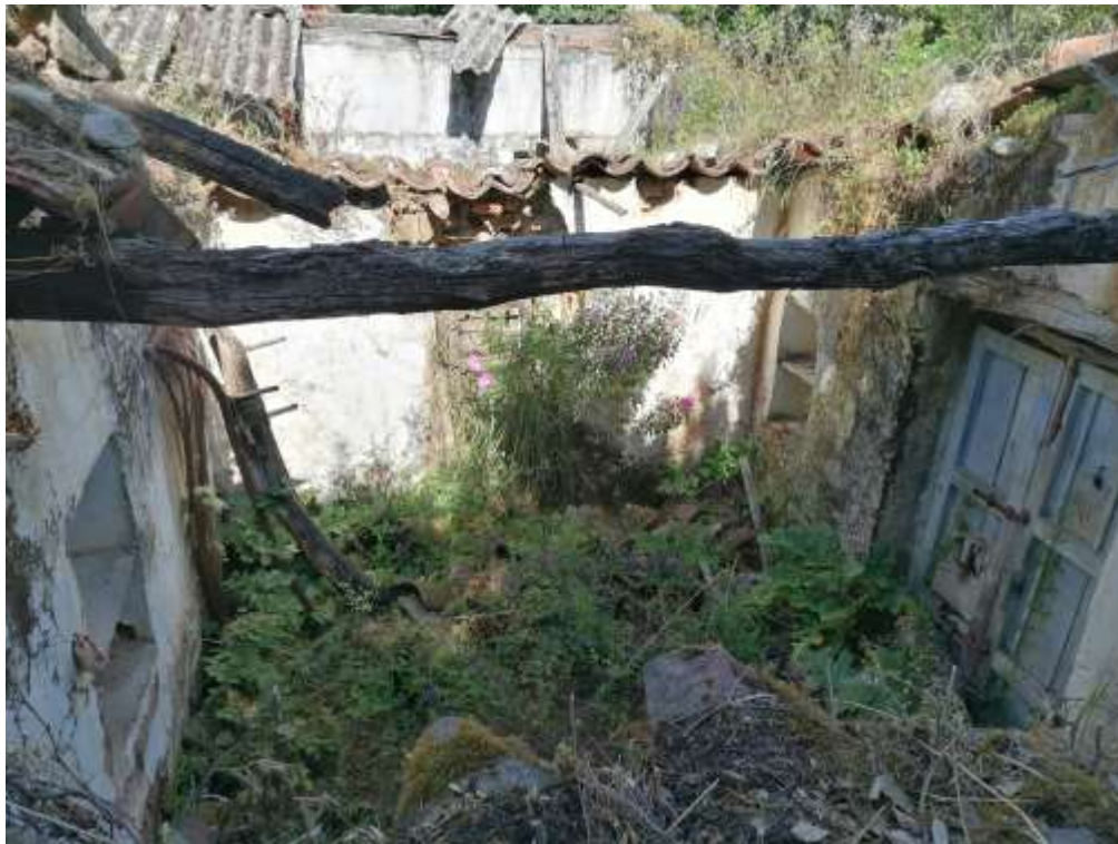
VISTA INTERNO CUCINA
