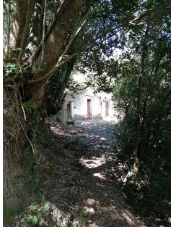
INGRESSO AL FABBRICATO
