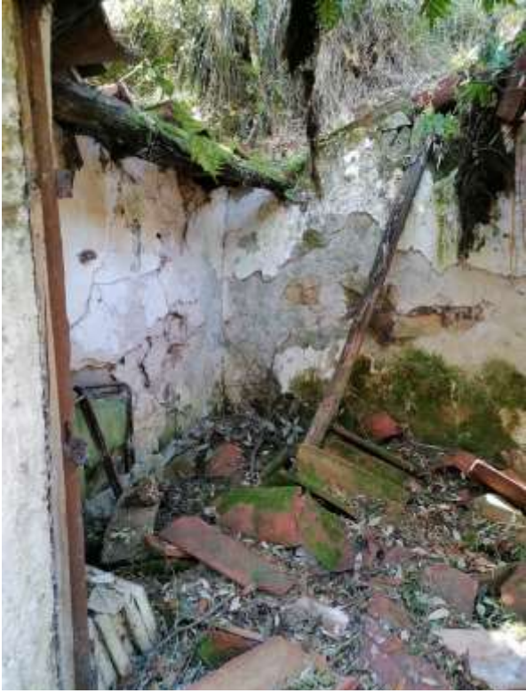
VISTA INTERNO W.C.
