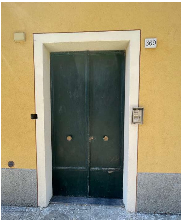
FOTO 5 – Dettaglio portone accesso civ. 369 – LOTTO 3 e LOTTO 4
