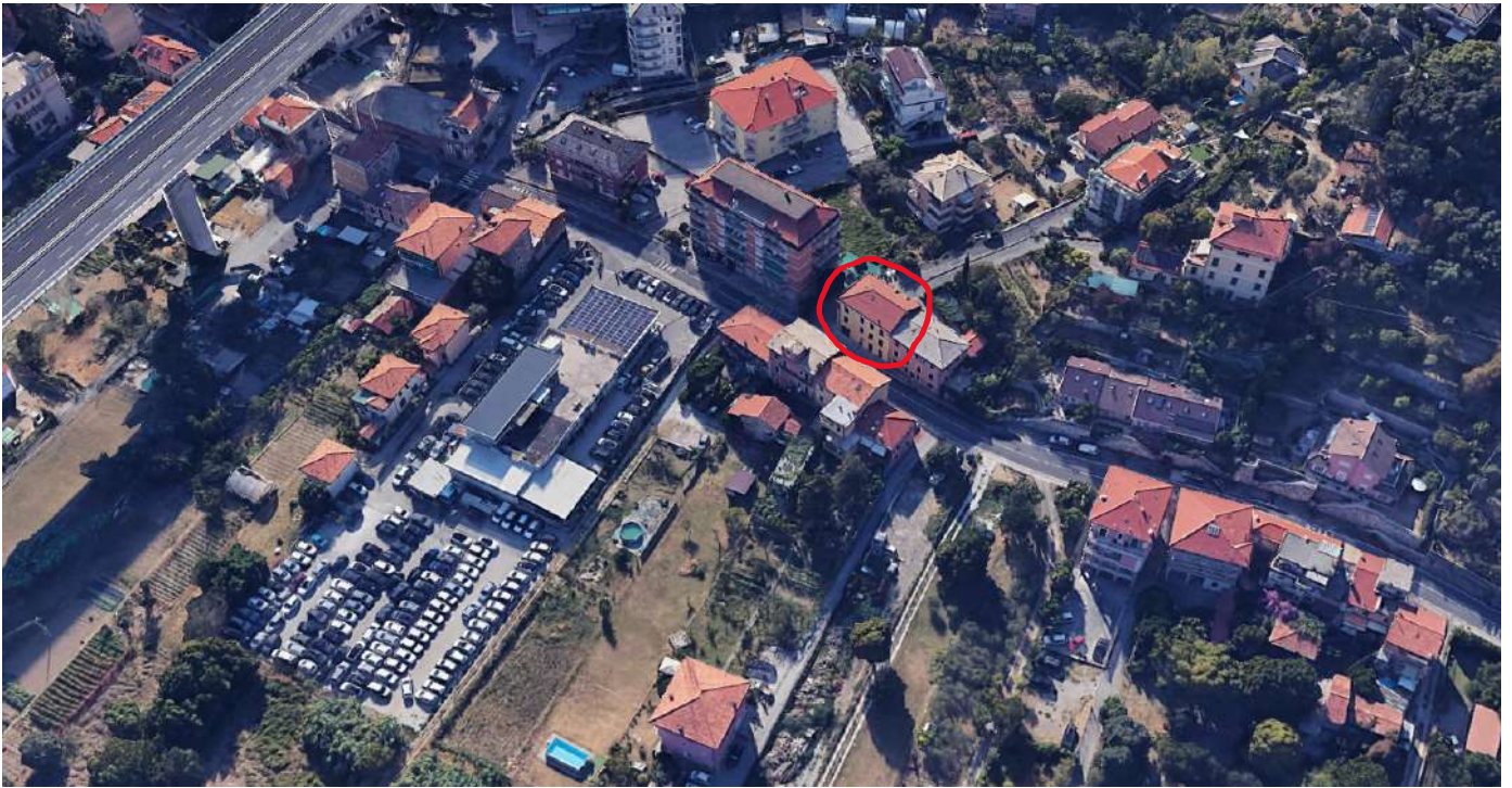
FOTO 5 – Vista dall'alto edificio – prospetto est
