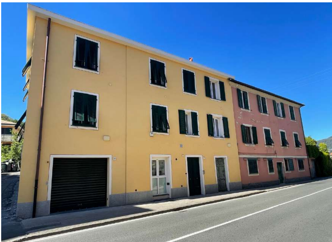
FOTO 2 – Vista edificio su Via Piacenza
