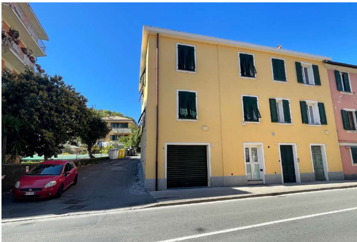
FOTO 3 – Vista edificio su Via Piacenza e Salita Privata Copello
