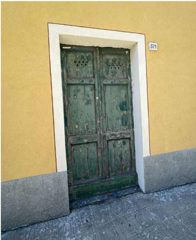
FOTO 7 – Dettaglio portone accesso civ. 371 – LOTTO 3
