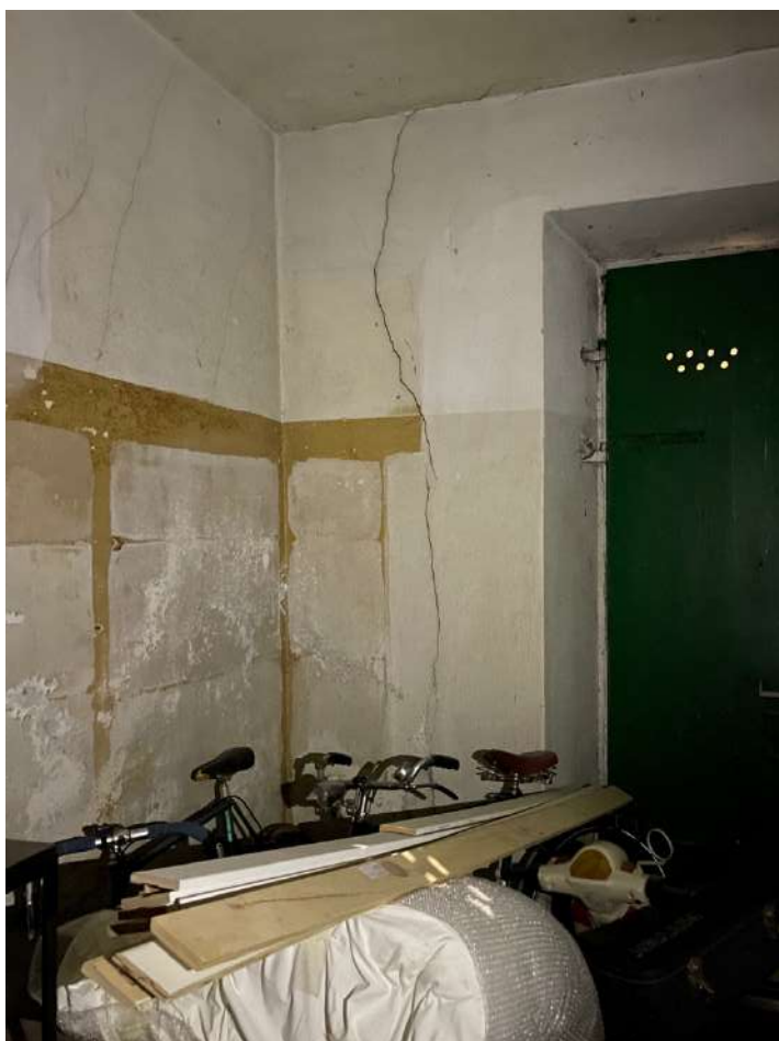
FOTO 2 – dettaglio fessurazione
