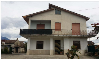
Foto n. 1 BENE FG.38 PART. 661 Sub.1 Piano Terra - Sub.2 Piano Primo;
