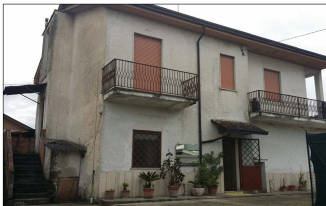
Foto n. 2 BENE FG.38 PART. 661 Sub.1 Piano Terra - Sub.2 Piano Primo;
