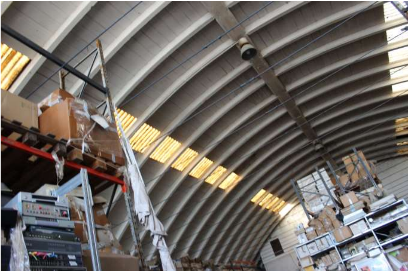
Particolare della copertura (sub 12) sullo sfondo una finestra del piano uffici
