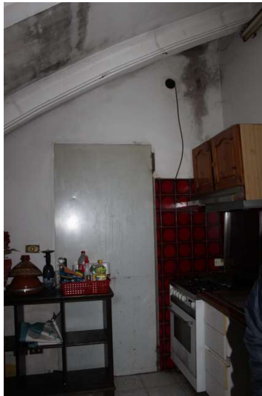
Porzione affaccio interno capannone (magazzino)
