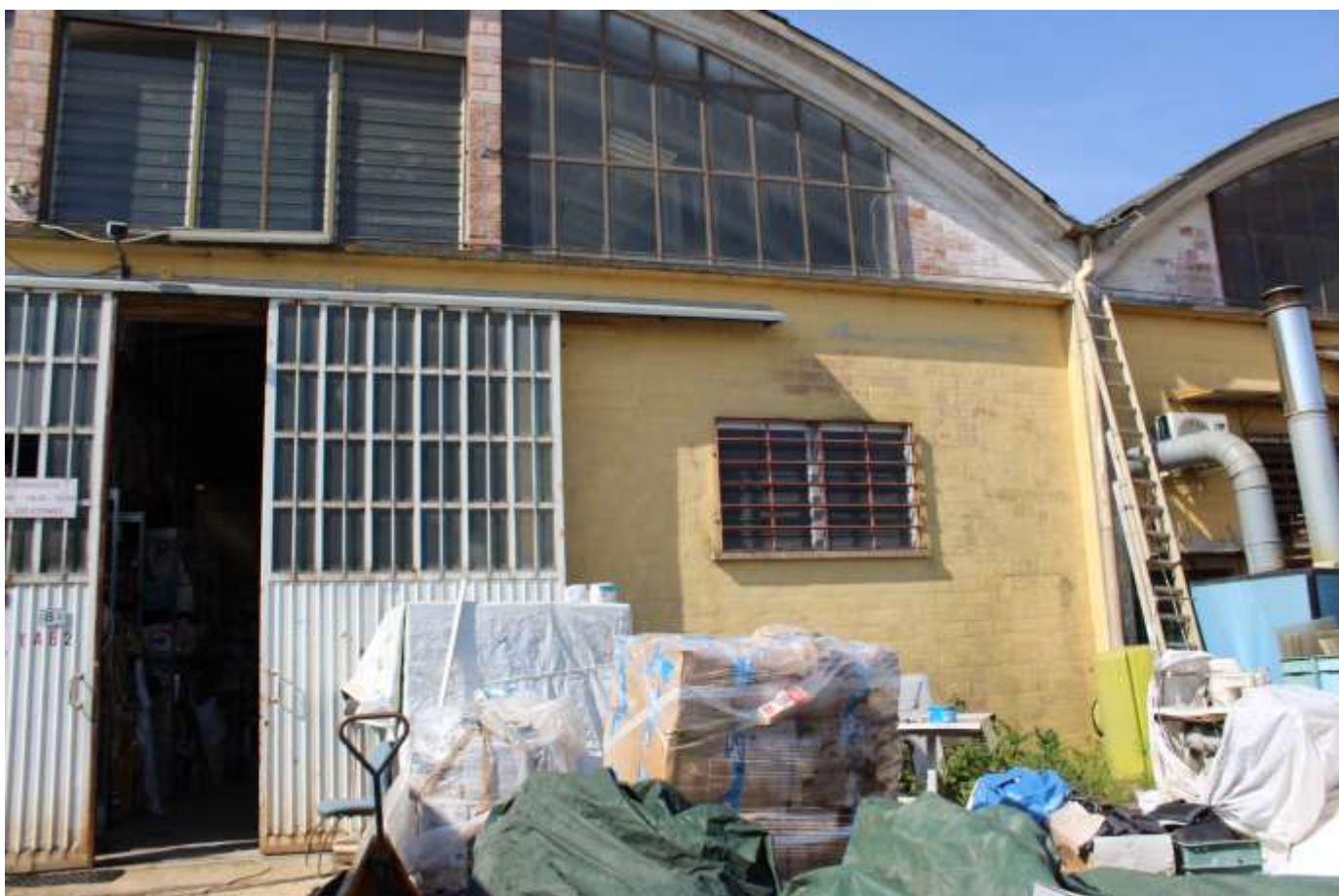
Accesso magazzino sub 12 (via Malvezza n.8/A)
