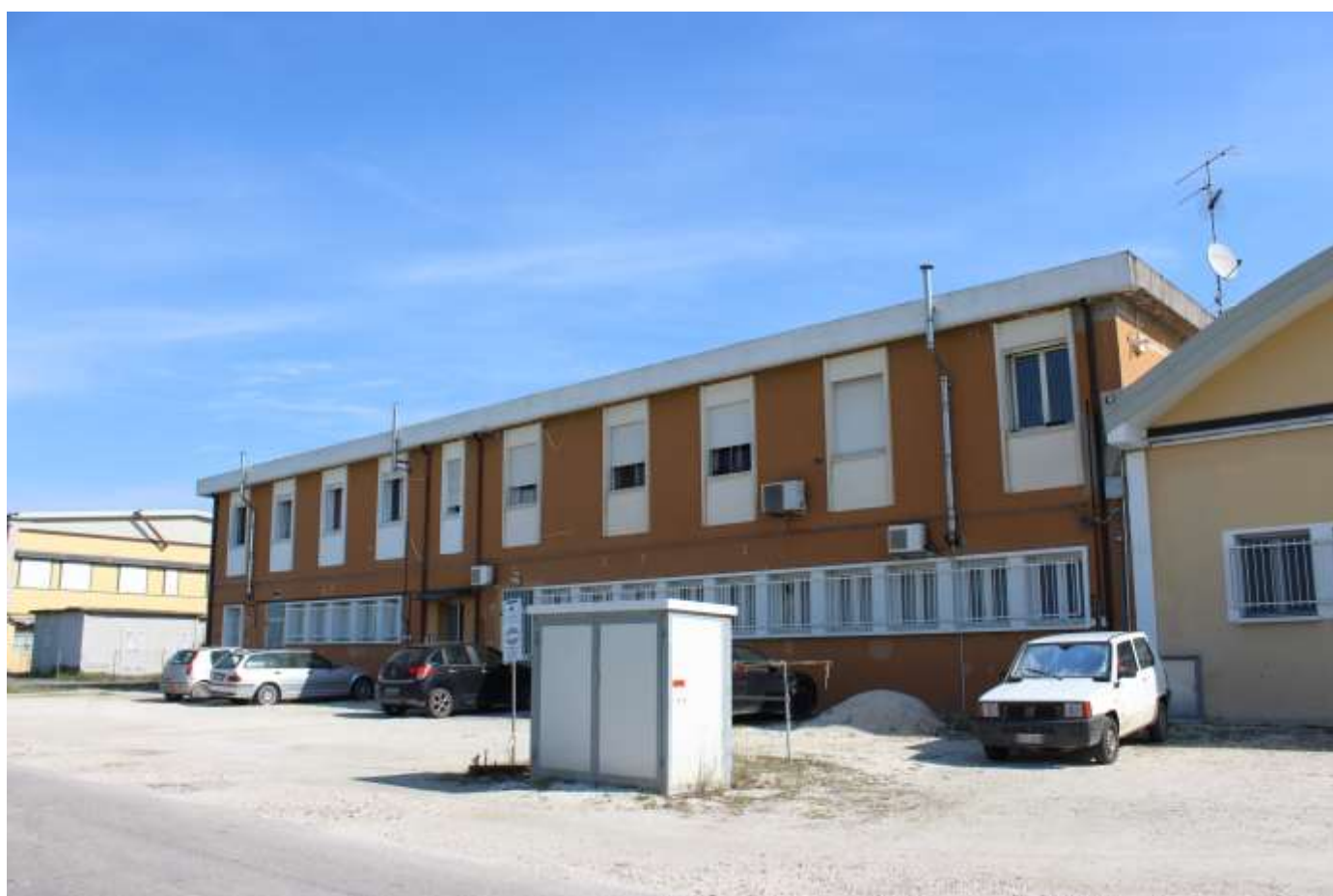
Il complesso edificato: prospetto principale via Malvezza
