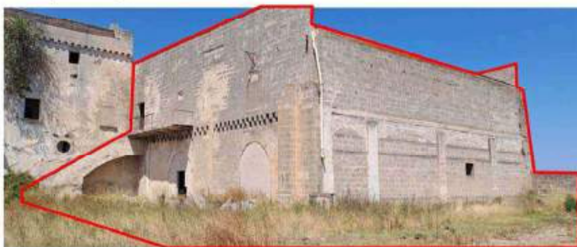
Vista d'insieme fronte principale sud est fabbricato collabente su particella 586
