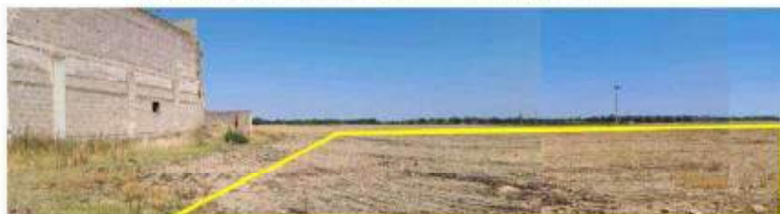
Foto d'insieme particella 595 suolo di risulta collabente non più esistente
