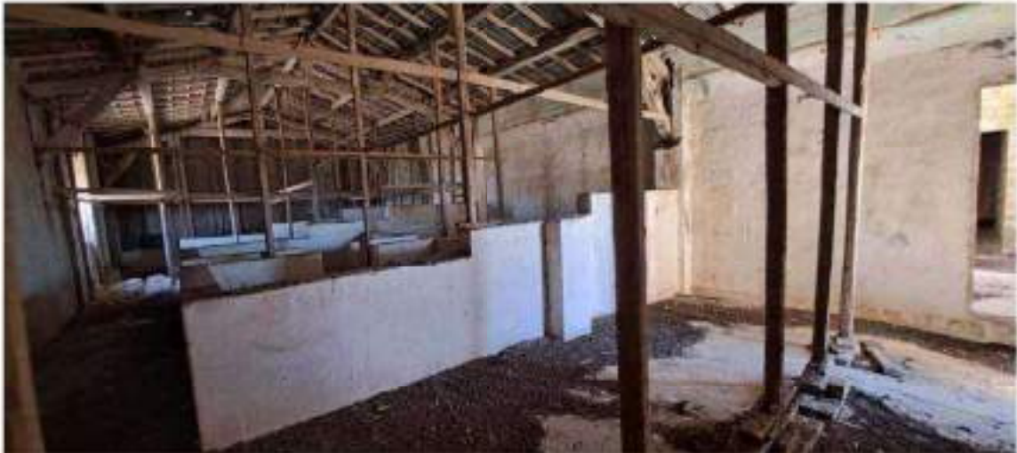
Corpo A: P1° Campata destra in ingresso
