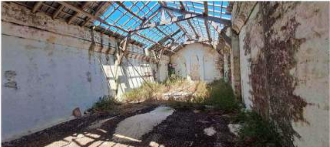
Corpo A: P1° Campata centrale
