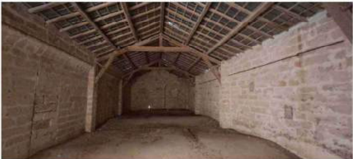
Corpo A: P1° Campata destra
