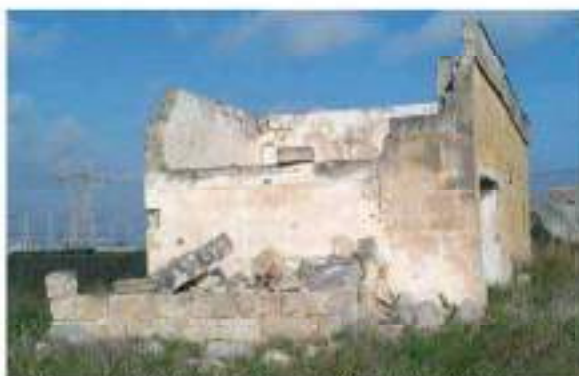
Foto scorcio fabbricato - Ripresa da Sud della P.Illa 409
