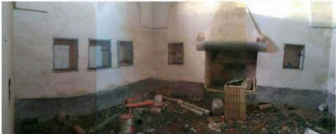
Corpo B: Vano/2B
