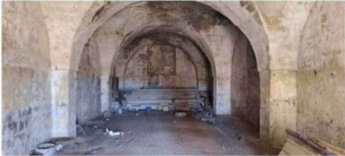
Corpo A: PT Campata centrale in ingresso
