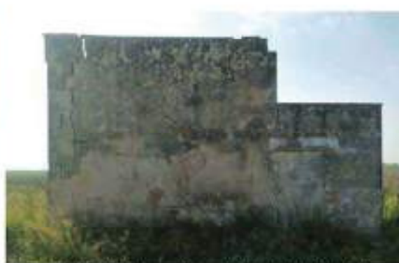
Foto fronte fabbricato - Ripresa da Nord della P.Illa 409
