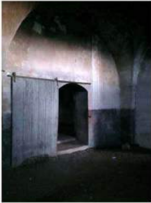
Corpo B : Ingresso da Corpo A
