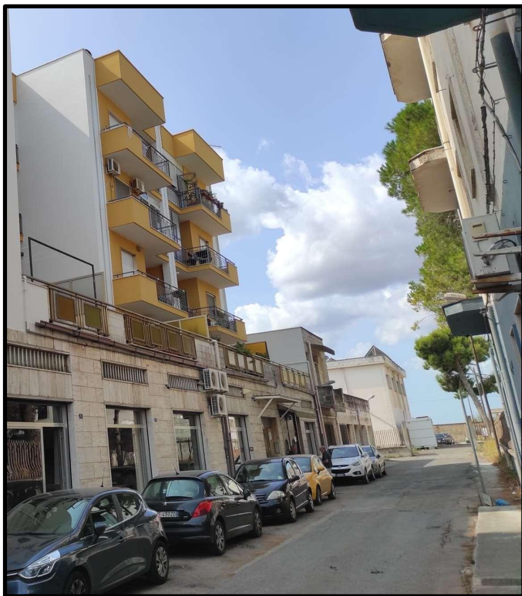
Ingresso Principale – Lotto 1 – via F. Palasciano
