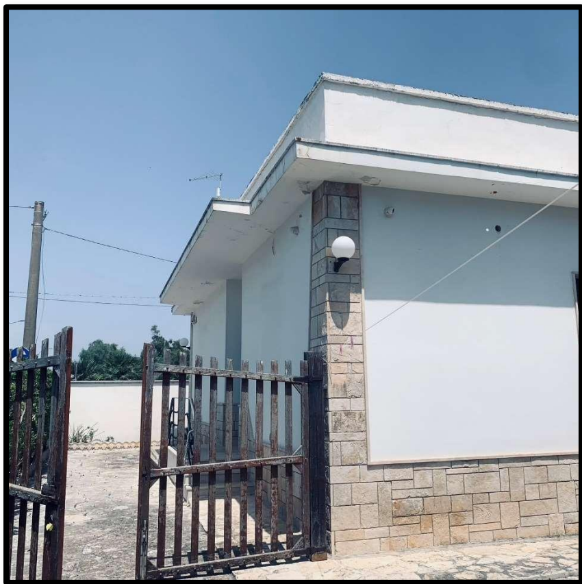
Vista Esterna – Vista Sud - lotto 3
