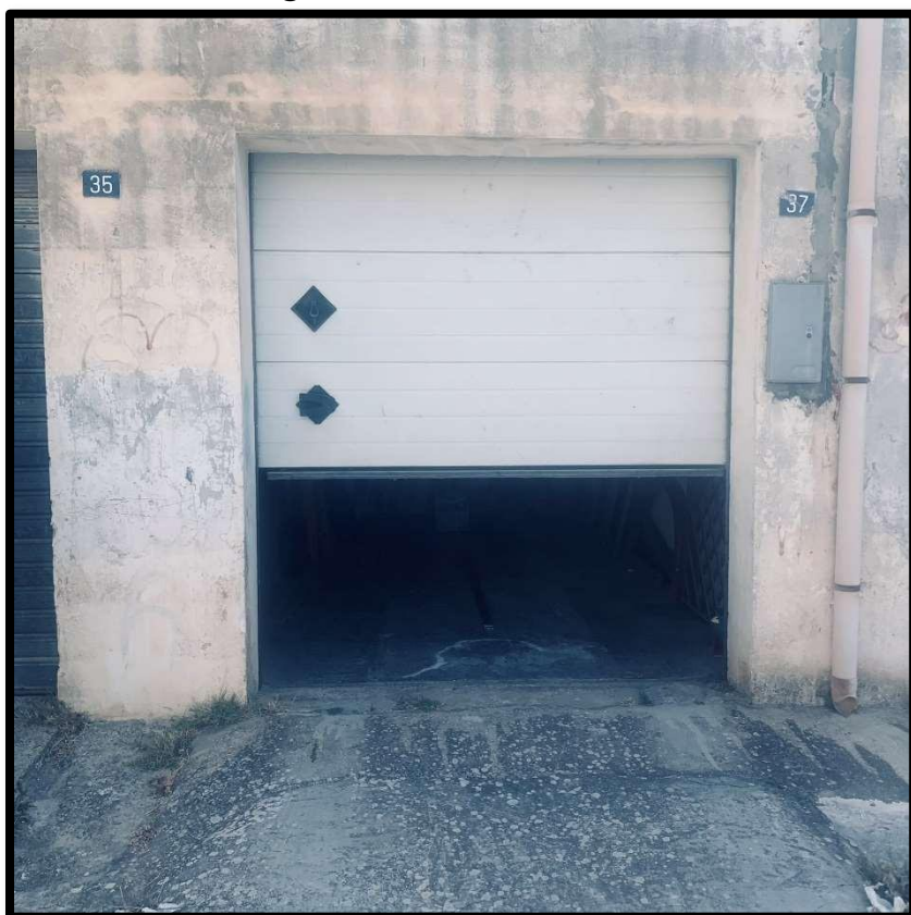
Vista esterna – Ingresso al box singolo - lotto 2
