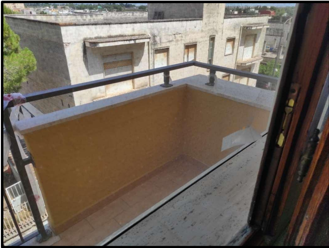
Vista esterna - Balcone - lotto 1
