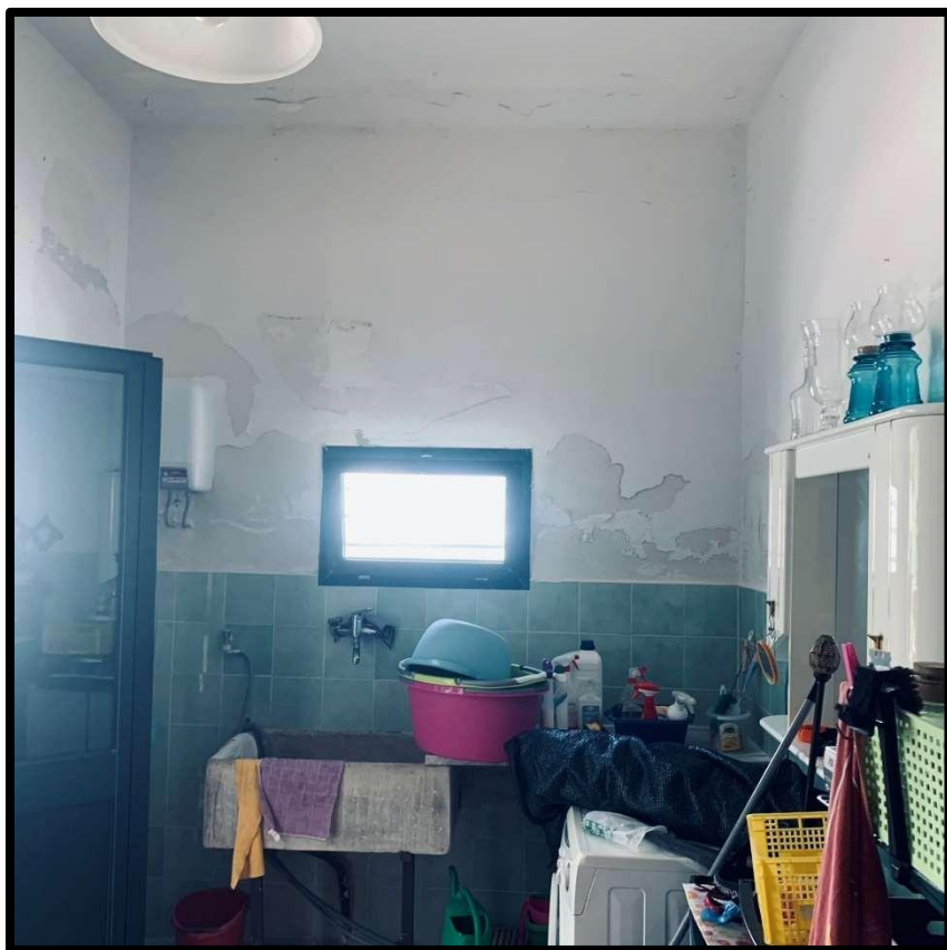
Vista Interna – Lavanderia - lotto 3
