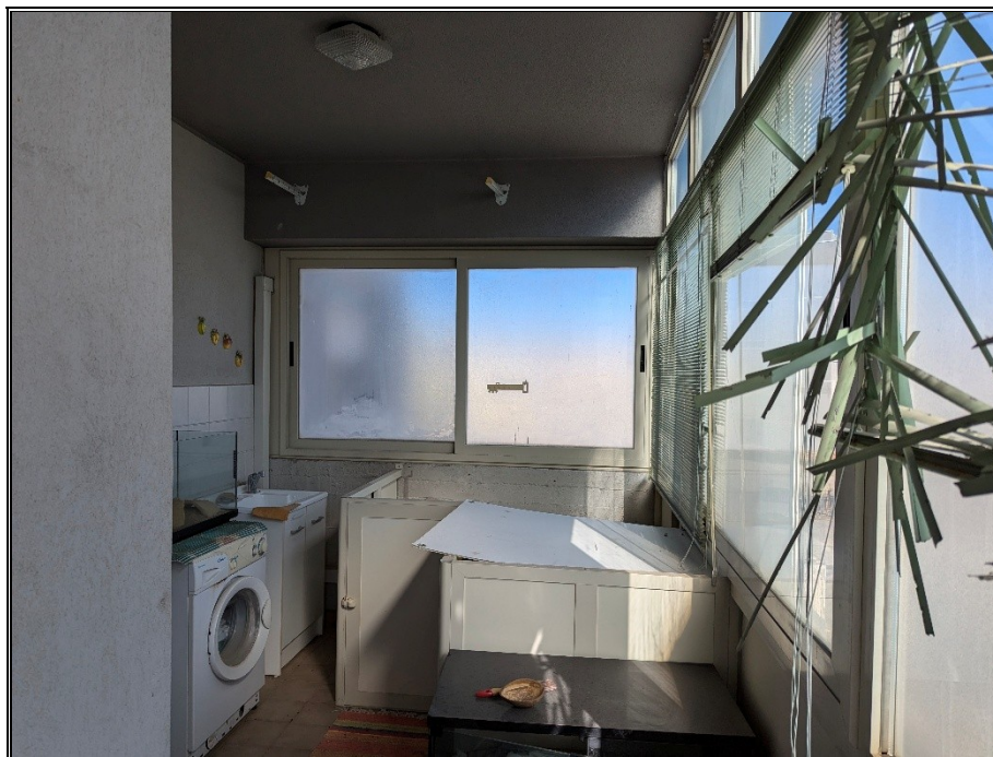
Foto n° 12 – Ballatoio 1 chiuso con struttura metallica
