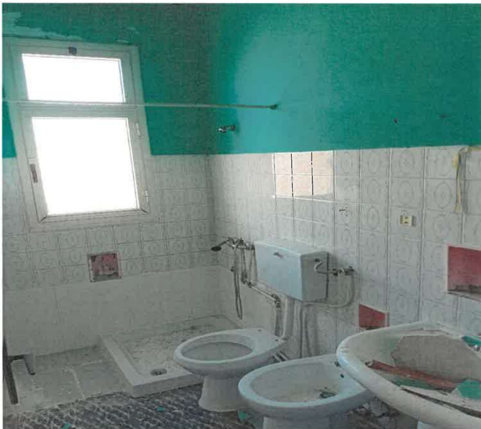
Foto n.ro 30 : il locale bagno
