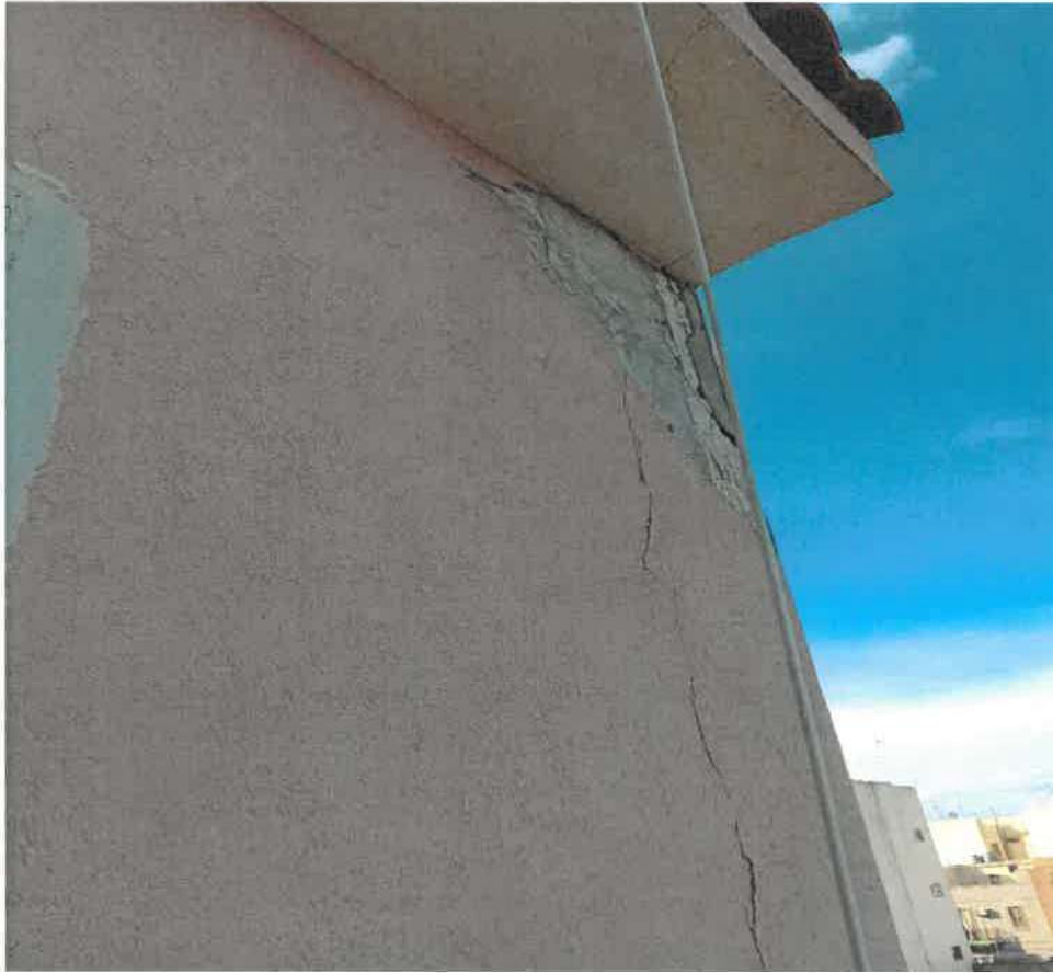
Foto n.ro 41 pilastro d'angolo del soggiorno
