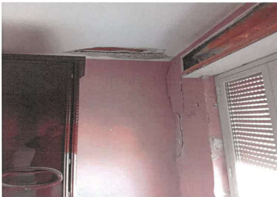
Foto n.ro 15 . dettagli salone , confine nord
