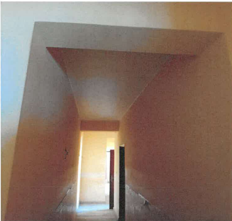
Foto n.ro 38 : dettagli travi in c.a. corridoio
