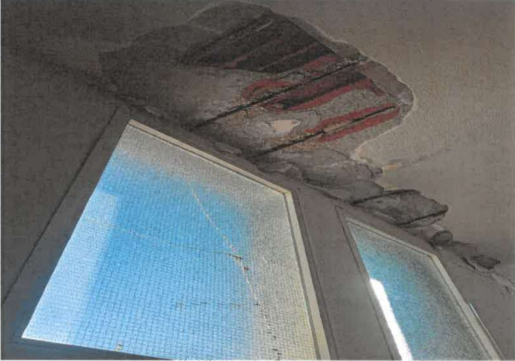
Foto n.ri 9-10 – torrino di accesso locale terrazzo( vista interna dal corpo scale ) condominiale e piano terrazzo condominiale
