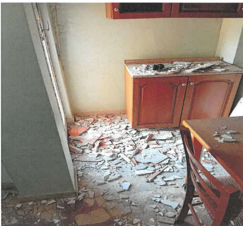
Foto n.ri 24-25 : altri dettagli locali cucina e particolari distacchi di intonaco dal soffitto
