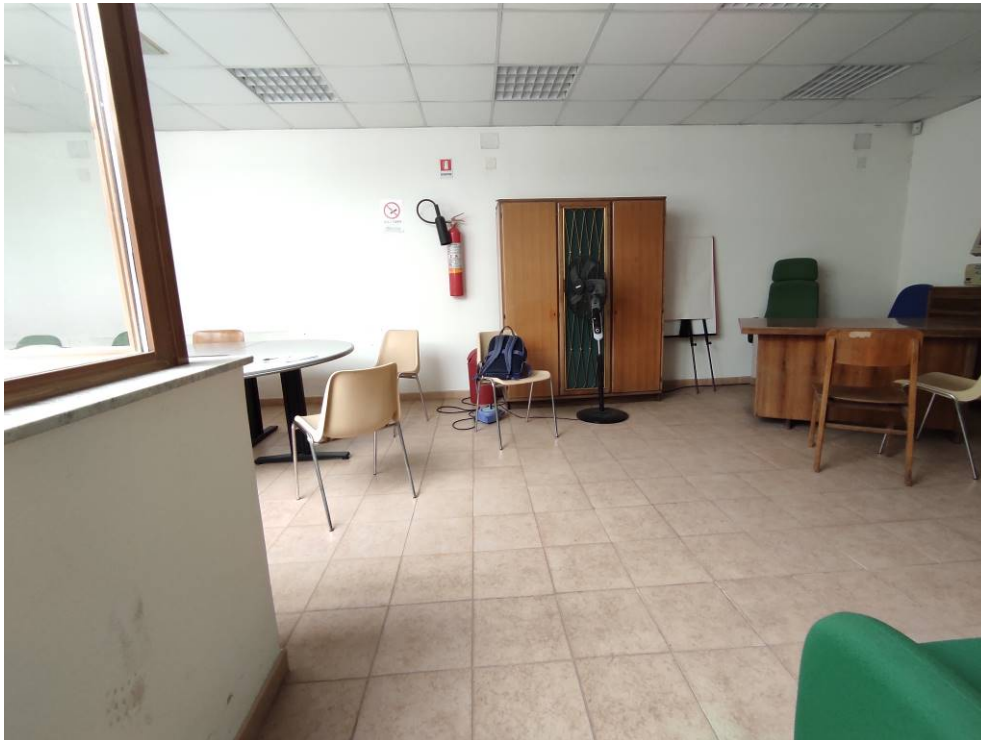
Foto 21 - Immobile di cui al Sub. 16, sottotetto 02
