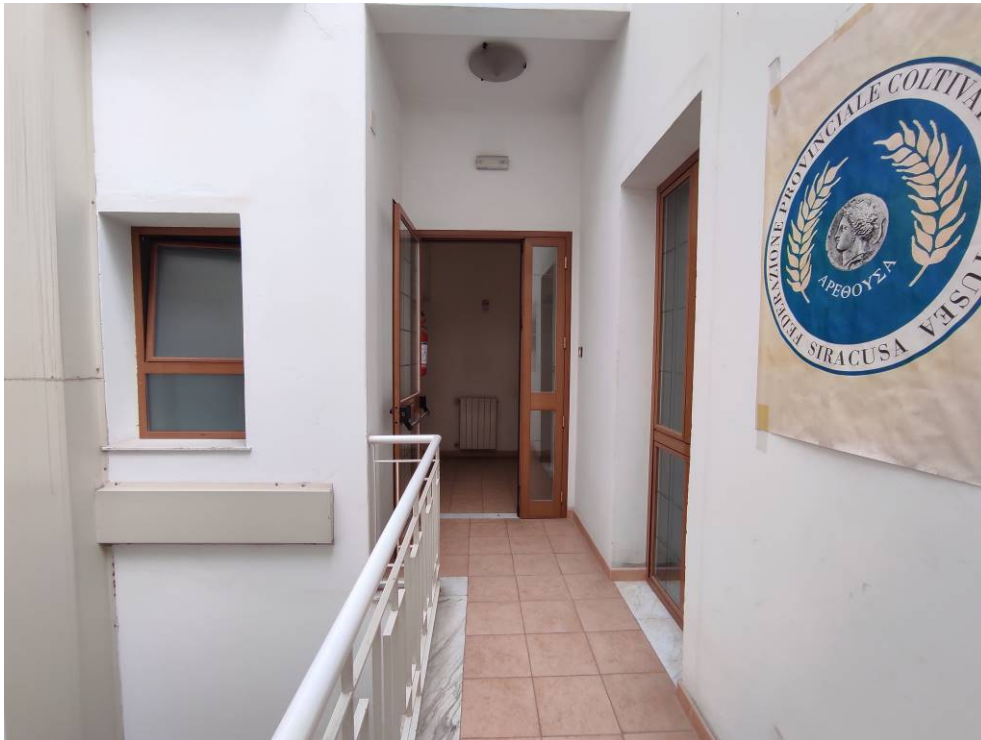
Foto 13 – ballatoio primo piano
