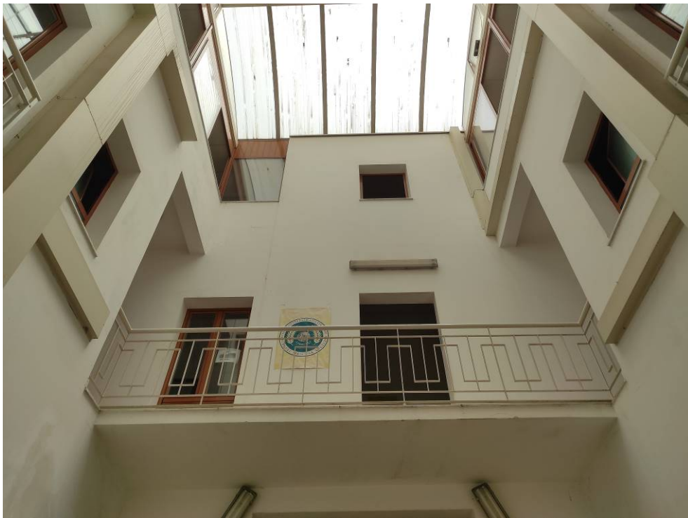
Foto 12 – ballatoio primo piano e copertura in lastre di policarbonato
