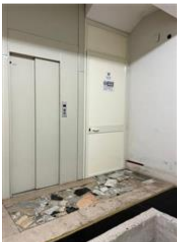
accesso a vano ascensore
