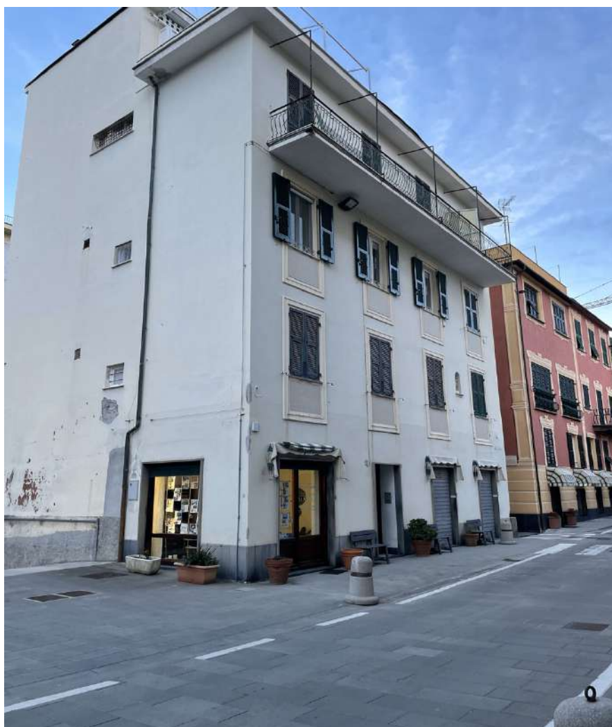
FOTO 2 – Vista edificio civ. 7 di Via Brigate Partigiane in cui si trova al P.T. il bene 1
