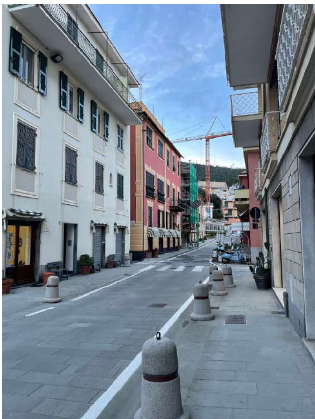
FOTO 3 – Vista di Via Brigate Partigiane
