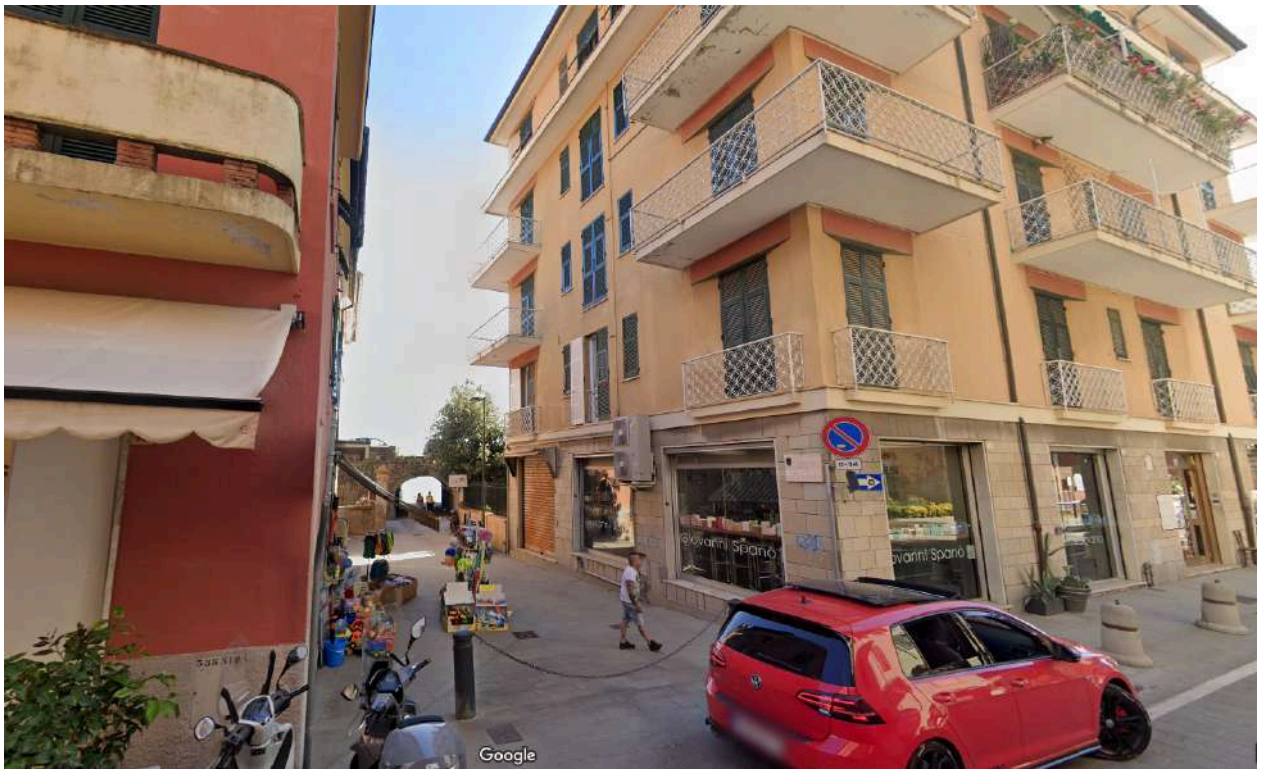
FOTO 5 – Vista del sottopasso di Via alla Spiaggia
