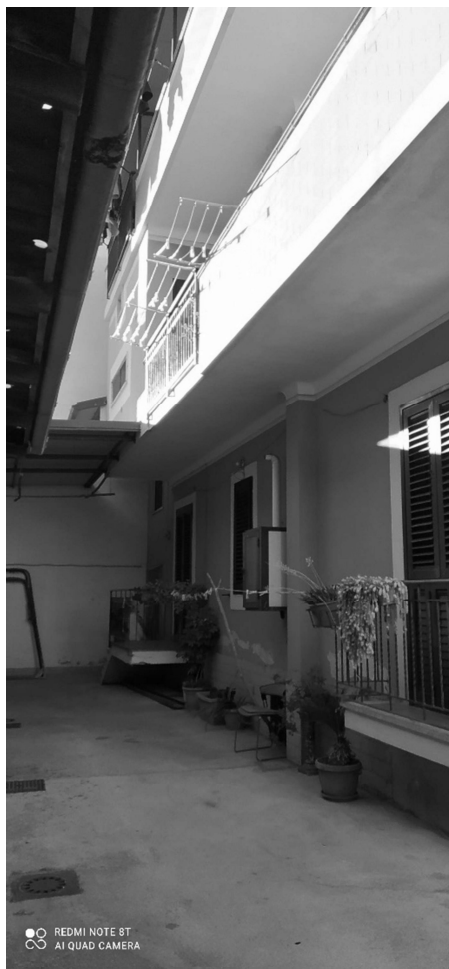
Foto 7 balcone cucina con scala
