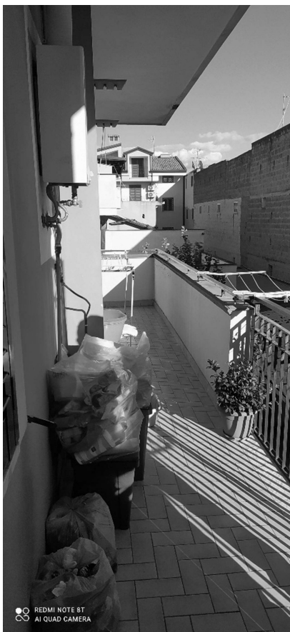
Foto 16 balcone piano primo
