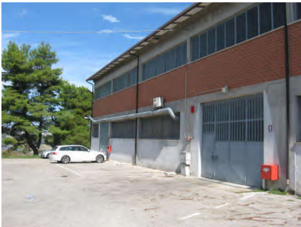
DOCUMENTAZIONE FOTOGRAFICA LABORATORIO LATO OVEST
