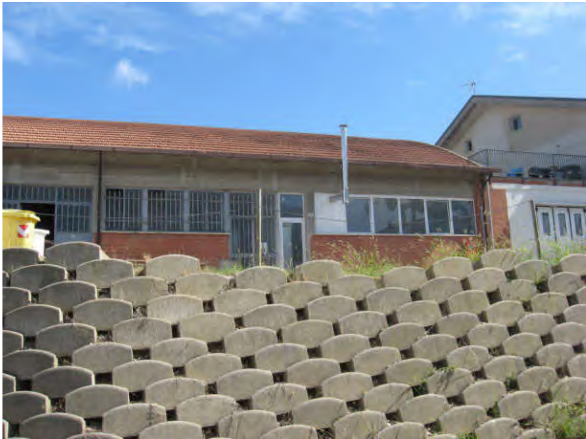
DOCUMENTAZIONE FOTOGRAFICA LABORATORIO LATO OVEST
