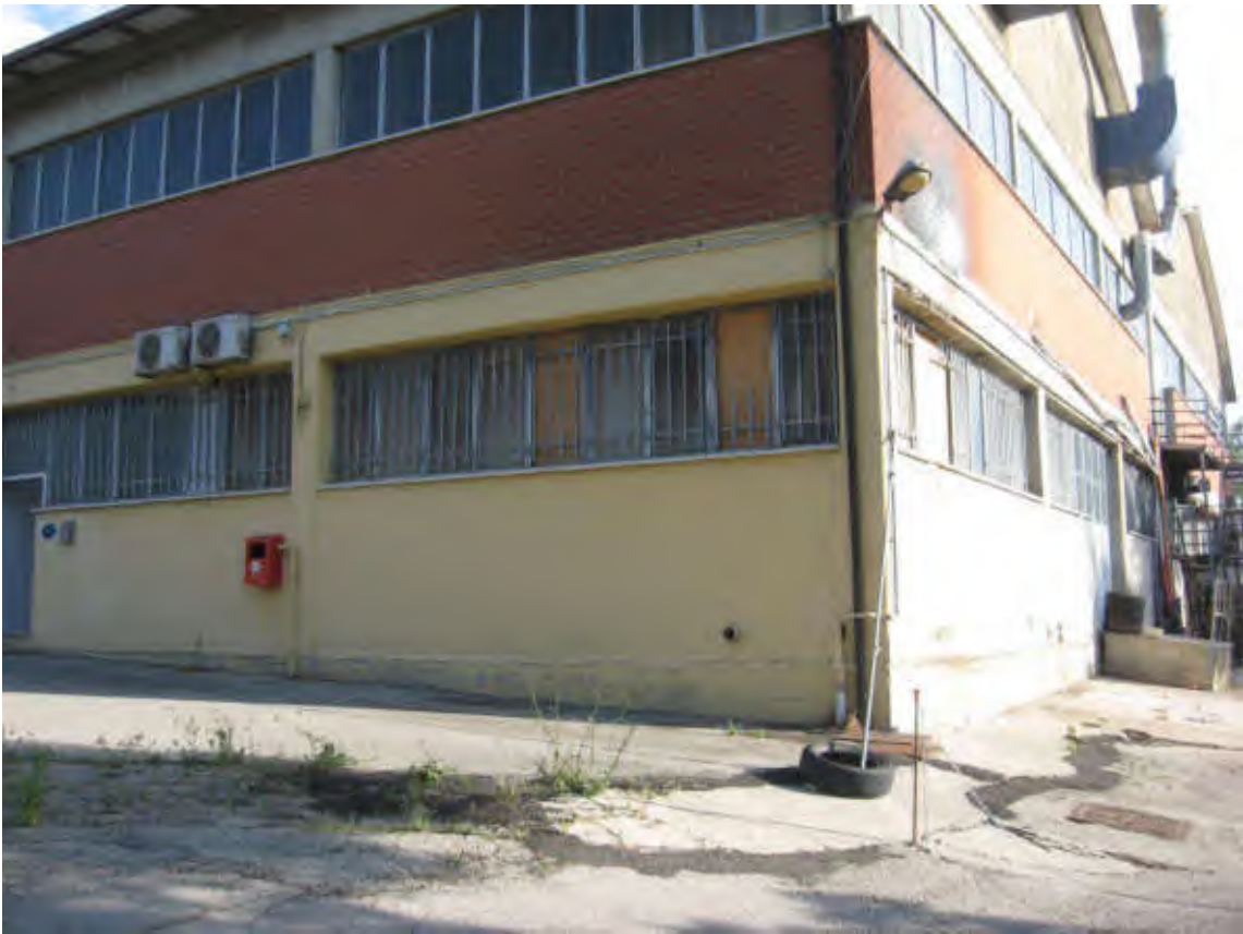
DOCUMENTAZIONE FOTOGRAFICA LABORATORIO LATO EST
