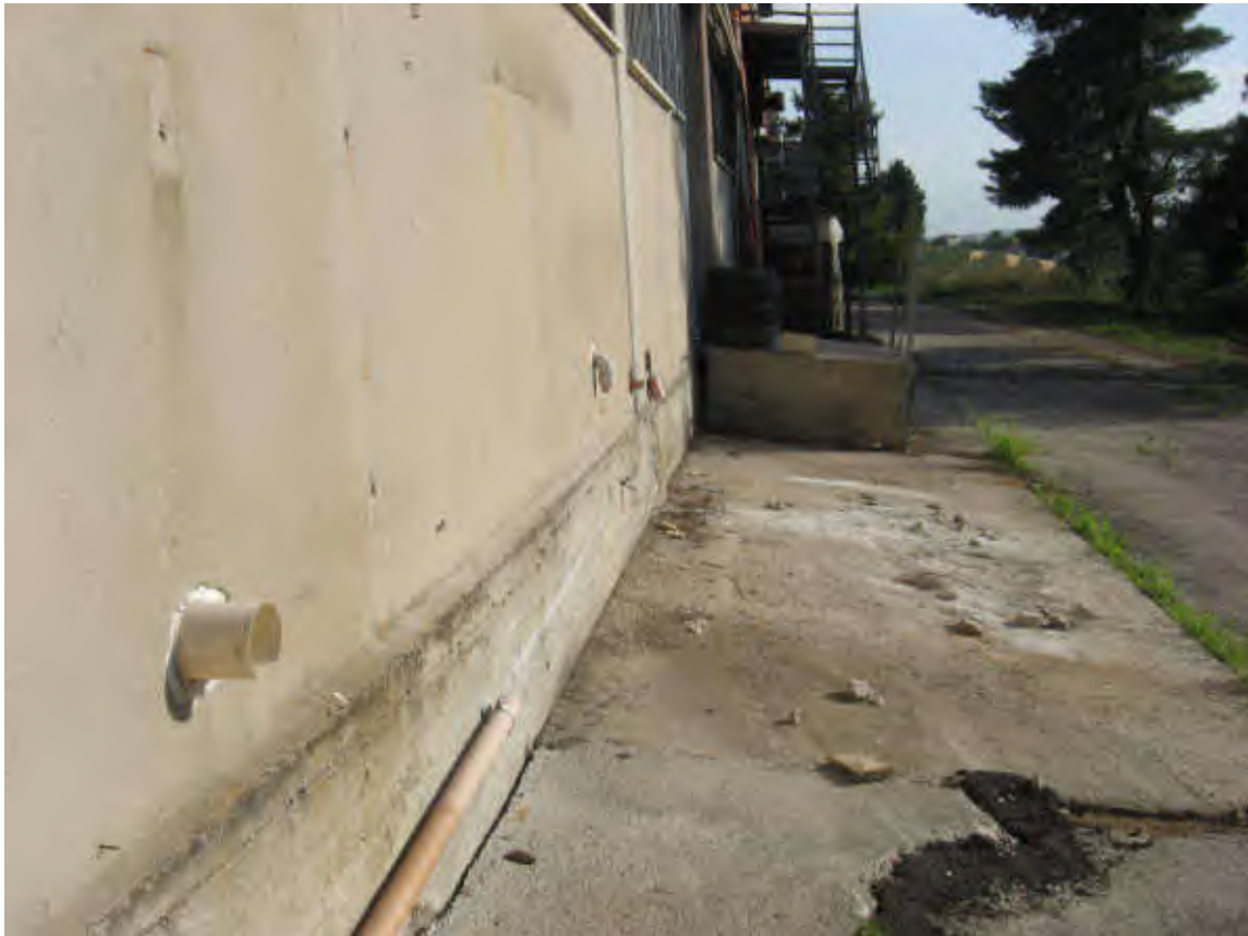
DOCUMENTAZIONE FOTOGRAFICA LABORATORIO LATO NORD
