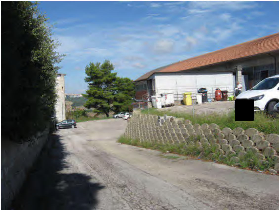
DOCUMENTAZIONE FOTOGRAFICA LABORATORIO LATO OVEST
