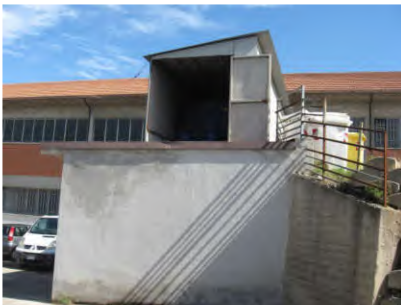
STRUTTURA “ NON AUTORIZZATA ” DA REGOLARIZZARE
