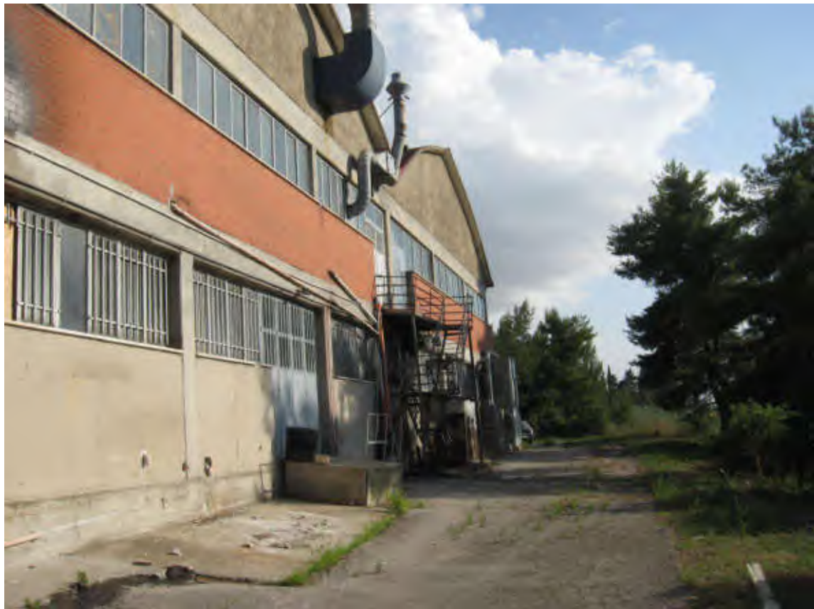
DOCUMENTAZIONE FOTOGRAFICA LABORATORIO LATO NORD
