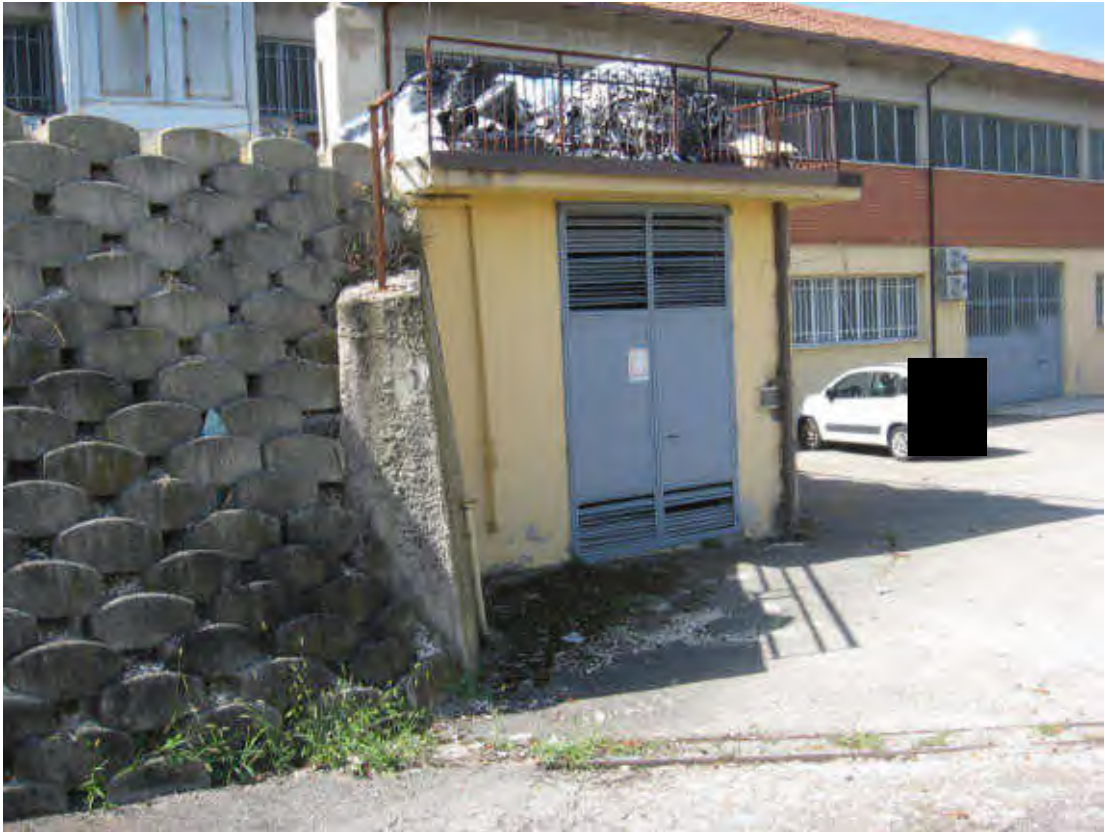
DOCUMENTAZIONE FOTOGRAFICA LABORATORIO LATO EST
