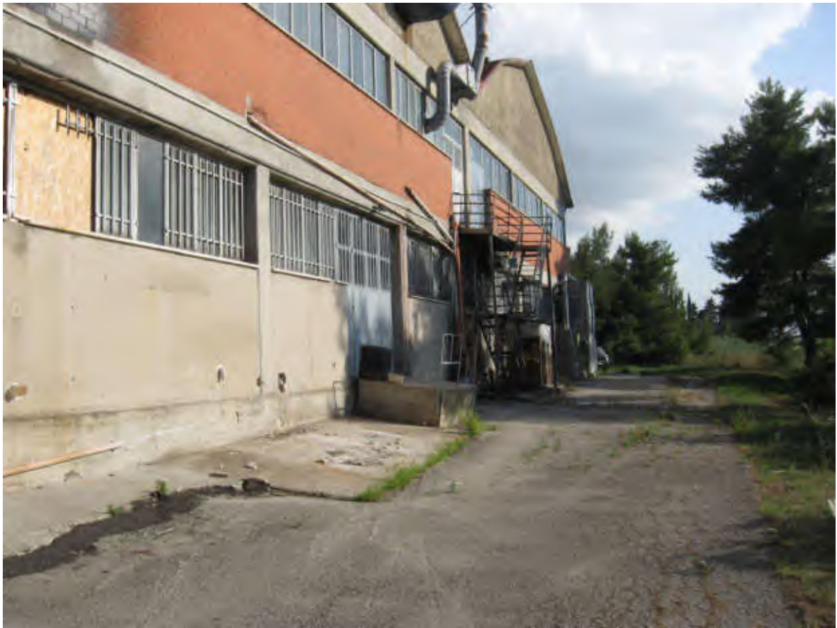
DOCUMENTAZIONE FOTOGRAFICA LABORATORIO LATO NORD
