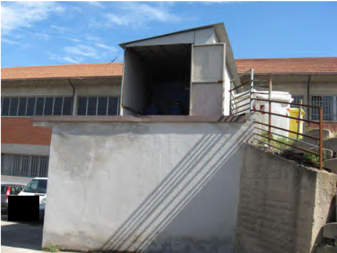
DOCUMENTAZIONE FOTOGRAFICA LABORATORIO LATO OVEST
