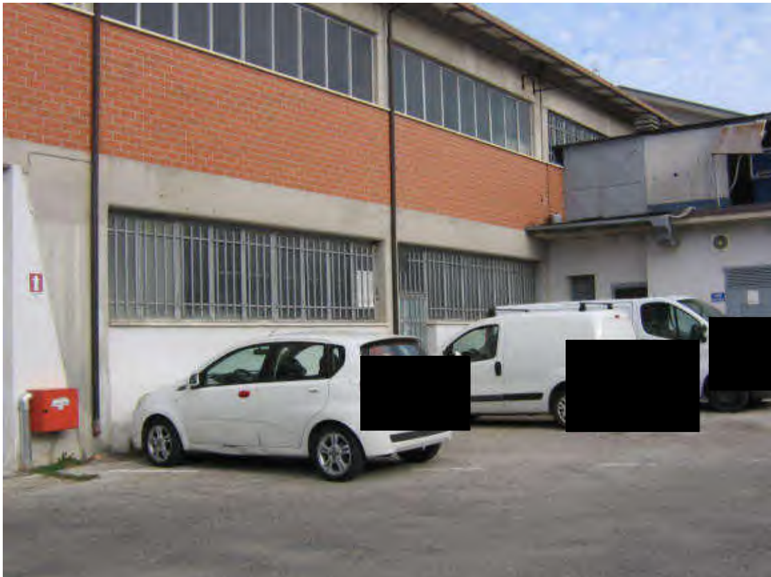
DEPOSITO AL PIANO SECONDO SOTTOSTRADA
