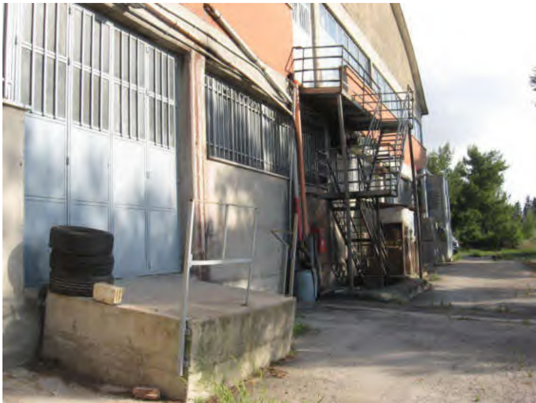
DOCUMENTAZIONE FOTOGRAFICA LABORATORIO LATO NORD
