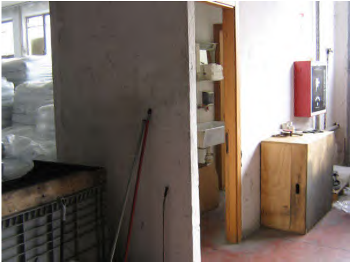
DEPOSITO AL PIANO SECONDO SOTTOSTRADA
