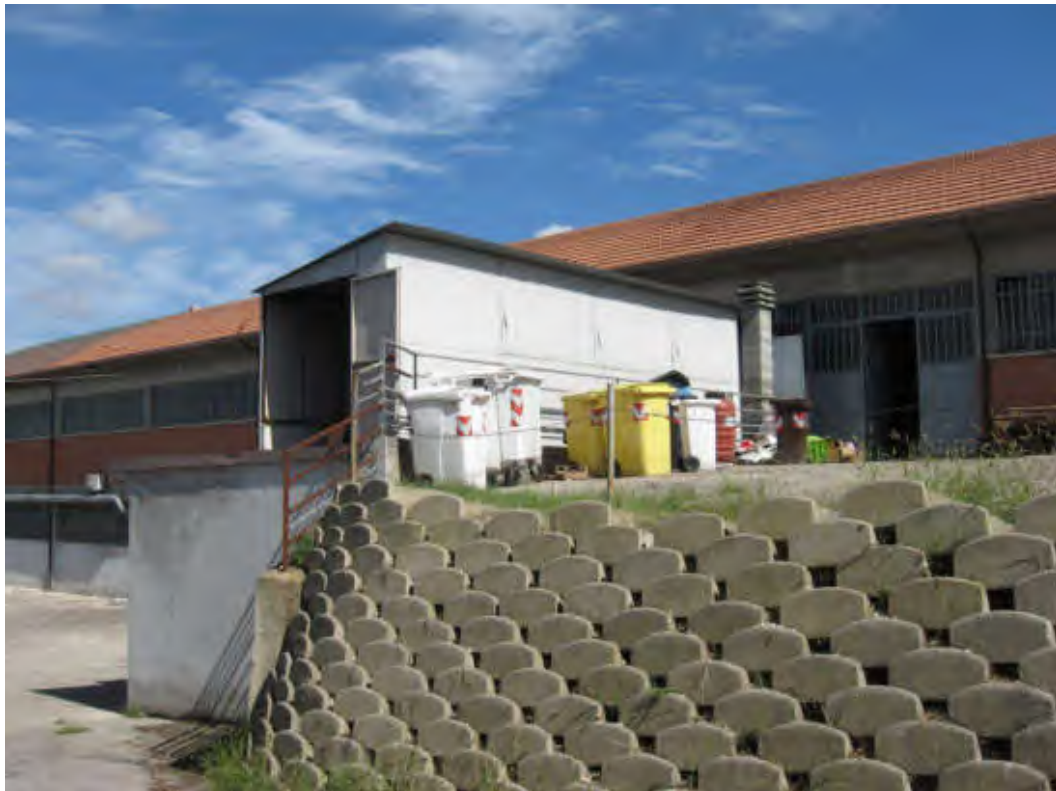
DOCUMENTAZIONE FOTOGRAFICA LABORATORIO LATO OVEST
