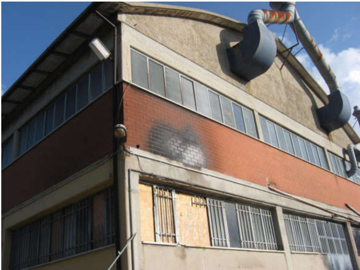
DOCUMENTAZIONE FOTOGRAFICA LABORATORIO LATO NORD
