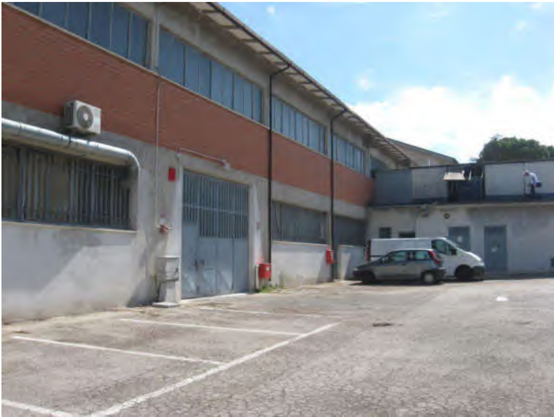
DOCUMENTAZIONE FOTOGRAFICA LABORATORIO LATO OVEST
