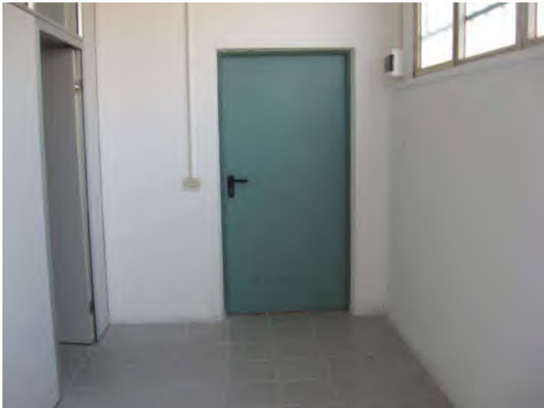
Laboratorio C - Piano secondo sottostrada - Uffici
