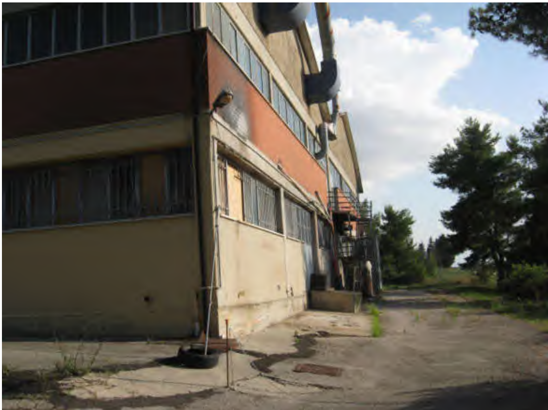
DOCUMENTAZIONE FOTOGRAFICA LABORATORIO LATO NORD
