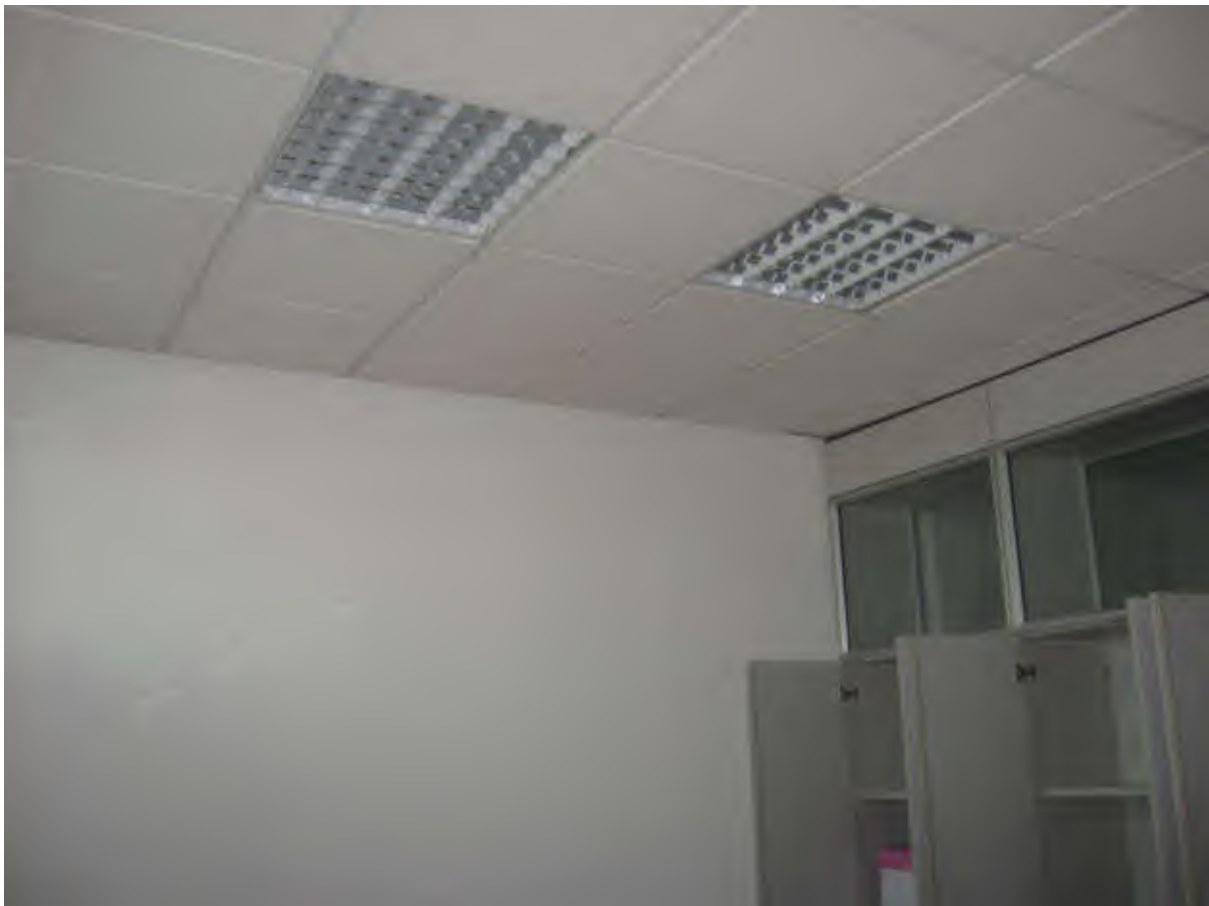
Laboratorio C - Piano secondo sottostrada - Uffici
