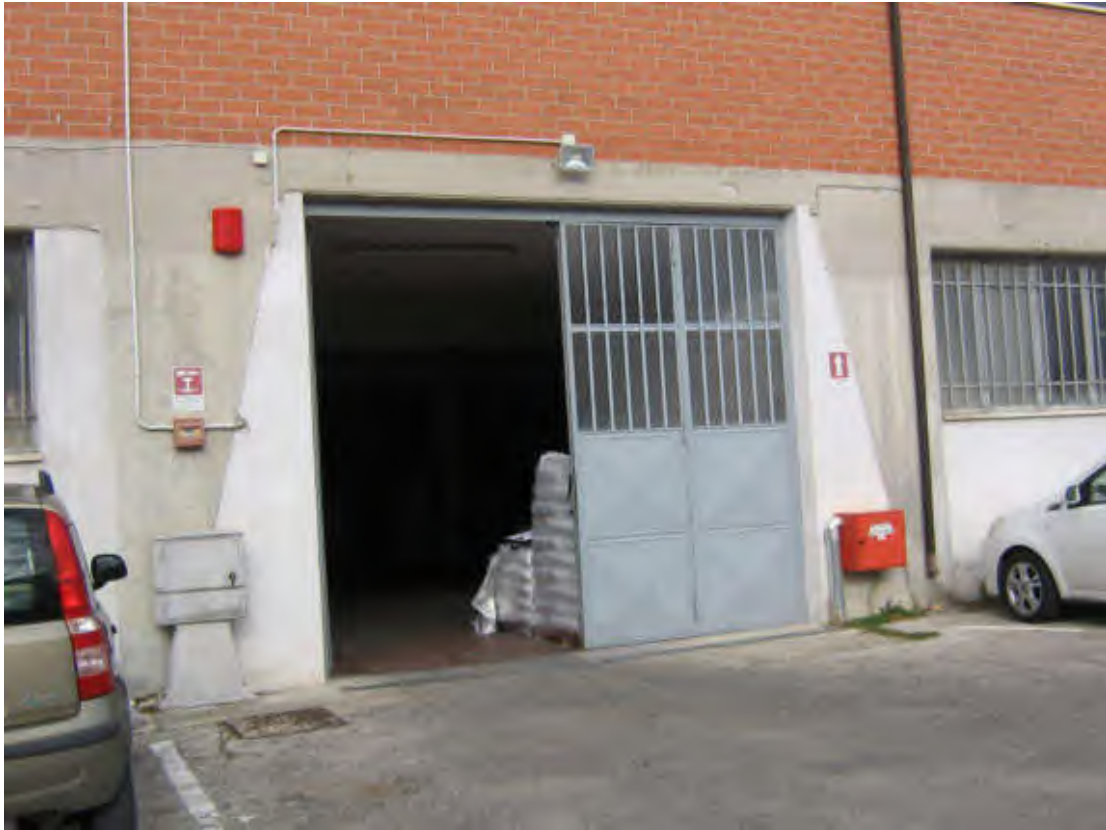
DEPOSITO AL PIANO SECONDO SOTTOSTRADA
