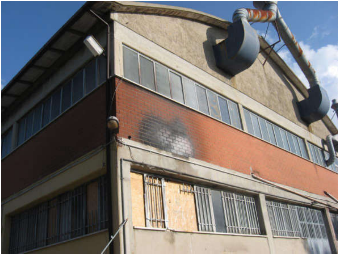
DOCUMENTAZIONE FOTOGRAFICA LABORATORIO LATO NORD
