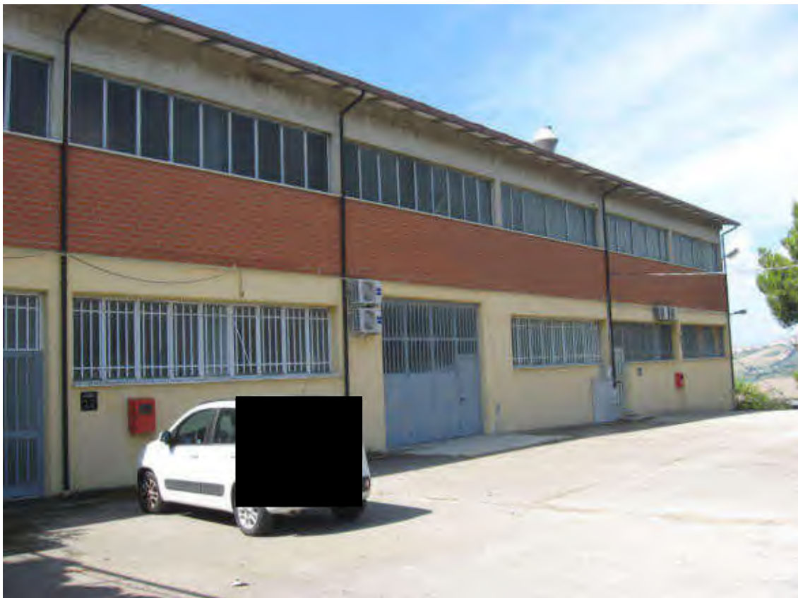
DOCUMENTAZIONE FOTOGRAFICA LABORATORIO LATO EST
