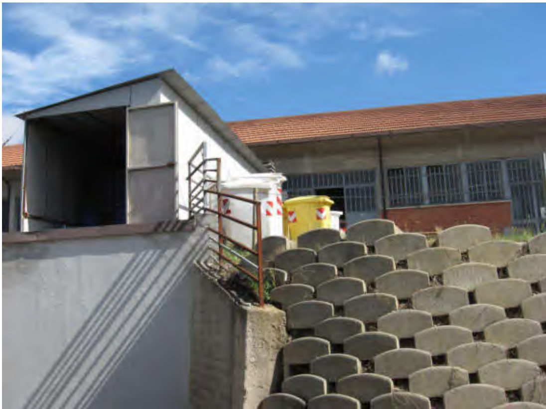
DOCUMENTAZIONE FOTOGRAFICA LABORATORIO LATO OVEST
