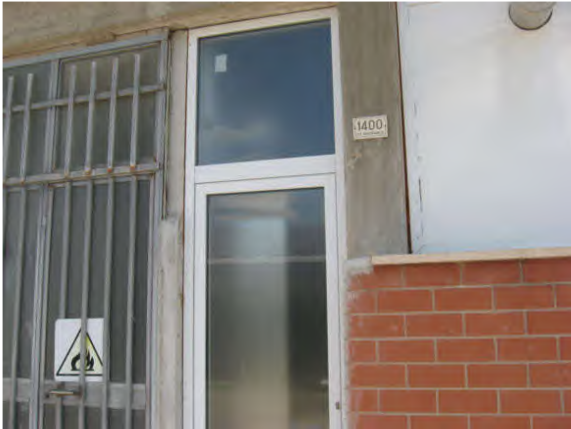
Laboratorio pasticceria - Piano primo sottostrada – Ingresso
