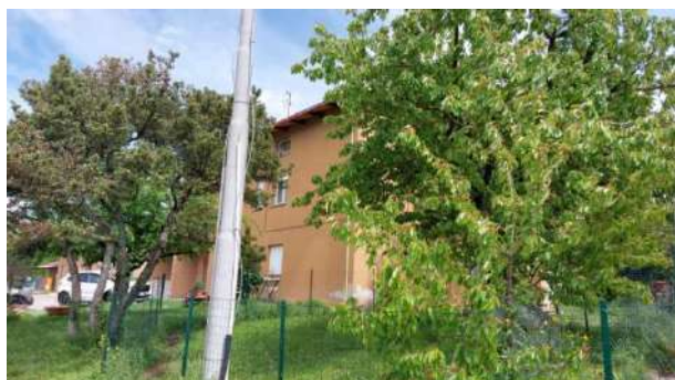
Foto nr.06 : esterni immobile
