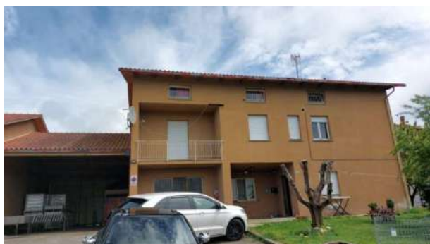
Foto nr.04 : esterni immobile
