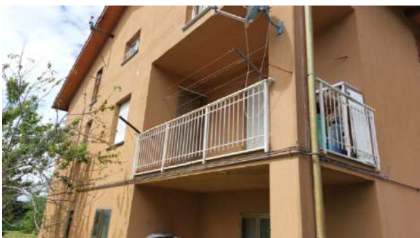
Foto nr.08 : esterni immobile
