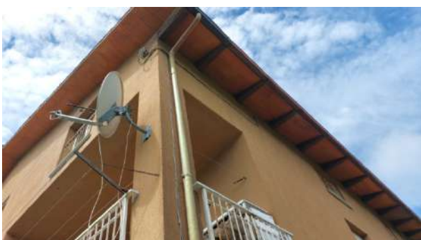
Foto nr.10 : esterni immobile
