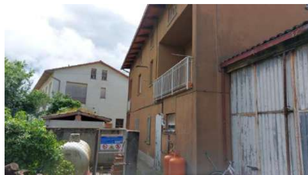
Foto nr.05 : esterni immobile
