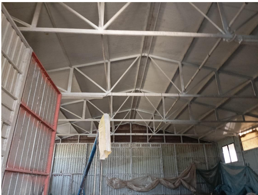
Deposito p.lla 130 sub 4 CORPO 3
