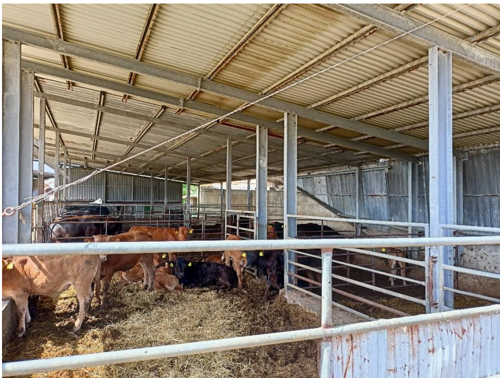
Tettoia stalla p.Ila 130 sub 4 CORPO 7
