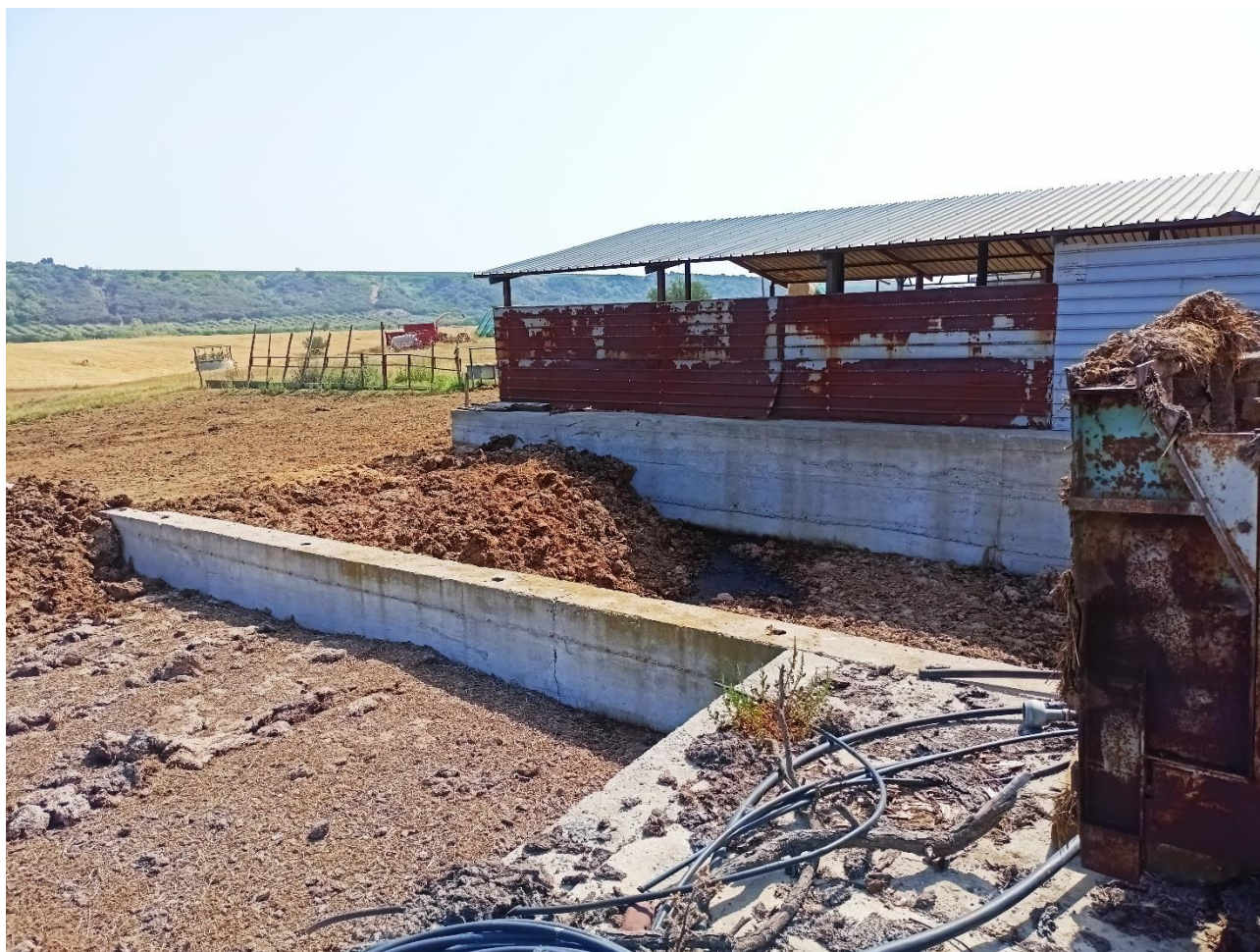
Tettoia stalla p.lla 130 sub 4 CORPO 5
