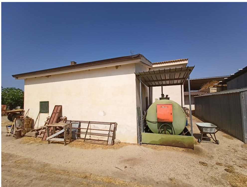
Deposito p.lla 130 sub 4 CORPO 9
