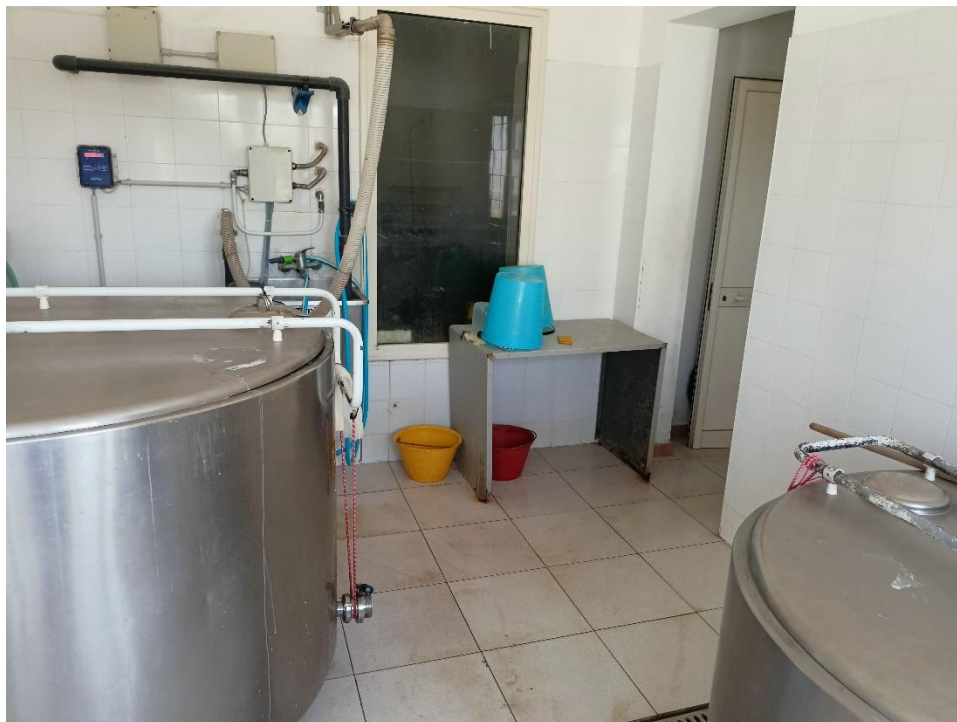
Sala latte p.IIa 130 sub 4 CORPO 2
