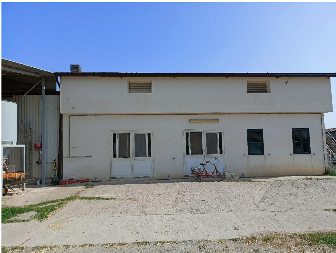
Sala latte, caseificio e sala mungitura P.LLA 130 sub 4 CORPO2
