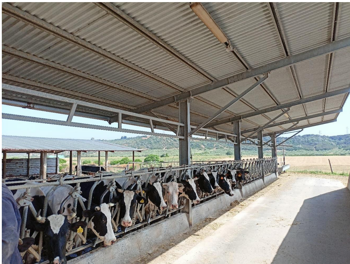
Tettoia p.lla 130 sub 4 CORPO 8
