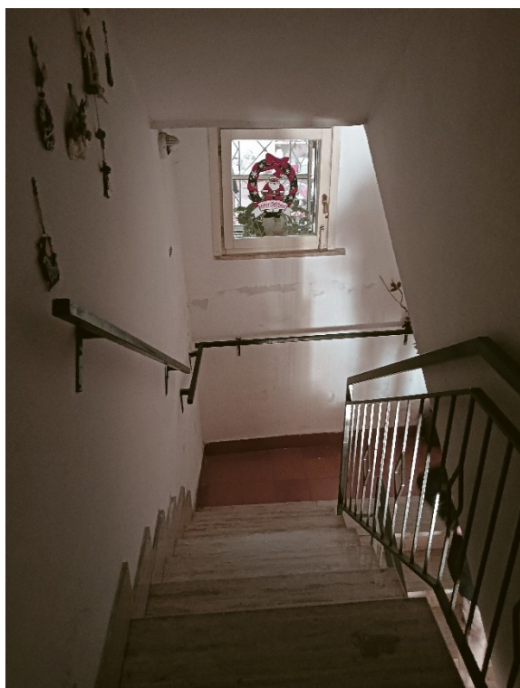
Foto 2. rampa ingresso scala condominiale
