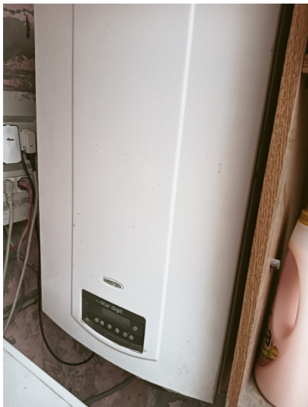
Foto 26: Caldaia a gas esterna
