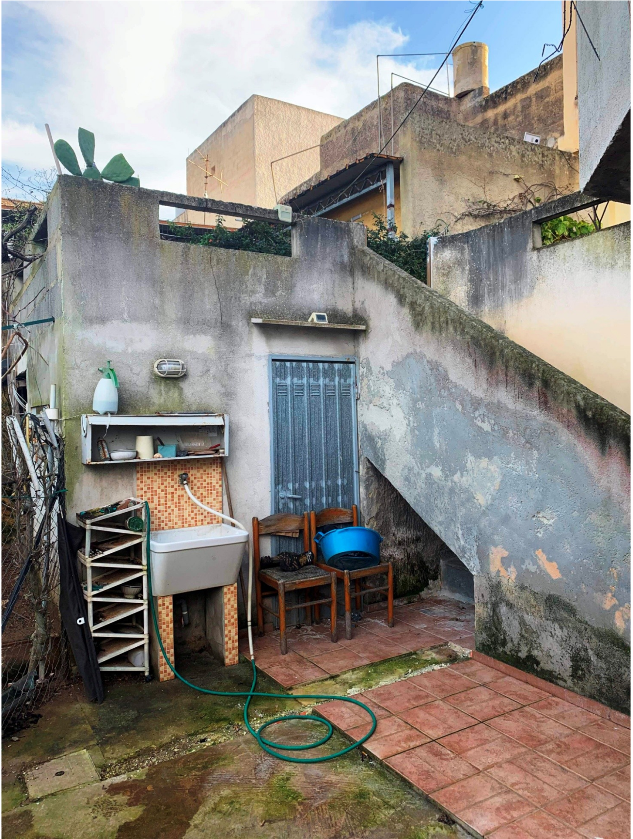
FG 116 Sub 6 - Piano seminterrato (Loc. tecnico autoclave)
