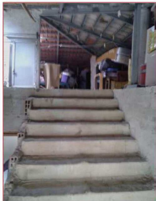
Foto n.22–scale di accesso al sottotetto-2ª rampa
