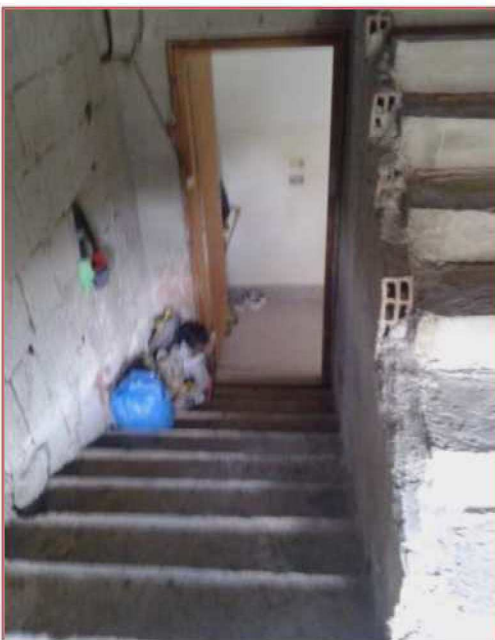
Foto n.21–scale di accesso al sottotetto-1ª rampa
