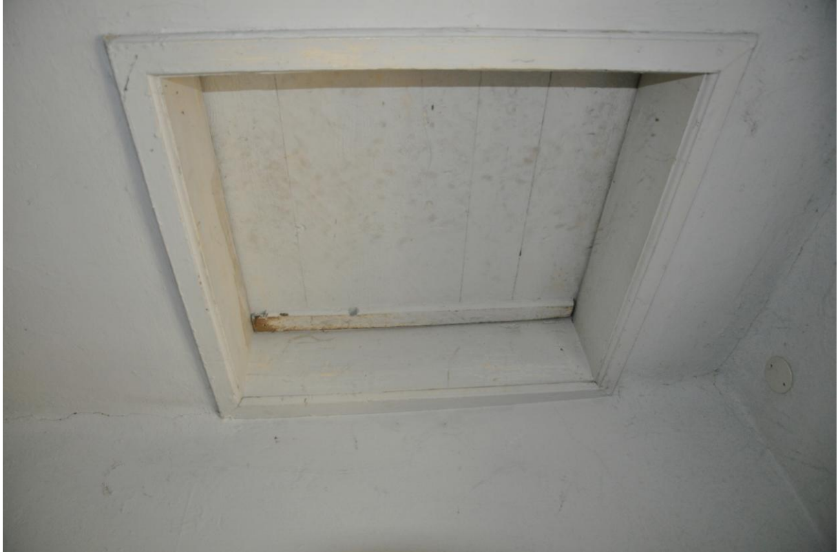
Fotografia n. 19 – Botola per accesso al piano soffitta
