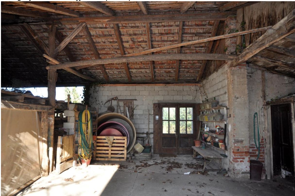
Fotografia n. 22 – Soffitta al piano primo
