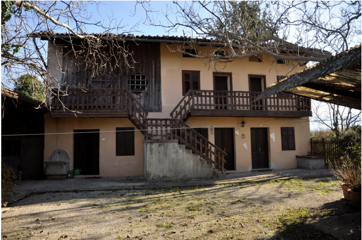
Fotografia n. 1 – Corpo principale visto dalla corte interna
