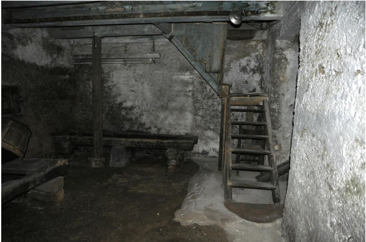
Fotografia n. 17 – Cantina al piano interrato
