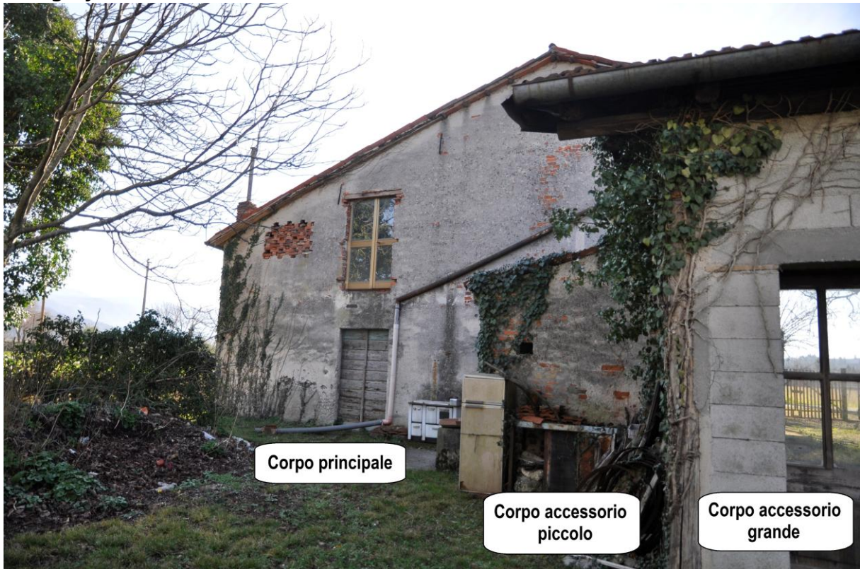
Fotografia n. 7 – Facciata a Nord-Ovest
