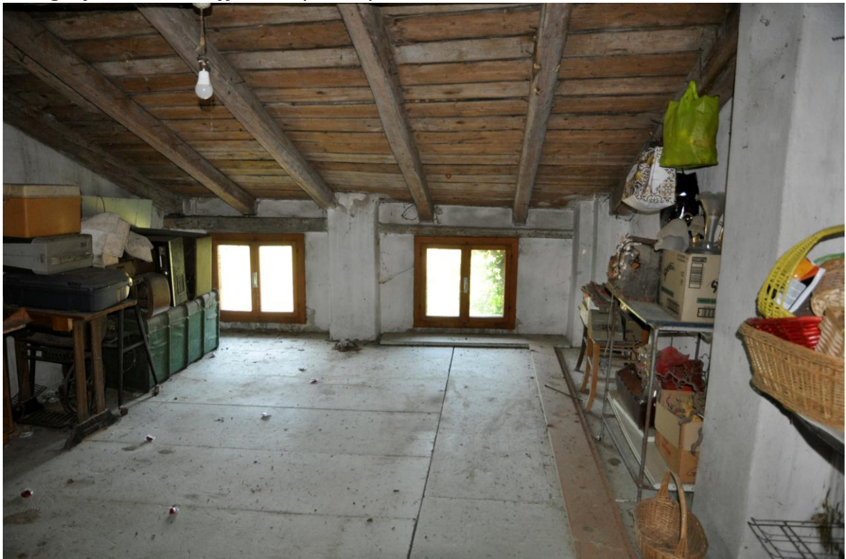
Fotografia n. 18 – Soffitta al piano primo
