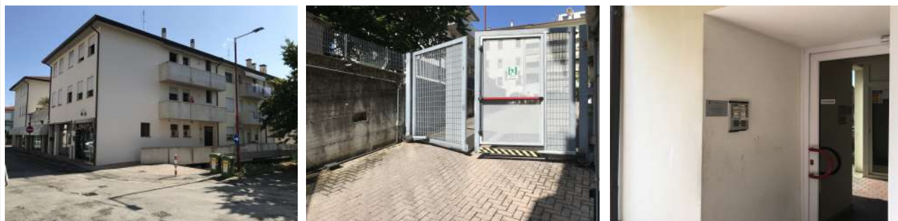
Foto 4 Prospetti del complesso edilizio con accesso alla rampa carrabile
