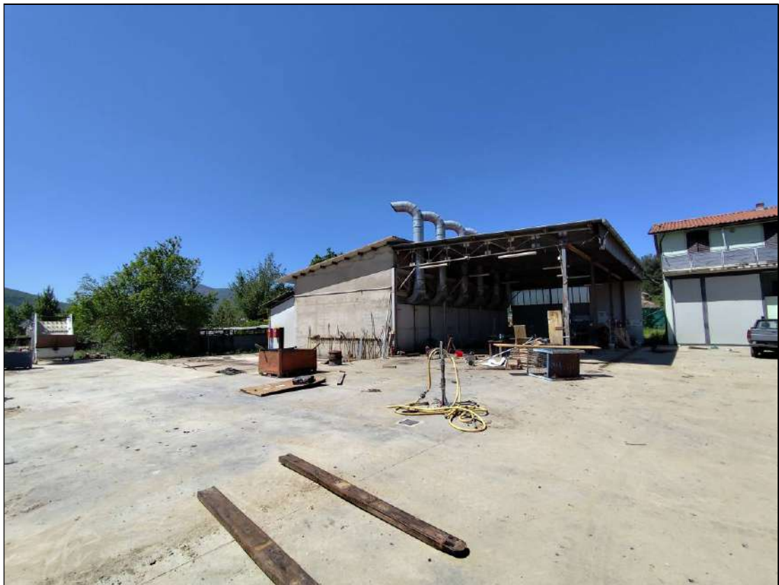
Foto n. 15 – Area Esterna Sub. 1
