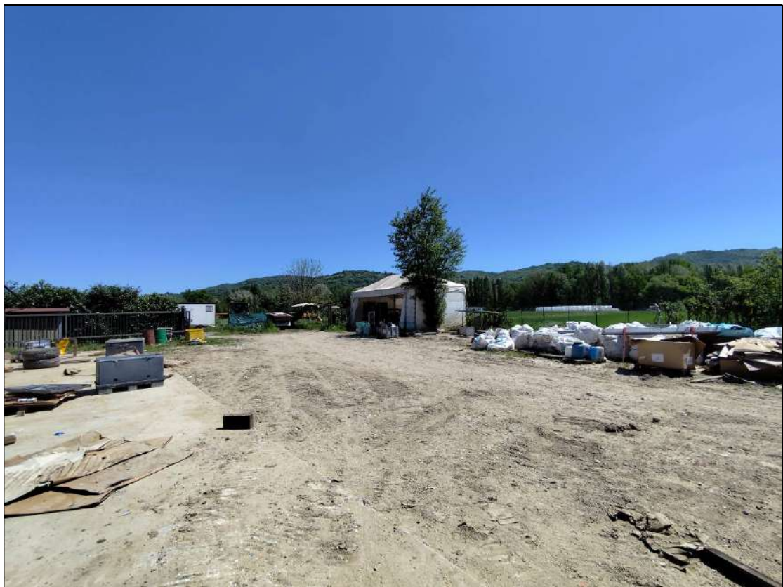
Foto n. 16 – Area Esterna Sub. 1
