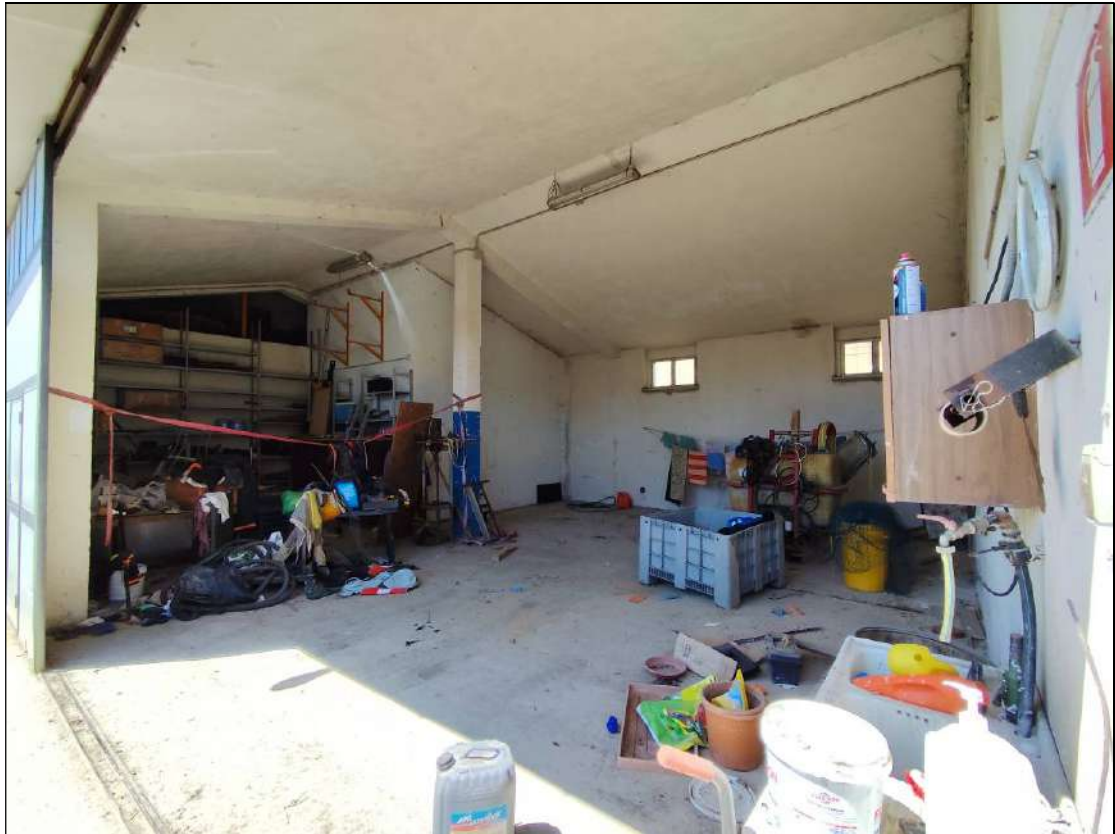
Foto n. 11 – Interno P.T Sub. 7
