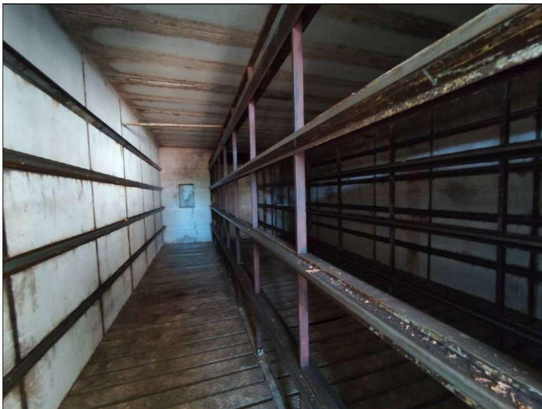
Foto n. 13 – Interno Forni Tabacco Sub. 4
