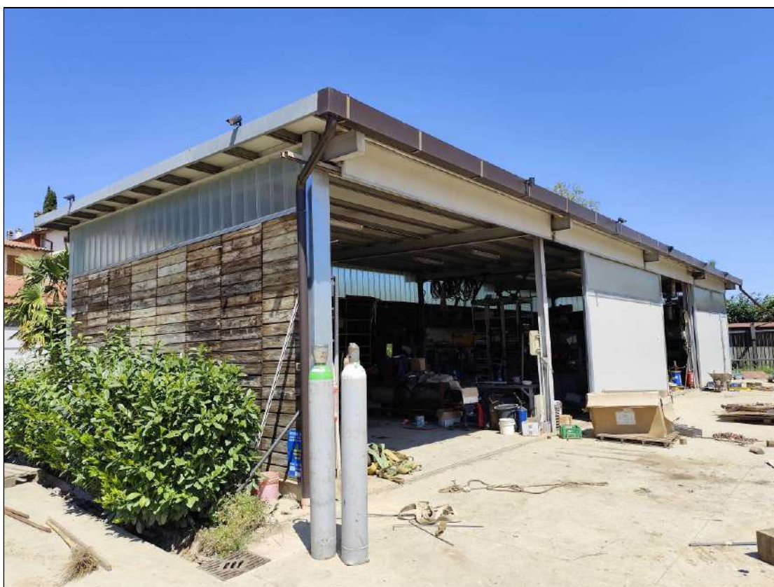
Foto n. 14 – Tettoia Rimessa Sub. 2
