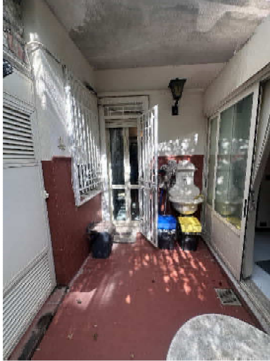
Foto nr.11: particolare del terrazzo interno
