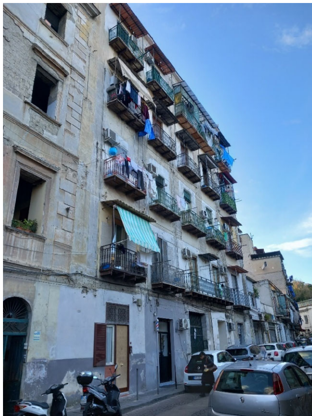
Foto n.1 – Fabbricato via Fontanelle 34
