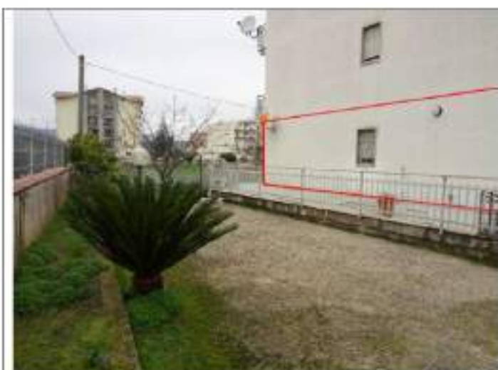
SCATTO FOTO N. 4 CORTE E BALCONE CON EVIDENZIATO L'APPARTAMENTO, IN FONDO PROPRIETA' GRECO
