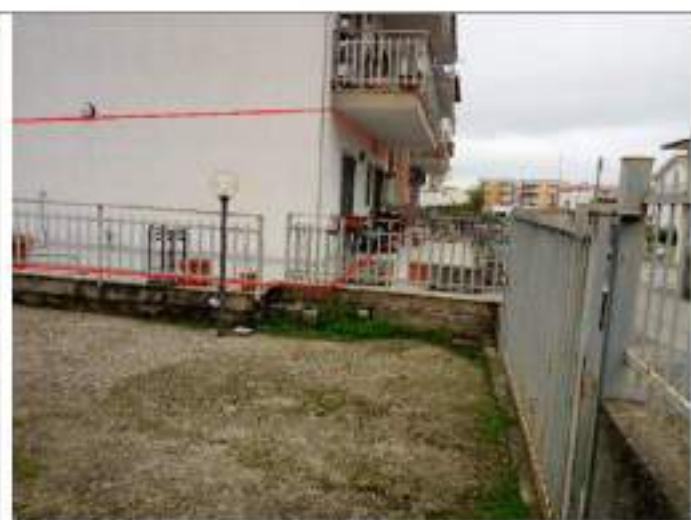
SCATTO FOTO N. 5 CORTE E BALCONE CON EVIDENZIATO L'APPARTAMENTO, IN FONDO CORSO ITALIA
