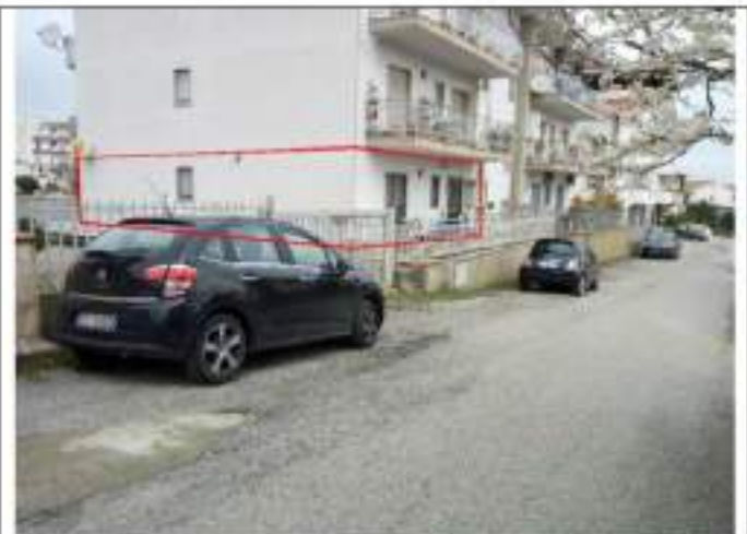
SCATTO FOTO N. 11 VIA G. MATTEOTTI CON EVIDENZIATO L'APPARTAMENTO ED IN FONDO CORSO ITALIA
