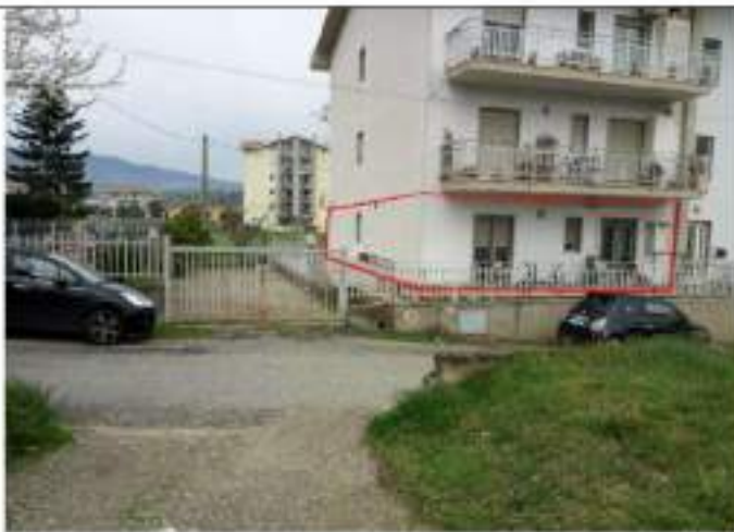
SCATTO FOTO N. 10 VISTA DELLA CORTE CON IL CANCELLO SU VIA G. MATTEOTTI ED EVIDENZIATO L'APPARTAMENTO
