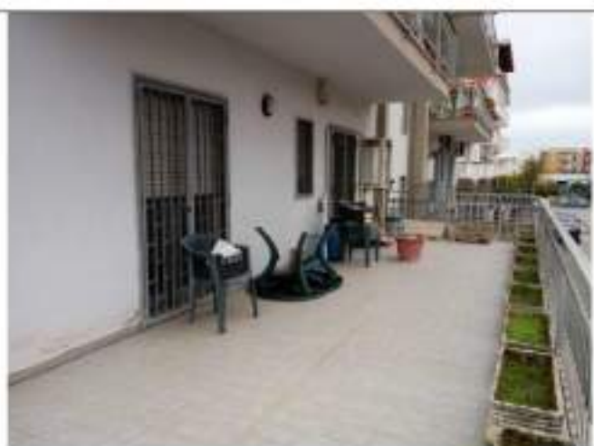
SCATTO FOTO N. 3 BALCONE, CON IN FONDO VIA G. MATTEOTTI
