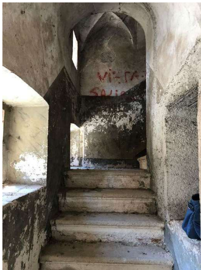
Foto 4 – Ingresso vano scala
