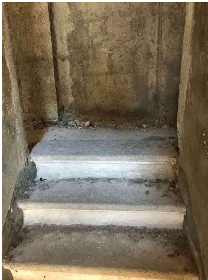
Foto 5 – Ingresso vano scala
