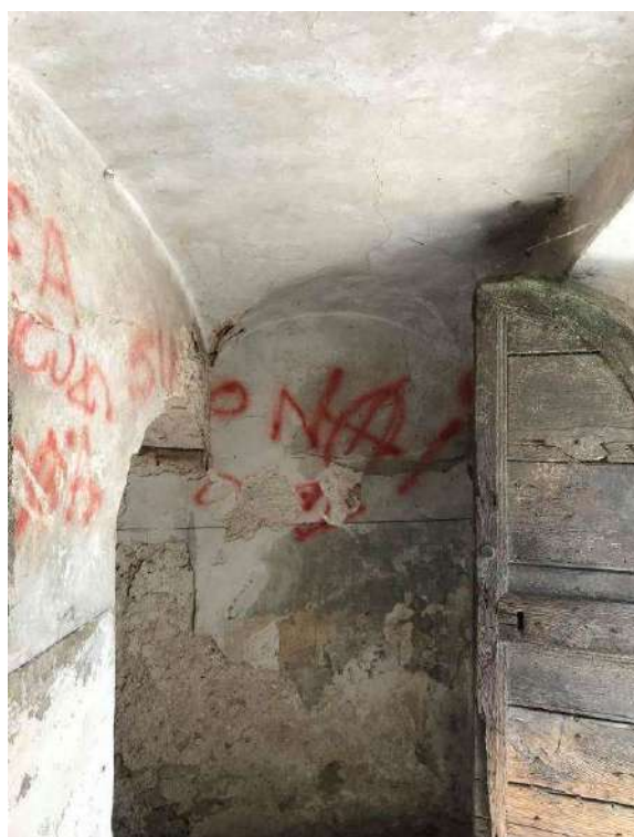
Foto 2 – Ingresso vano scala
