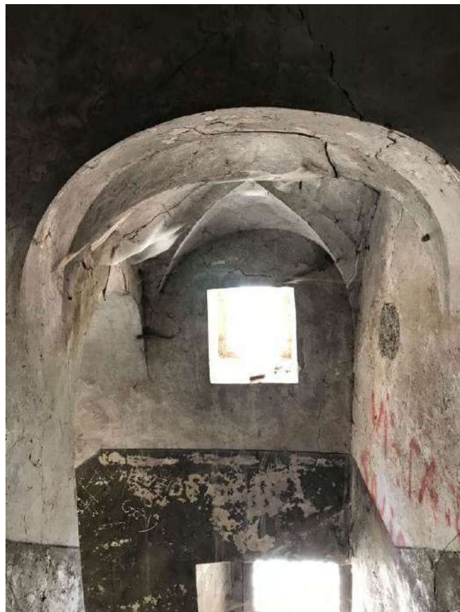
Foto 8 – Ingresso vano scala
