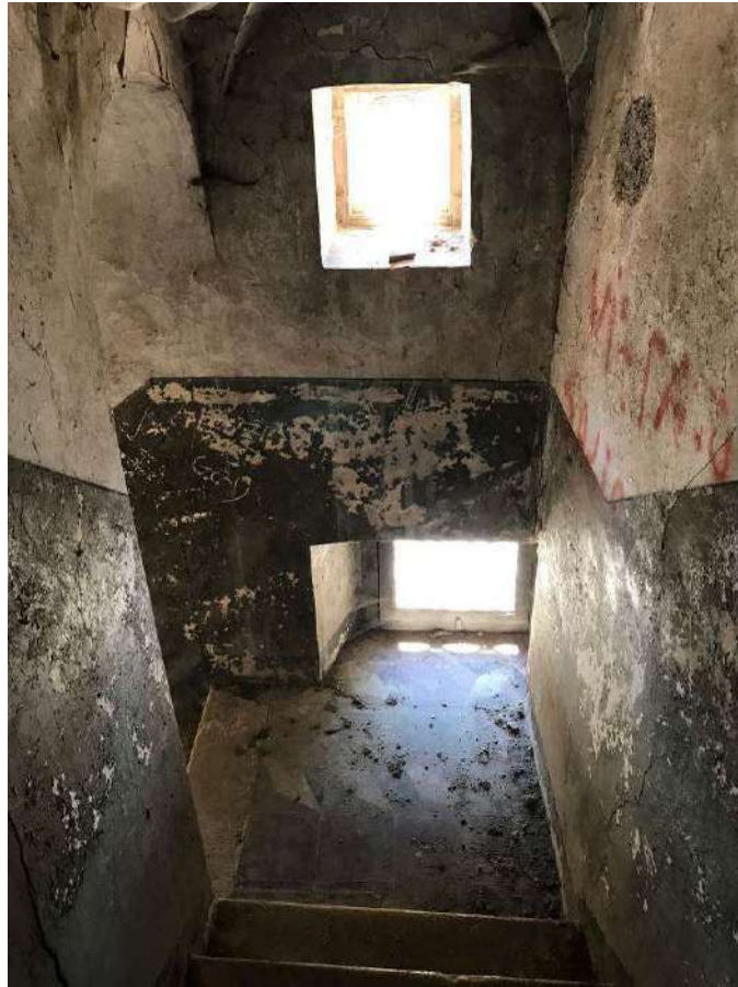
Foto 7 – Ingresso vano scala
