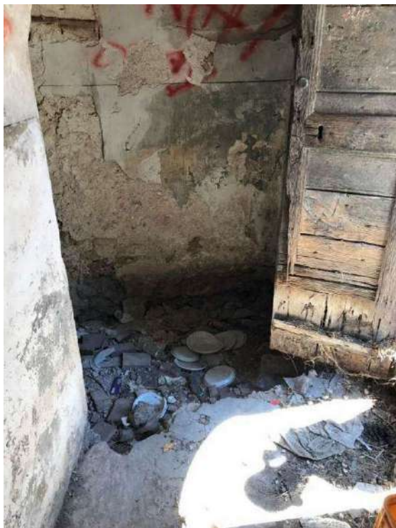
Foto 1 – Ingresso vano scala
