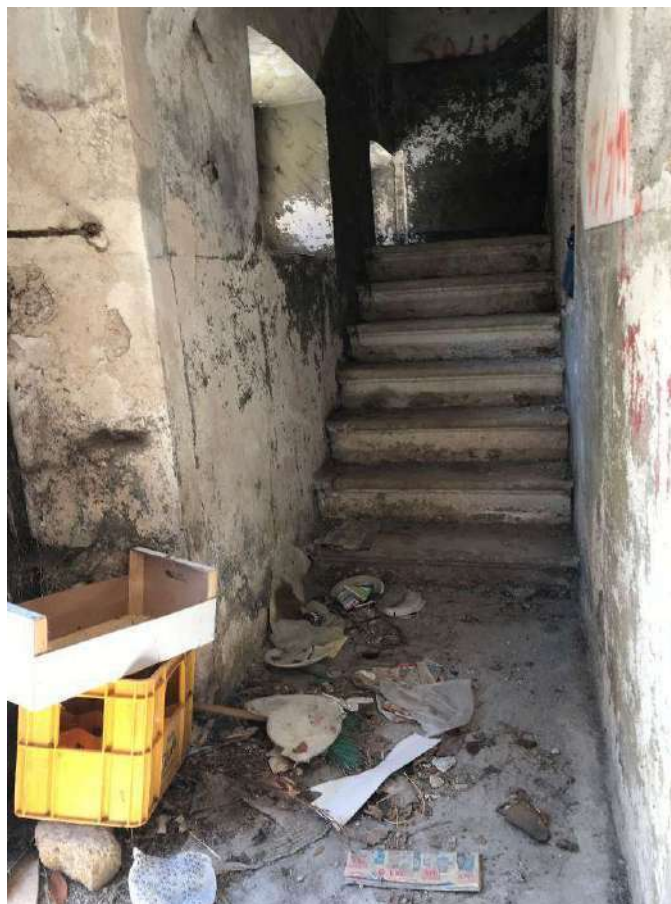
Foto 3 – Ingresso vano scala
