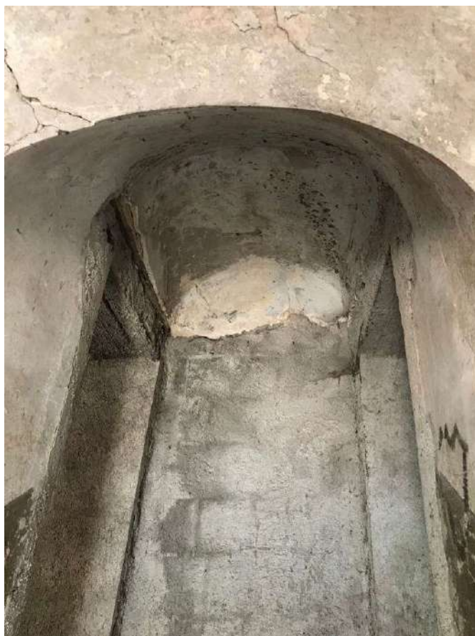
Foto 6 – Ingresso vano scala
