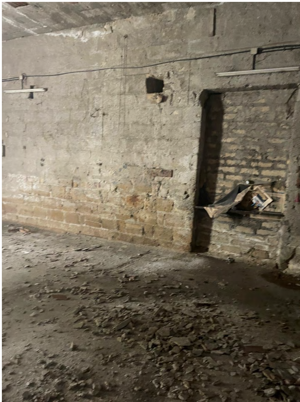
Fotografia n. 10 _ Interno del deposito
