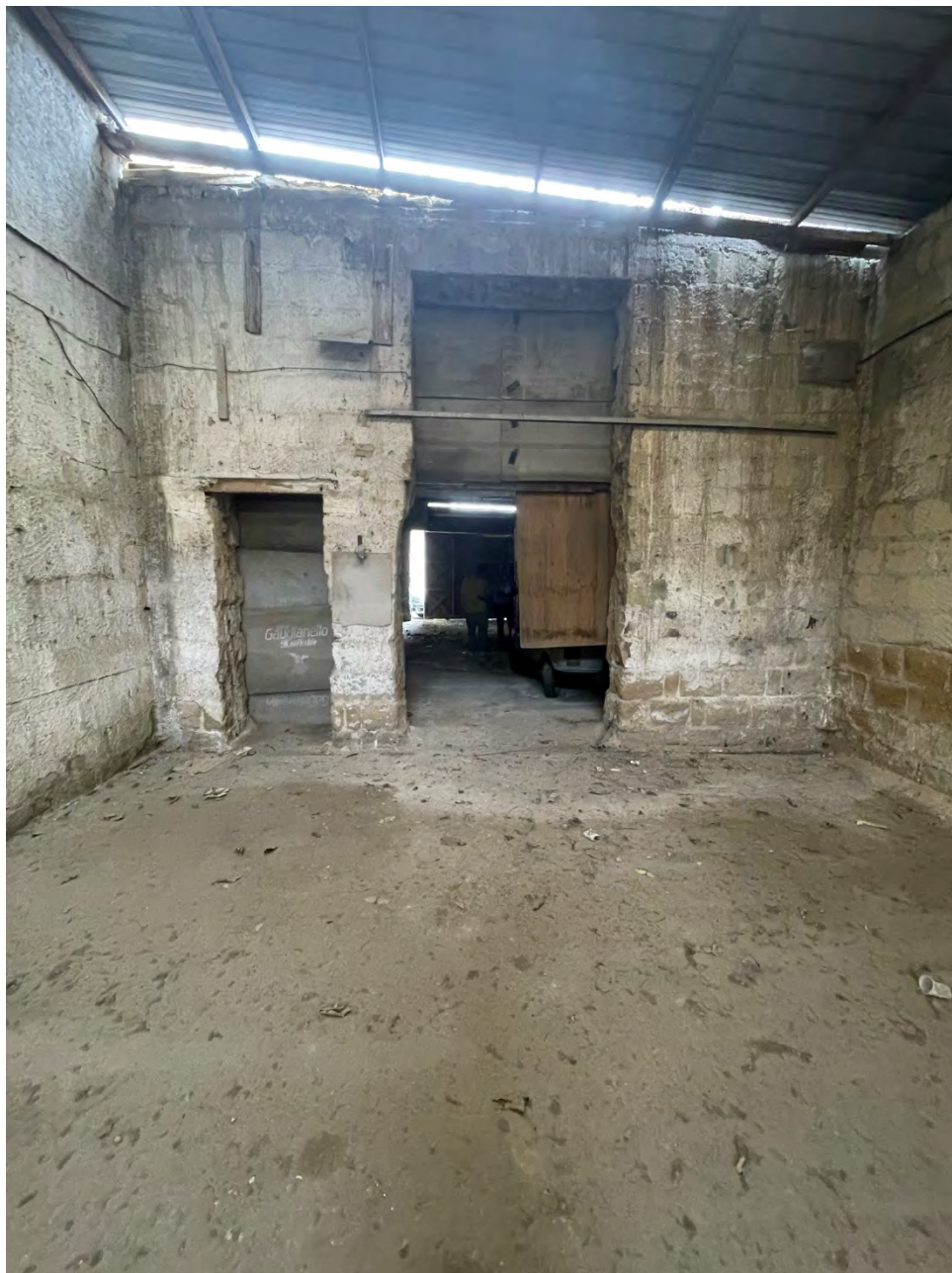
Fotografia n. 7 _ Interno del deposito
