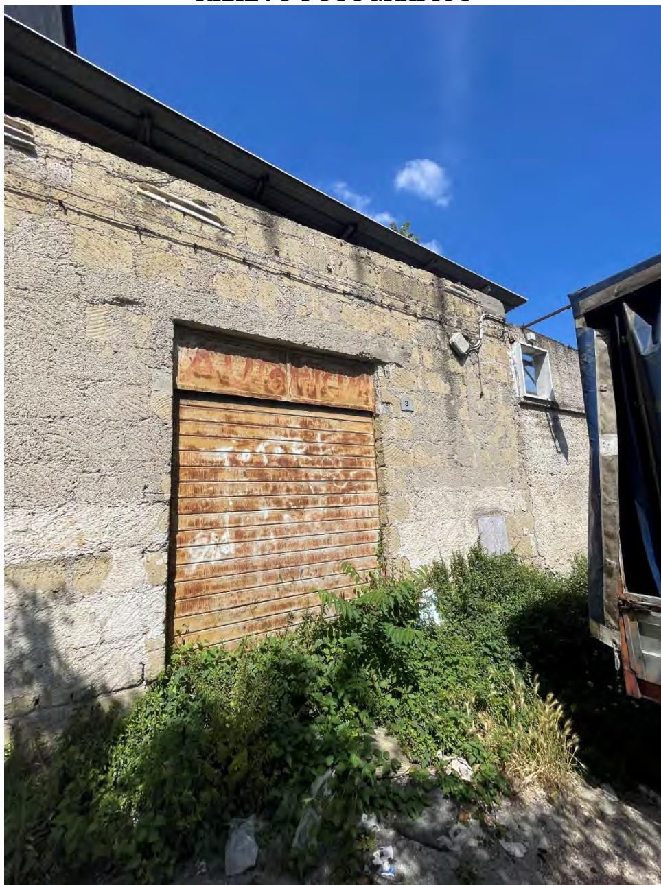
Fotografia n. 1 _ Ingresso al deposito da via Cristoforo Colombo
