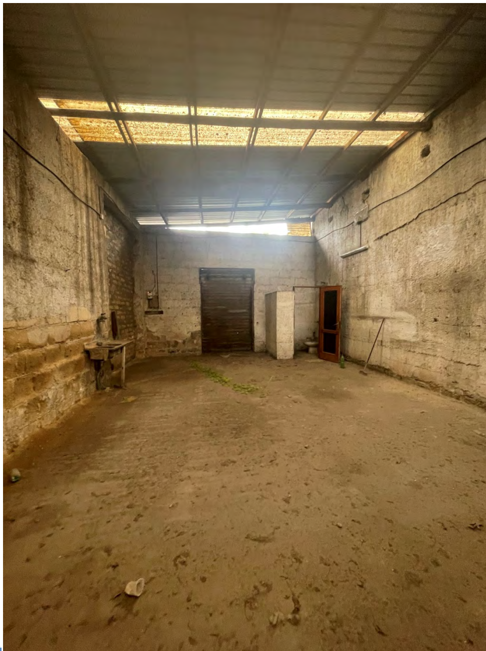
Fotografia n. 8 _ Interno del deposito
