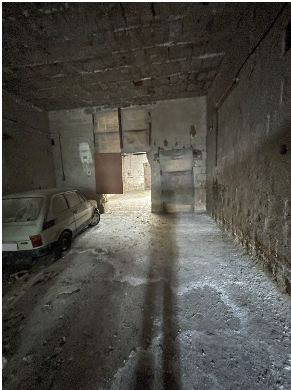
Fotografia n. 9 _ Interno del deposito
