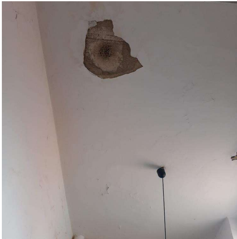
Foto 8 – saggi eseguiti sul soffitto
