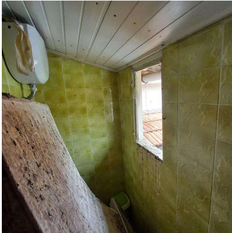
Foto 10- la finestra del bagno
