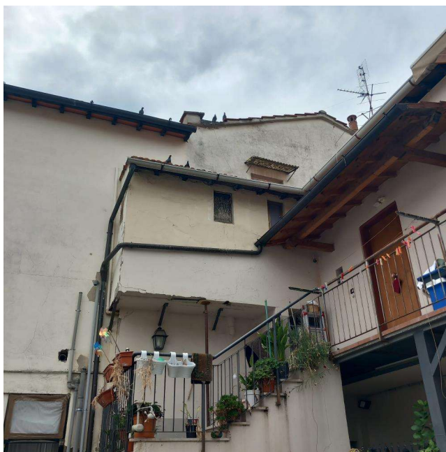
Foto 19: il wc affaccia su una corte interna
