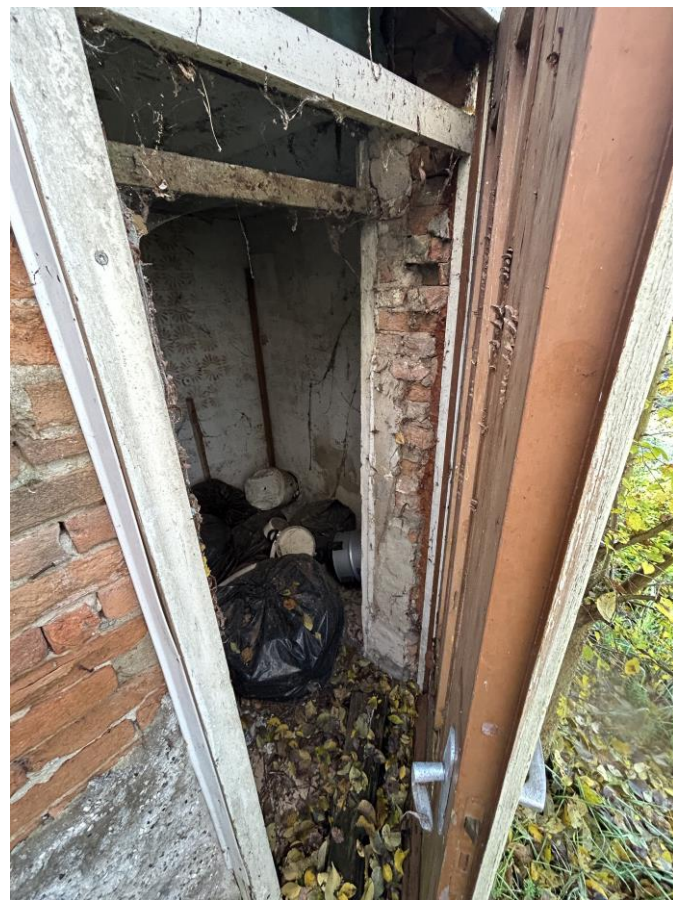
Foto n. 20 – Rustico – Piano T – Ripostiglio
