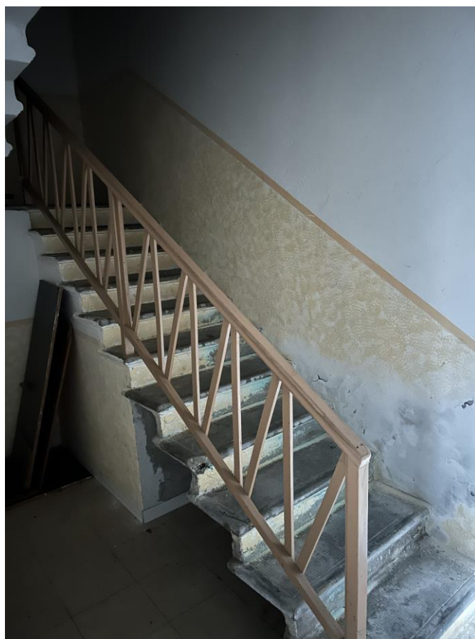
Foto n. 10 – Abitazione – Piano T – Vano scala
