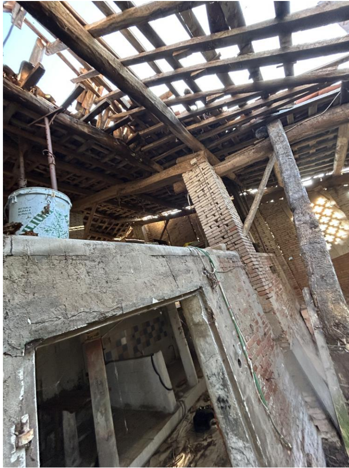
Foto n. 21 – Rustico – Piano 1 – Locale di deposito
