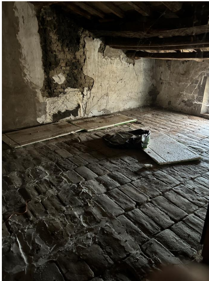
Foto n. 16 – Abitazione – Piano 2 – Soffitta
