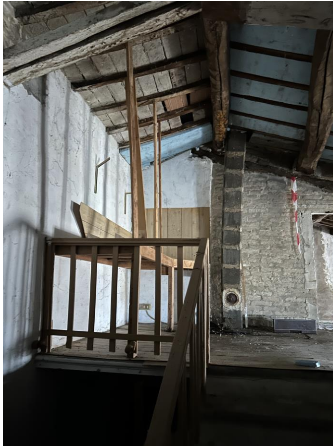
Foto n. 15 – Abitazione – Piano 2 – Soffitta
