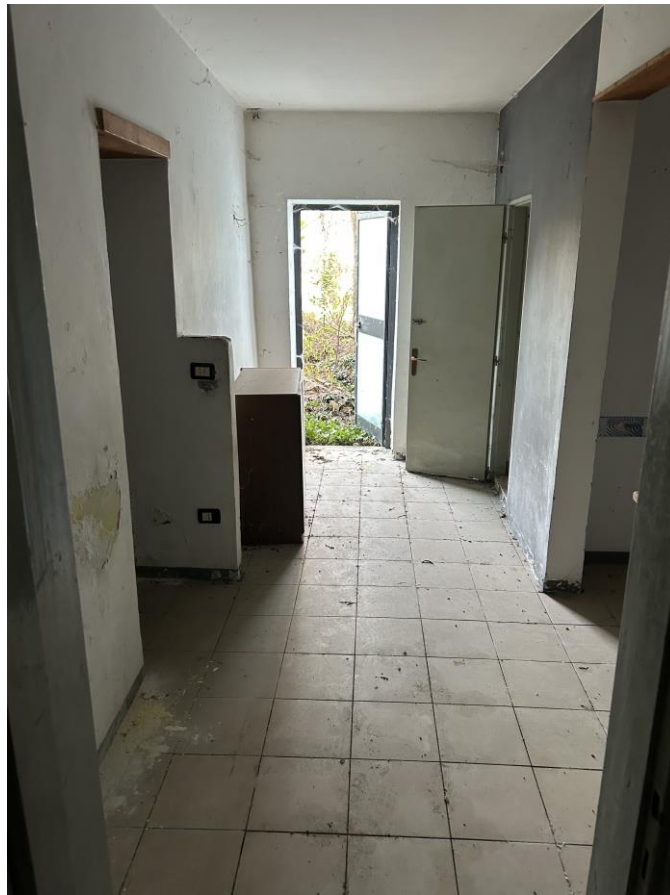
Foto n. 5 – Abitazione – Piano T – Disimpegno
