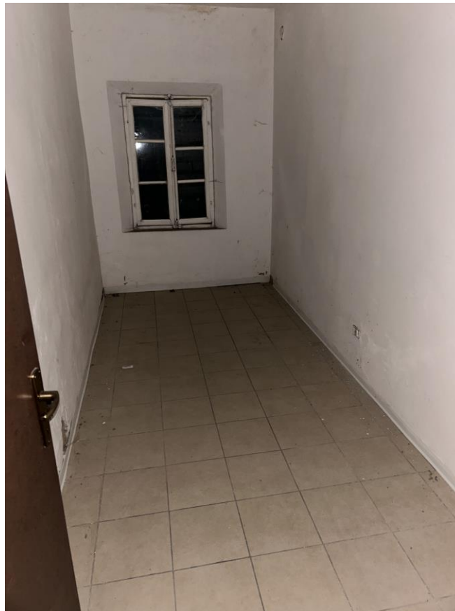
Foto n. 12 – Abitazione – Piano 1 – Ripostiglio
