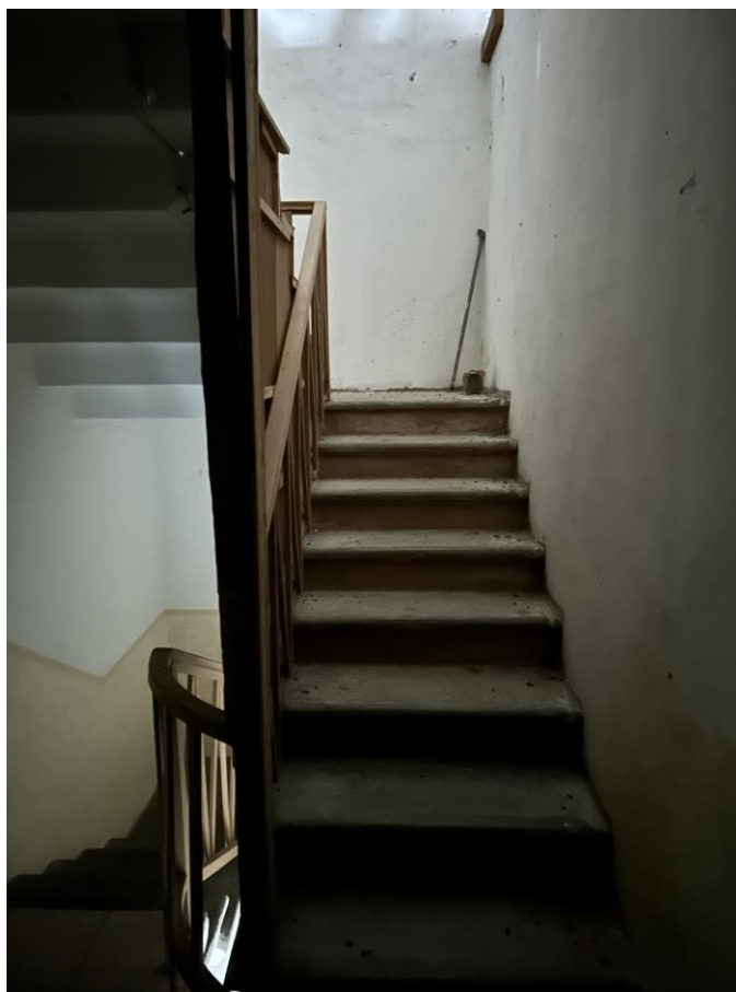
Foto n. 14 – Abitazione – Piano 1 – Vano scala
