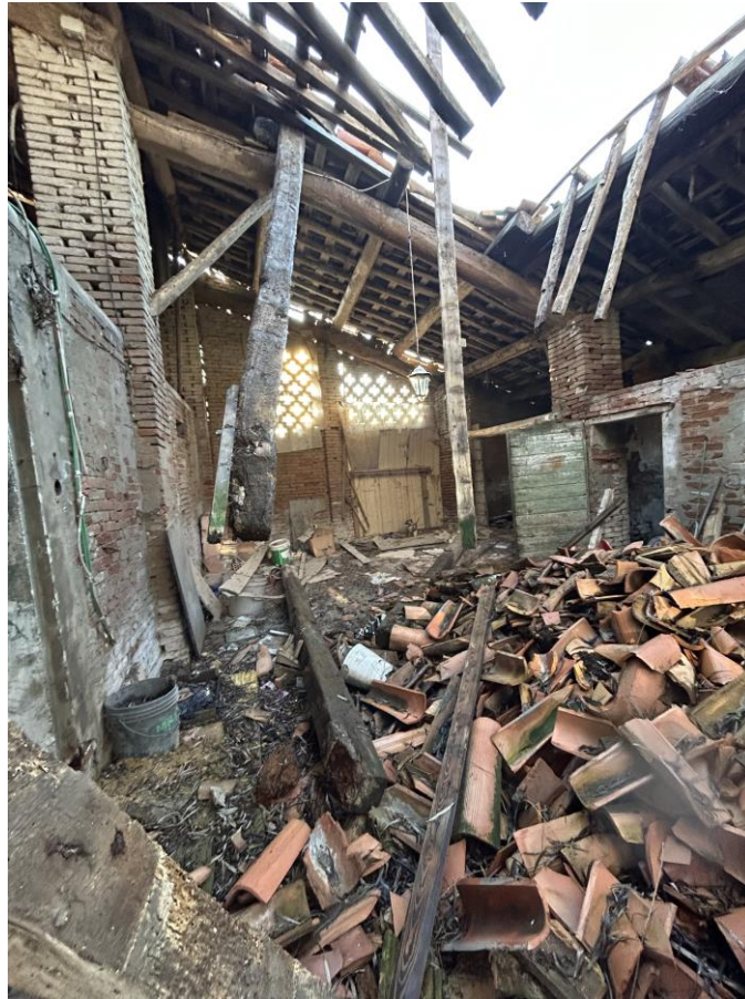
Foto n. 19 – Rustico – Piano T – Locale di deposito
