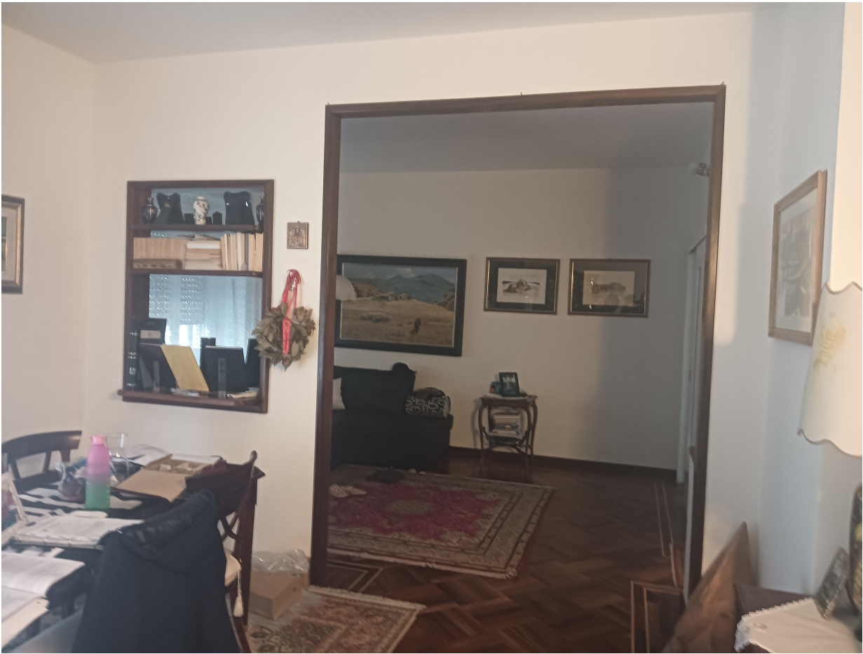
Varco da chiudere visto dal sub 2
