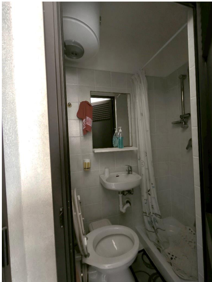
WC annesso alla veranda
