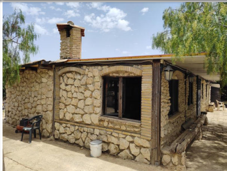
Foto n. 12 – Volume abusivo da sanare
