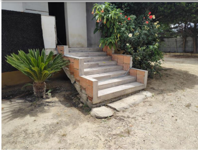
Foto n. 3 – Scaletta di accesso al piano rialzato
