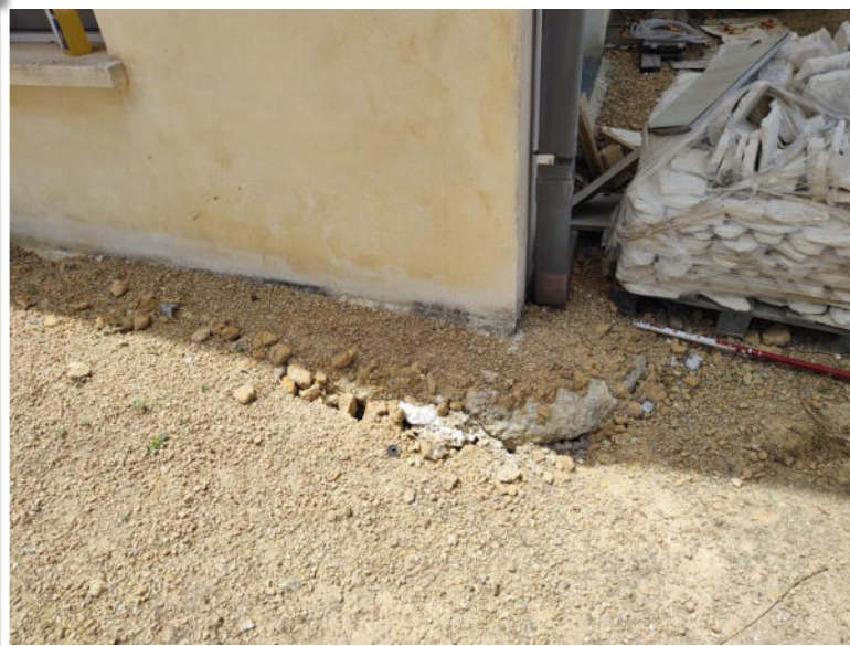
Foto n. 4 – Particolare fondazione fabbricato
