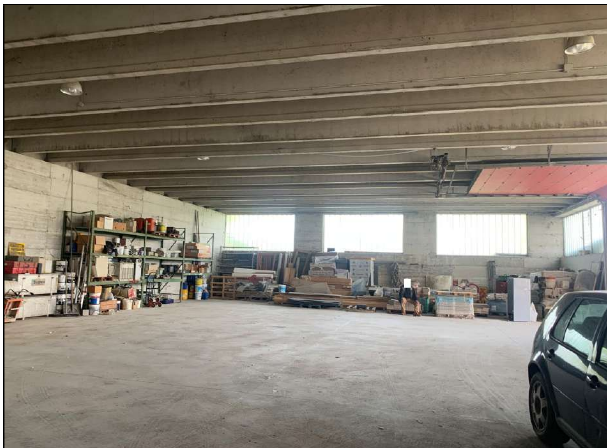
Foto n°7 – Foglio 5 Particella 424 sub 2
