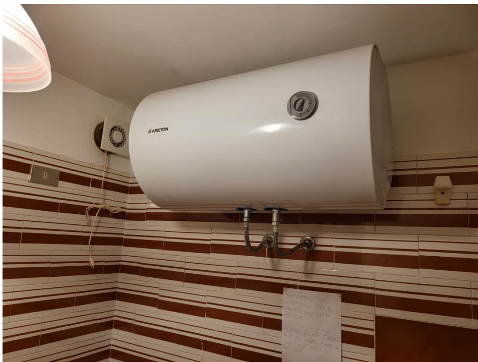
Foto 20 – Scaldabagno elettrico
