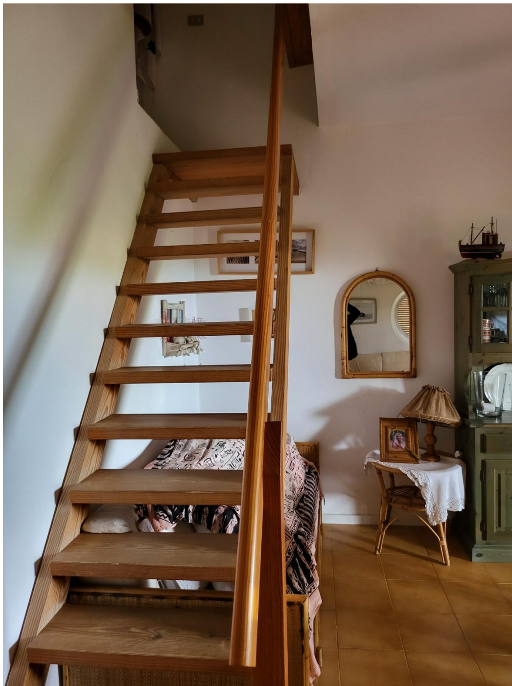
Foto 11- Scala di accesso al piano superiore
