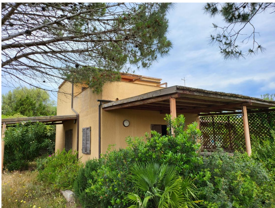
Foto 2- Vista dell'immobile dal lato giardino
