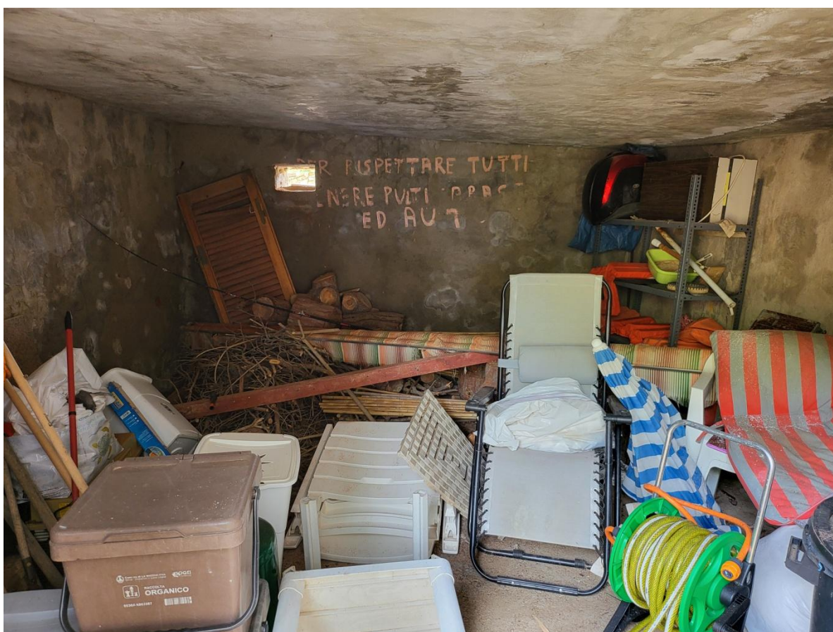
Foto 18 – locale di sgombero abusivo da demolire
