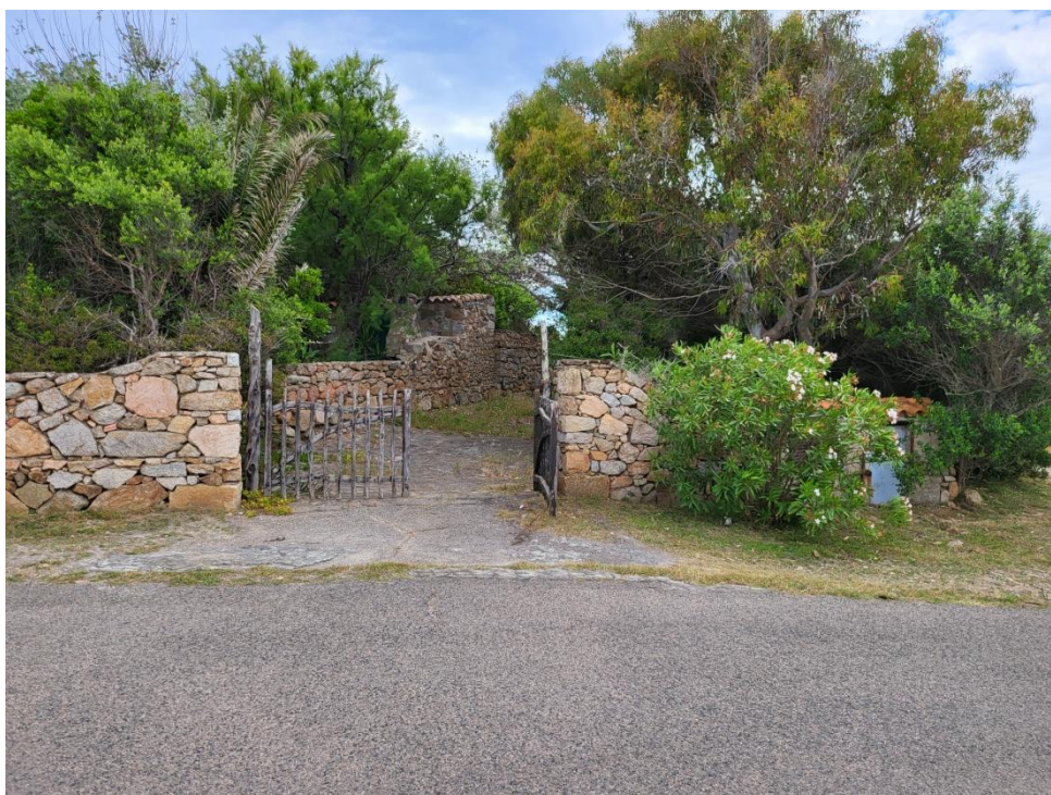
Foto 1- Accesso alla proprietà da via delle Ginestre
