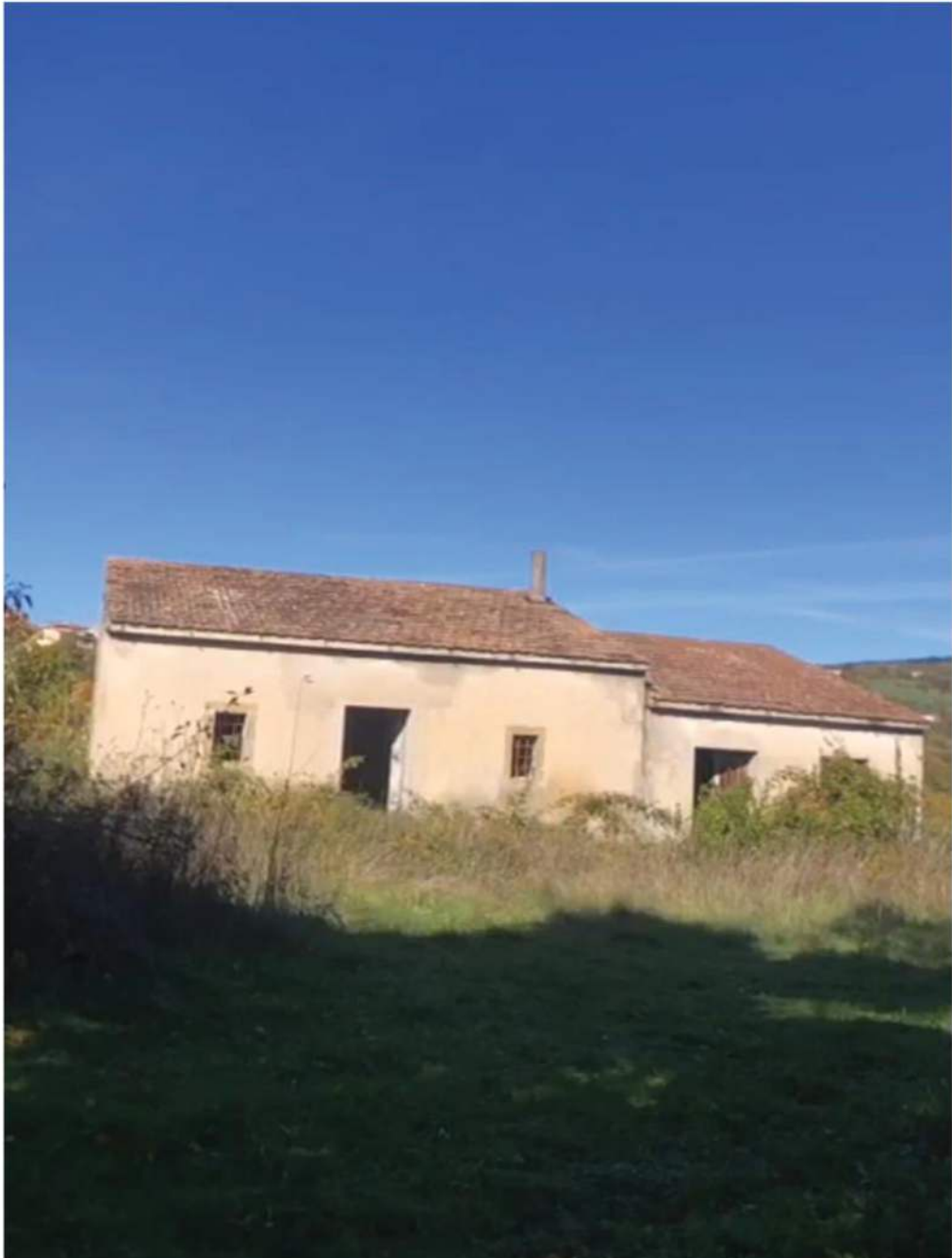
Foto n. 10 - Comune di Molinara (Bn): casolare in disuso identificato al NCT al foglio 23 particella 1168 (ex 636).
