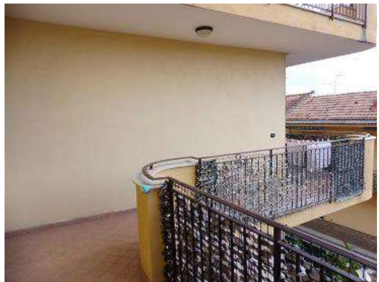
_balcone (prospettante su via Leonardo da Vinci – lato est)
