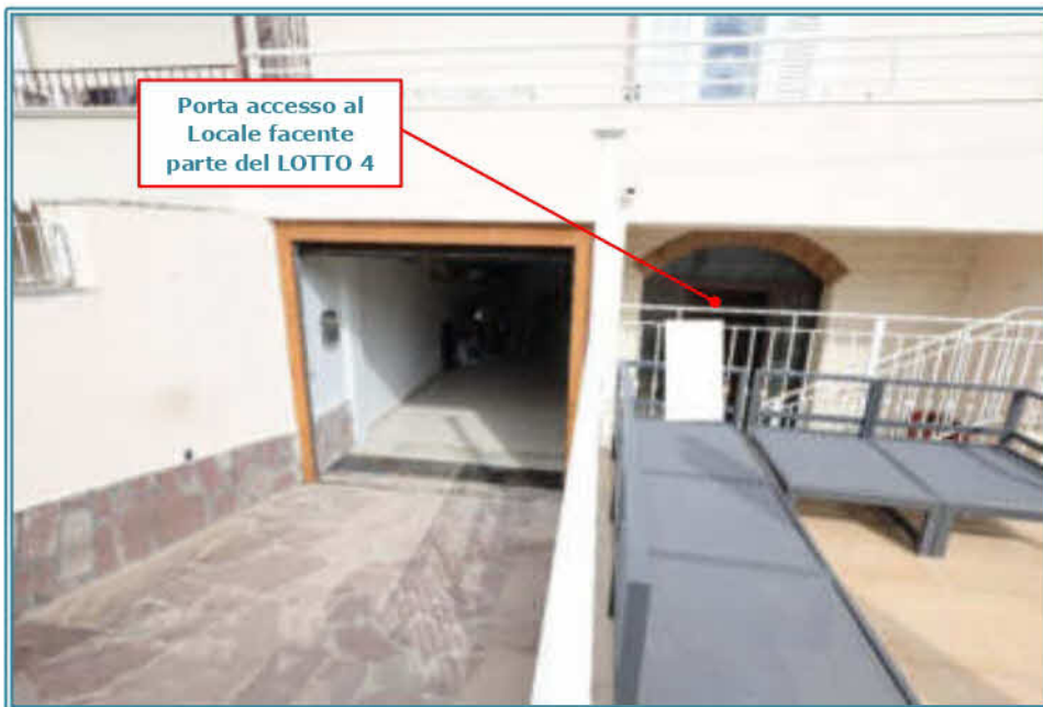
FOTO 45 - Rampa accesso al box
