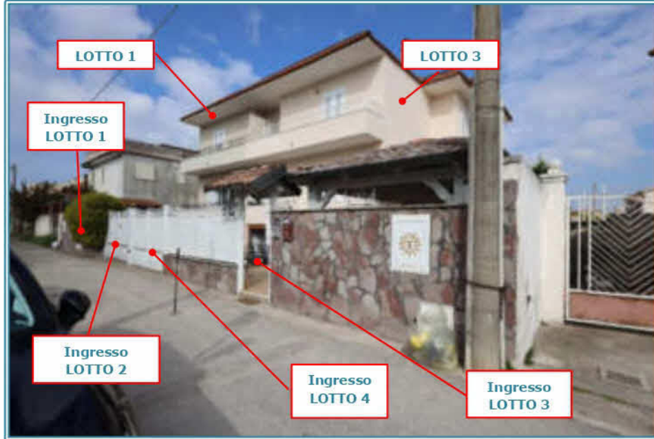
FOTO 1 - Ingressi al fabbricato da Via Perugia
