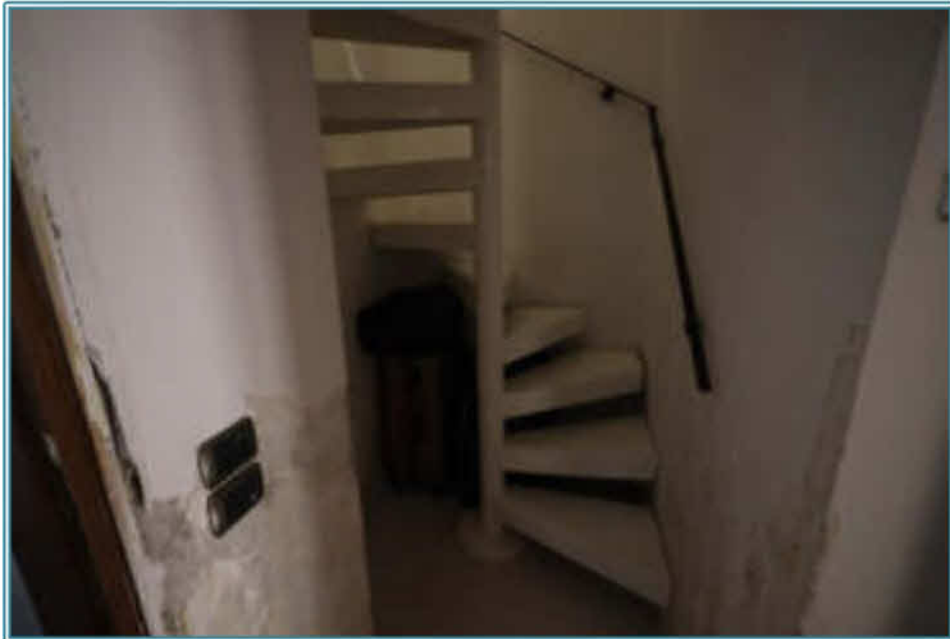
FOTO 51 - Vano Scala che collega al piano terra (LOTTO 3)
