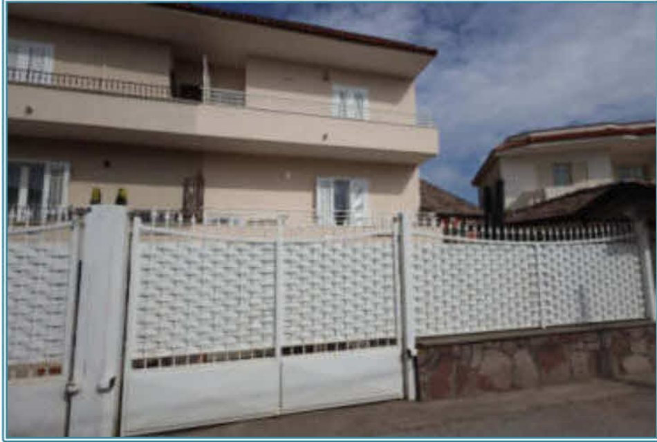
FOTO 44 - Cancelli di ingresso al LOTTO 4 da Via Perugia
