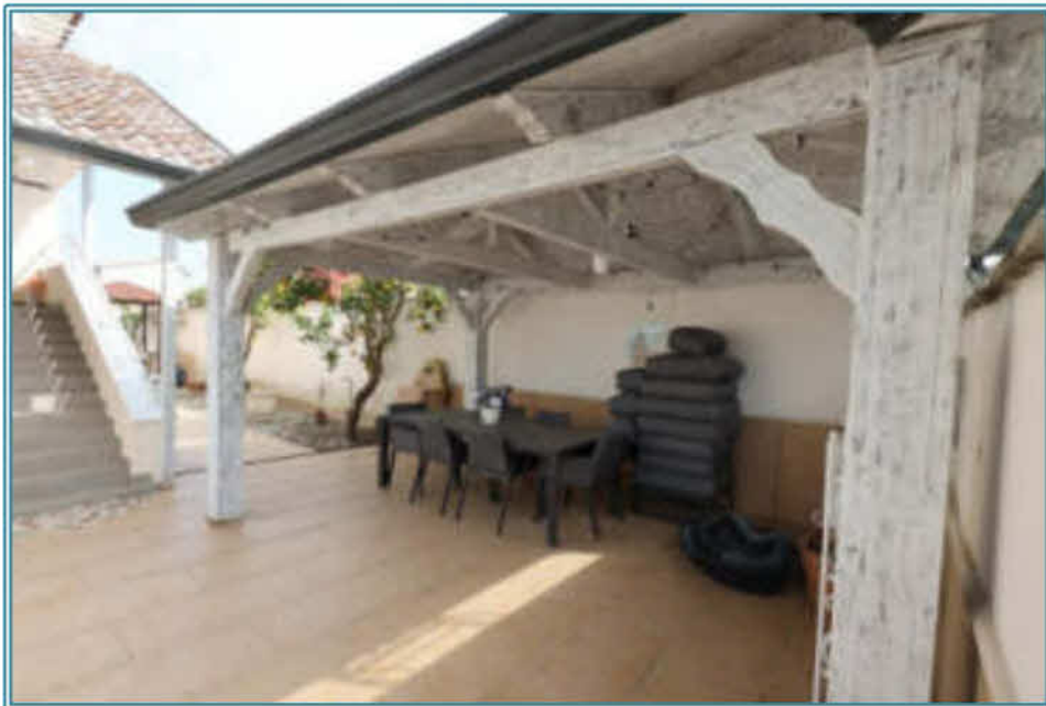
FOTO 28 - Tettoia realizzata sul cortile esterno (sub. 2)
