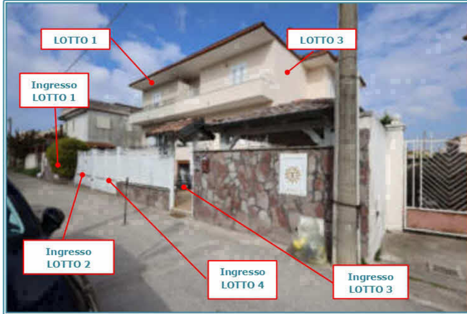
FOTO 1 - Ingressi al fabbricato da Via Perugia
