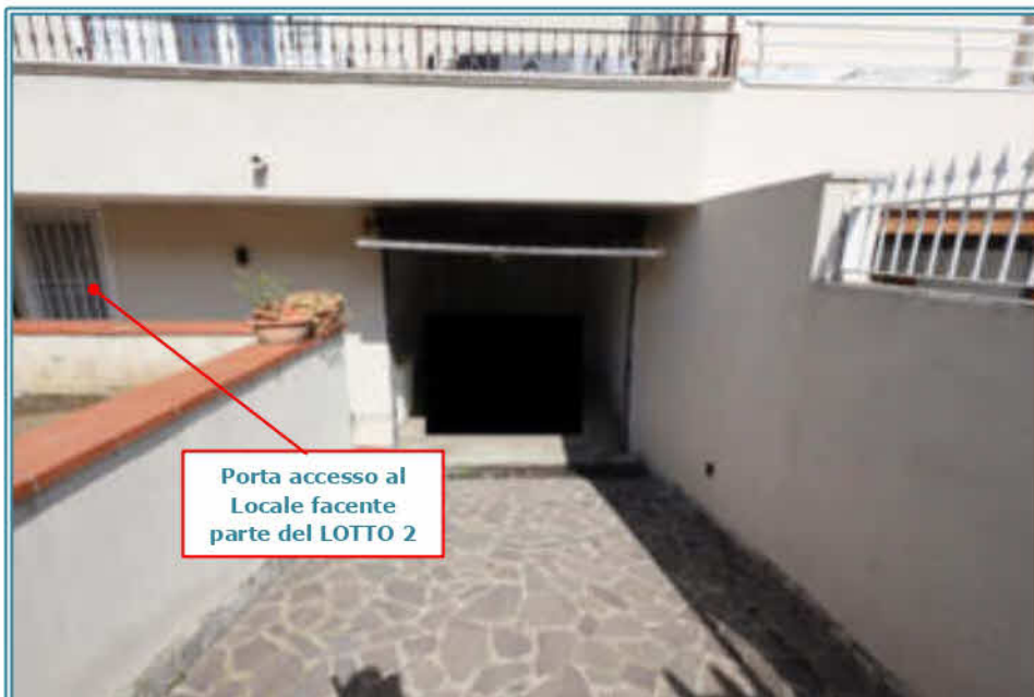
FOTO 20 - Rampa accesso al box
