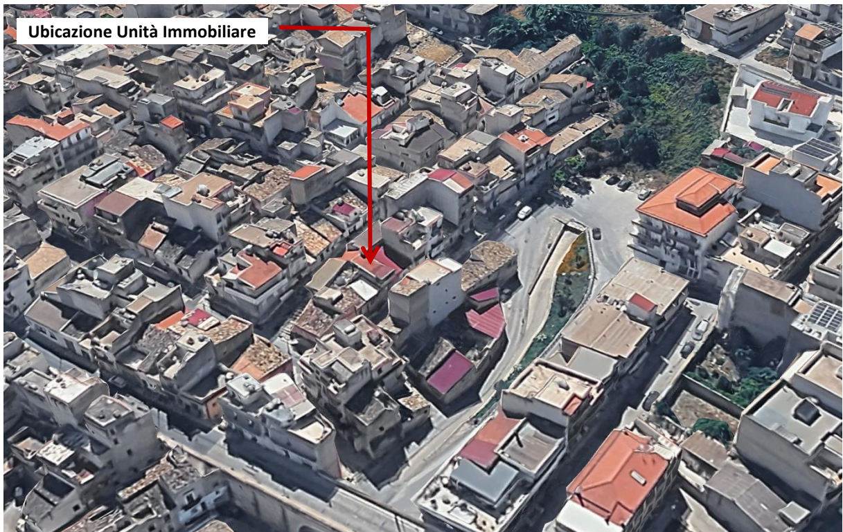
Figura n. 05 : Foto satellitare dell'unità immobiliare oggetto di stima
