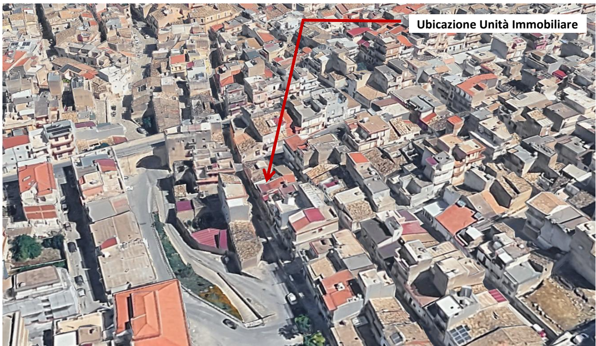
Figura n. 06 : Foto satellitare dell'unità immobiliare oggetto di stima
