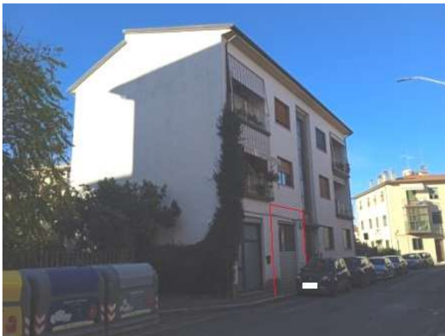
Foto 01 – prospetto laterale Sx/fronte
