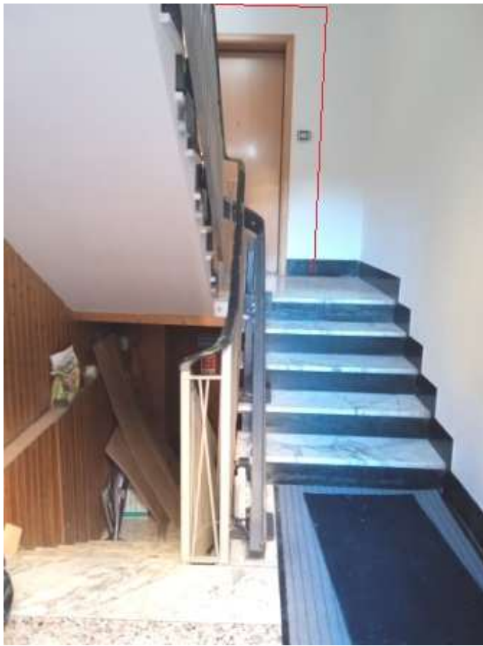
Foto 11 – vista vano scala comune
