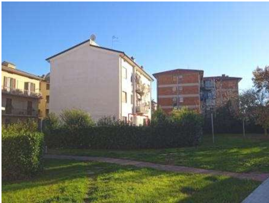
Foto 07 – prospetto laterale Dx/retro
