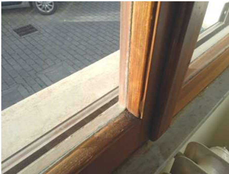
Foto 24 – interno Sub.24 (particolare serramento finestra)
