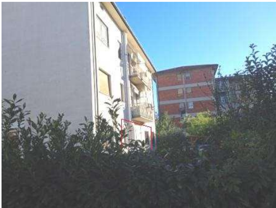
Foto 08 – prospetto laterale Dx/retro
