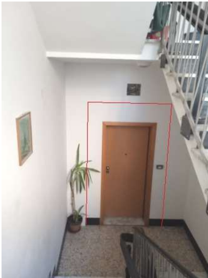
Foto 12 – vista vano scala comune
