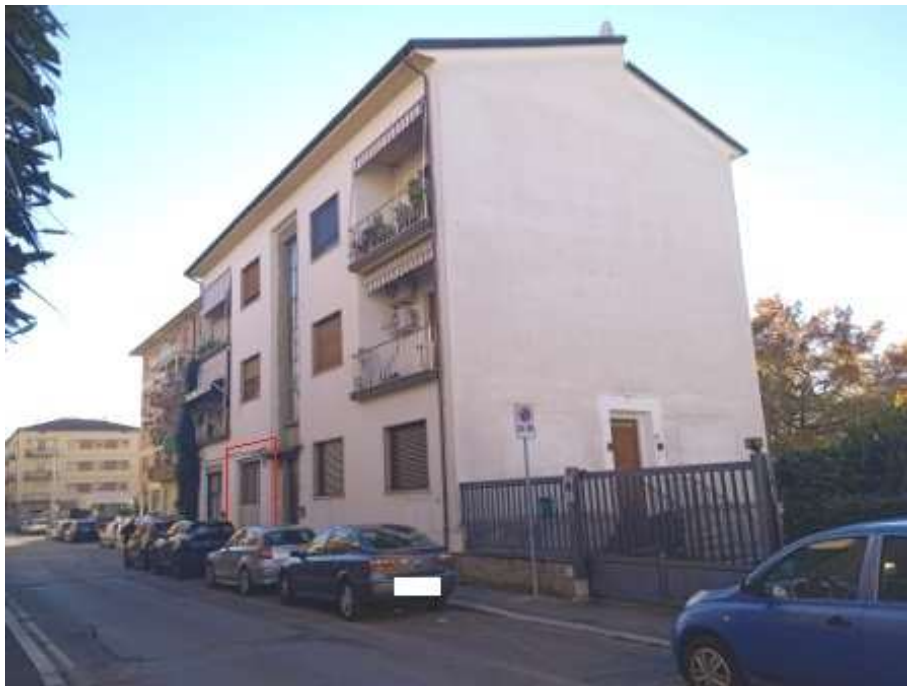
Foto 05 – prospetto fronte/laterale Dx
