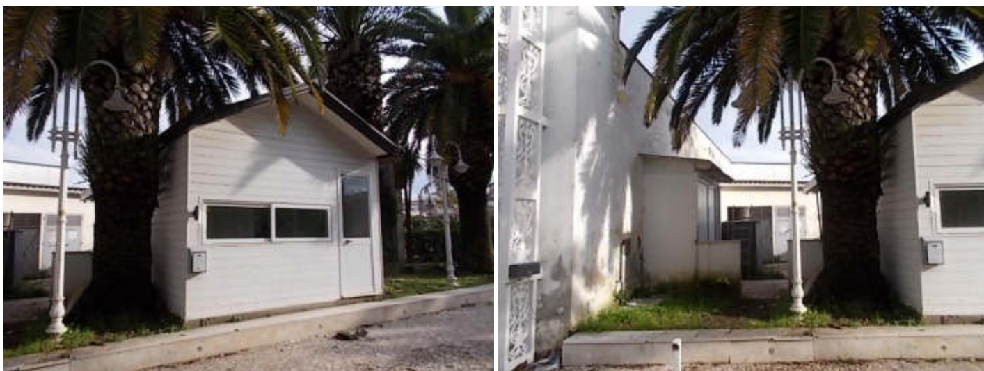
portineria e locali tecnologici posti a destra del cancello d'ingresso
