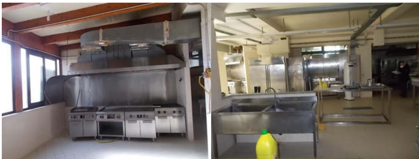
cucina e zona montacarichi
