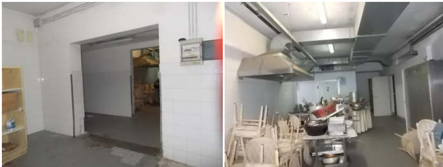
viste locali di servizio
