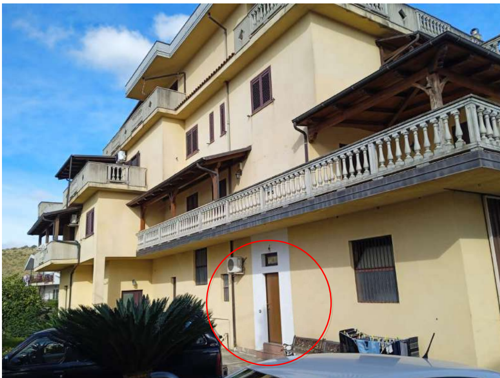
Foto n°2: Altro ingresso esterno al magazzino
