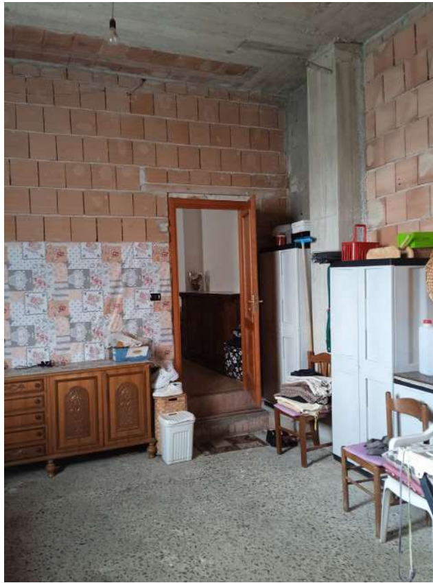
Foto n°6 e n°7: Locale magazzino
