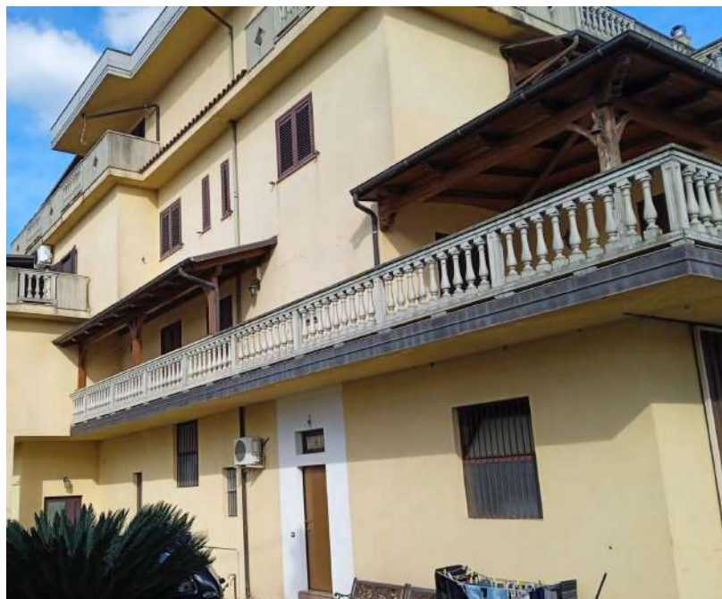
Foto n°11 e n°12: Particolare delle 3 tettoie in legno a copertura del terrazzo
