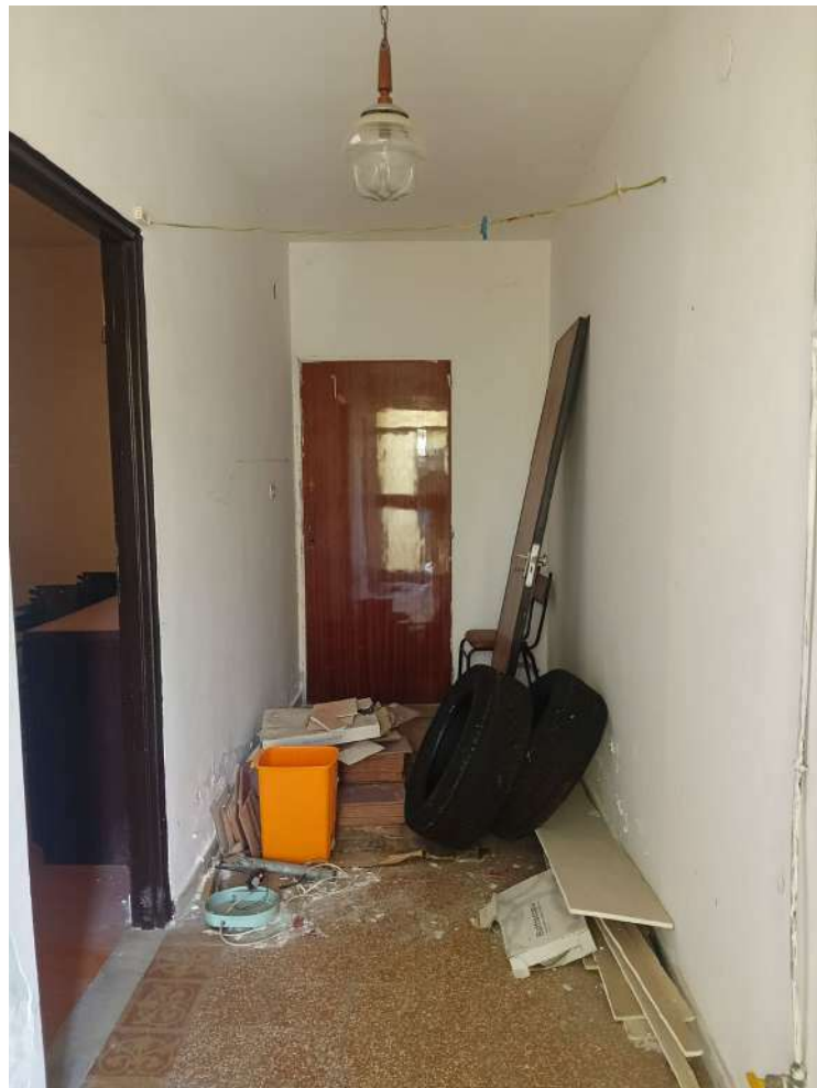
Foto n°9: Particolare dell'interno – corridoio d'ingresso
