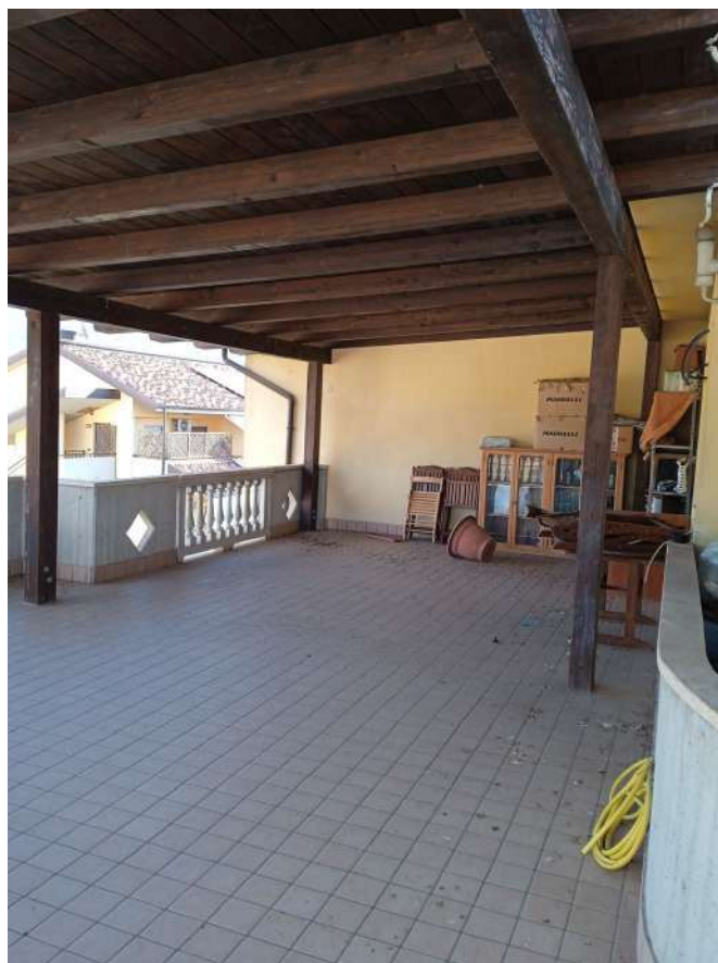
Foto n°15: Particolare della tettoia esterna a copertura del terrazzo del piano secondo
