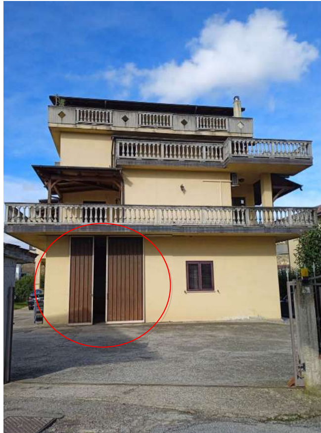
Foto n°1: Particolare evidenziato dell'ingresso esterno al magazzino
