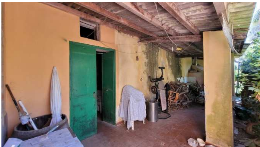
Veranda antistante il locale magazzino p.t.
