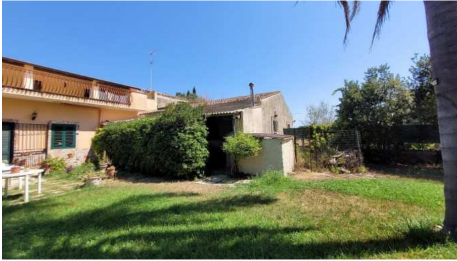
Vista Nord-Est del magazzino
