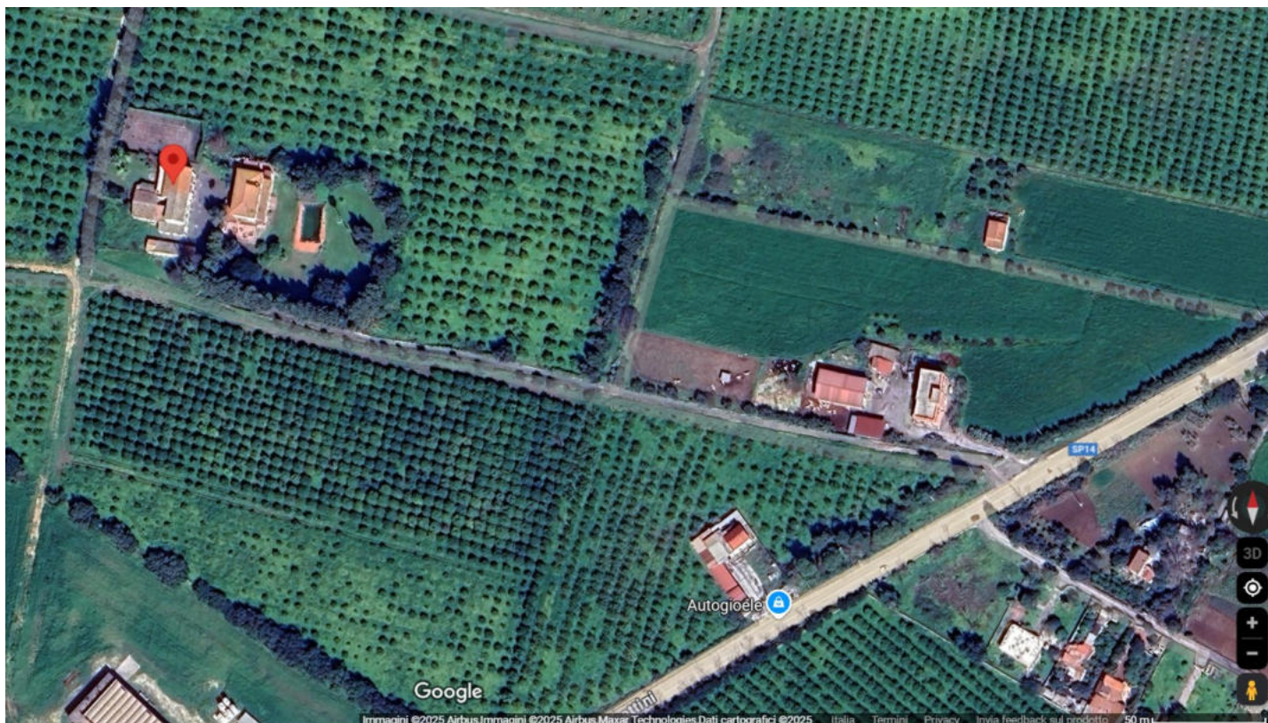
Vista aerea del fabbricato (F.104 P.Illa 17/2)
