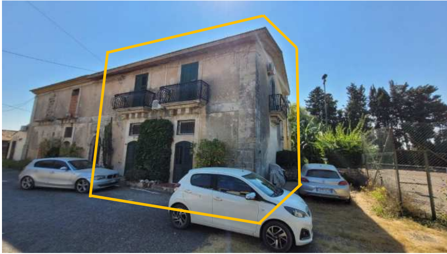
Vista Nord-Est del fabbricato
