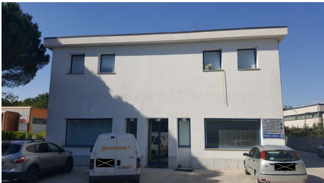
Foto 1 – vista frontale del capannone
