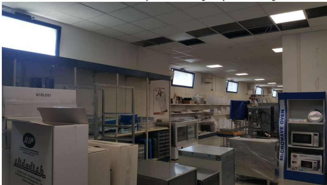
Foto 15 – 16 - 17 viste del piano terra e degli impianti tecnologici
