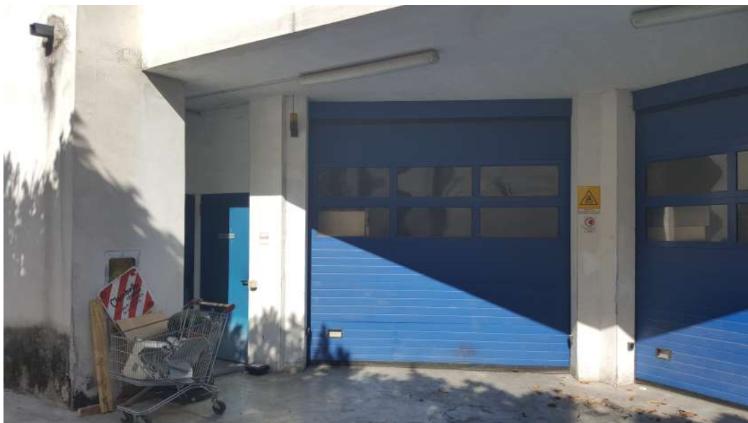
Foto 7: lato ovest, particolare accesso al piano interrato
