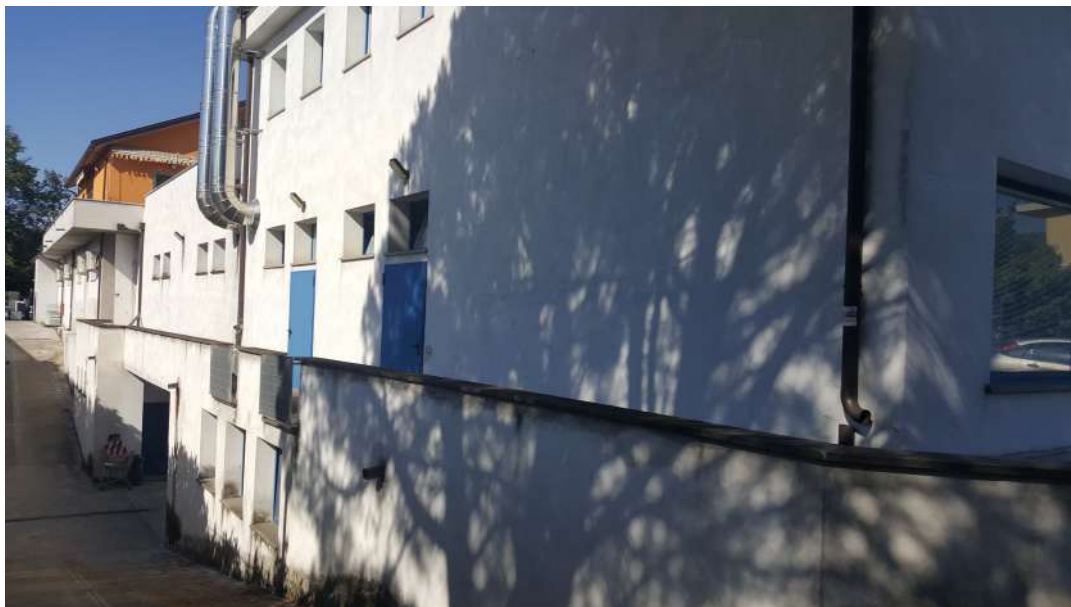
Foto 6: vista lato ovest
