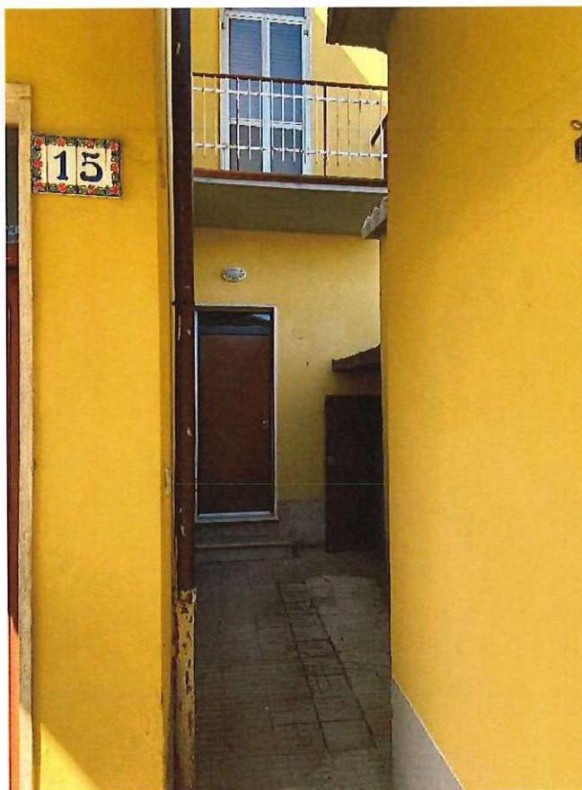
Foto n.5 - foto esterna lato serbatoio e c.t.
