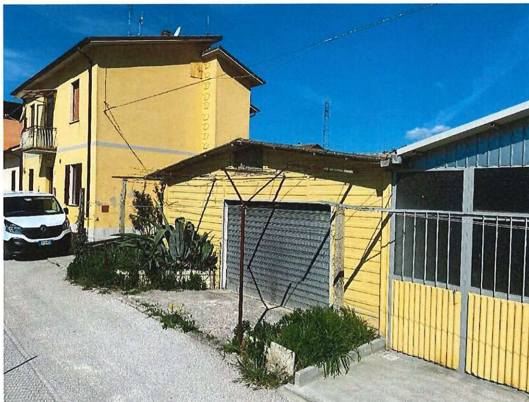
Foto n.2 - foto esterna lato garage e abitazione
