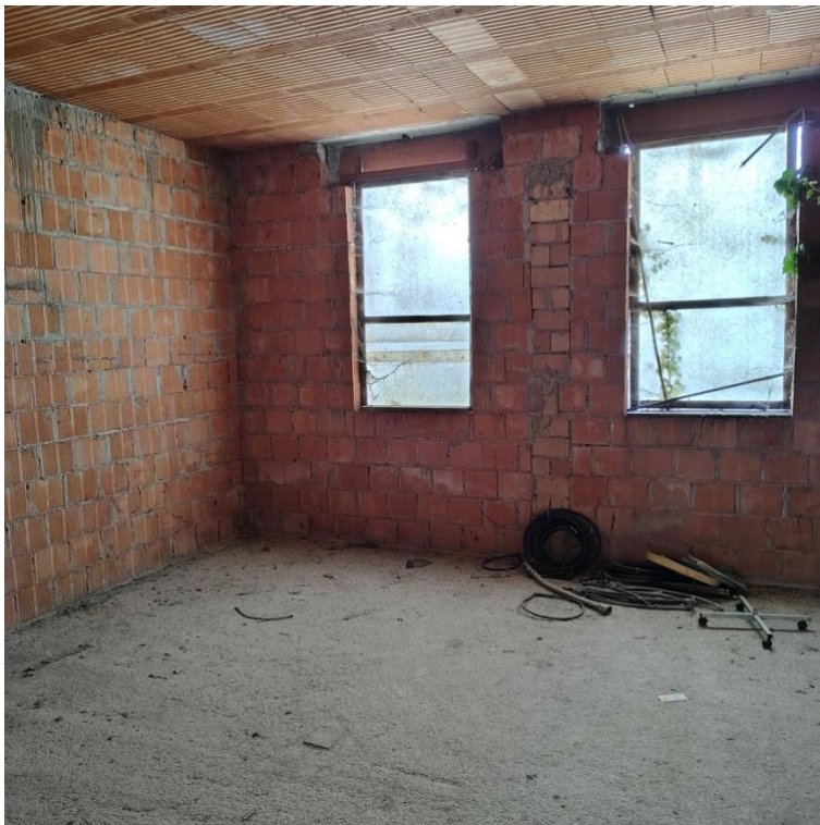
27 - lotto 1 Corpo C ripostiglio p.1
