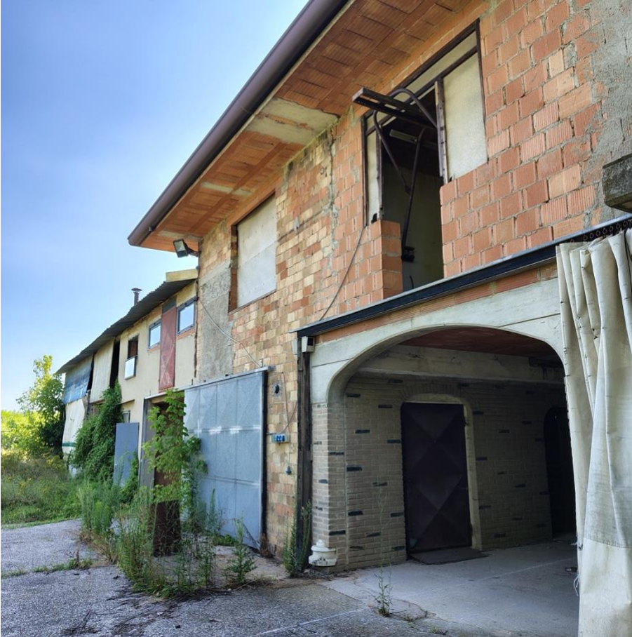
5 - lotto 1 in primo piano al p.t. a dx. accesso al Corpo B , sopra al piano 1 e in secondo piano corpo C
