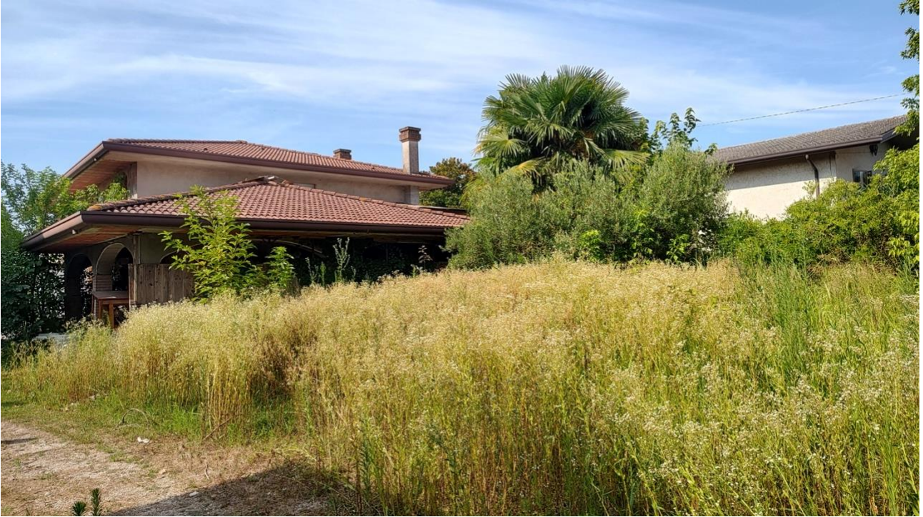
1 – lotto 1 Corpo A fabbricato residenziale in costruzione, giardino frapposto tra il fabbricato e Via Lova
