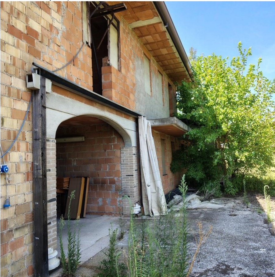
4 - lotto 1 in primo piano al p.t. corpo B , sopra al piano 1 corpo C , all'estremità a dx del volume corpo A
