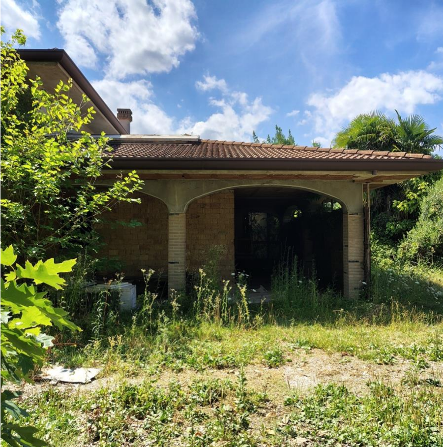
3 - lotto 1 Corpo A portico
