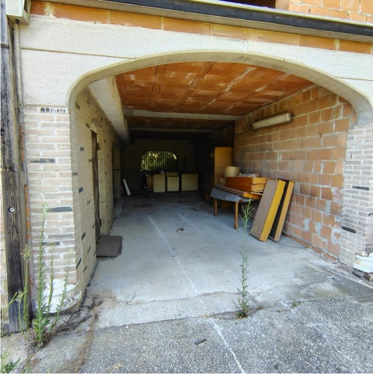
16 - lotto 1 Corpo B autorimessa, vista dallo scoperto comune
