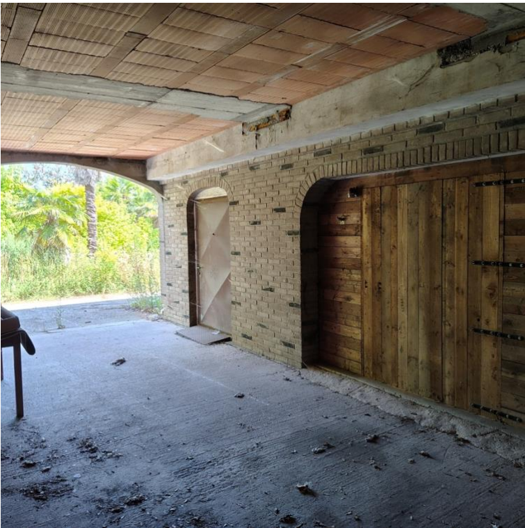
17 - lotto 1 Corpo B autorimessa
